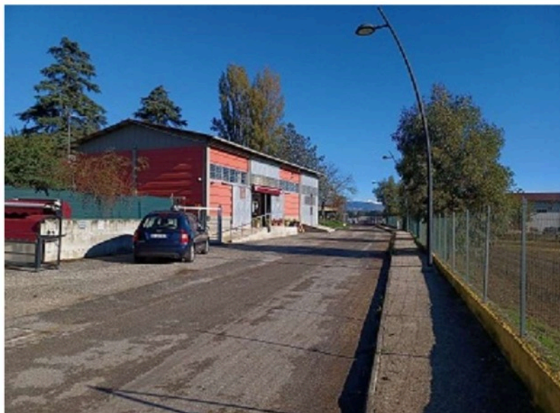
FOTO 1 – Lotto n. 1 – Capannone artigianale in Colferro
