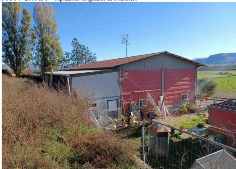
FOTO 4- Lotto n. 1 – Capannone artigianale in Colferro
