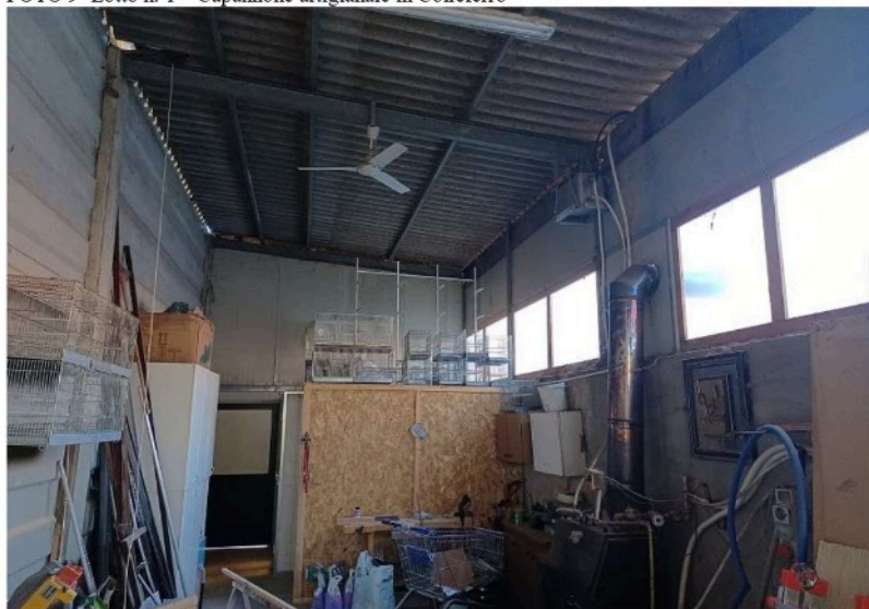
FOTO 10- Lotto n. 1 – Capannone artigianale in Collesferro
