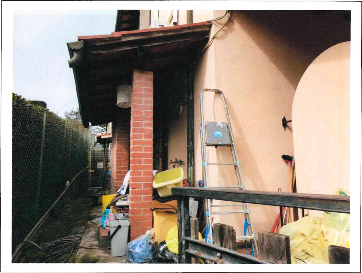
FOTO 15: Centrale Termica e piccola Tettoia poste sulla facciata Sud della Villetta.
