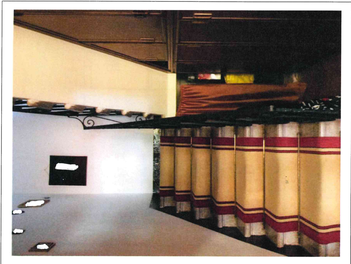
FOTO 26: Piano Terra - Vista della scala di accesso al Piano Primo.
