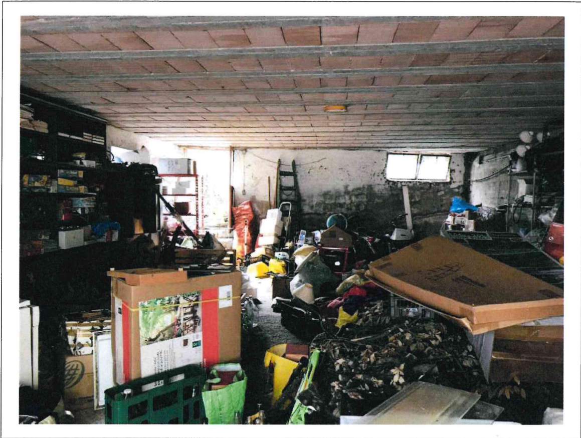
FOTO 9: Vista del Garage dal portone carrabile posto sul fronte Nord.
