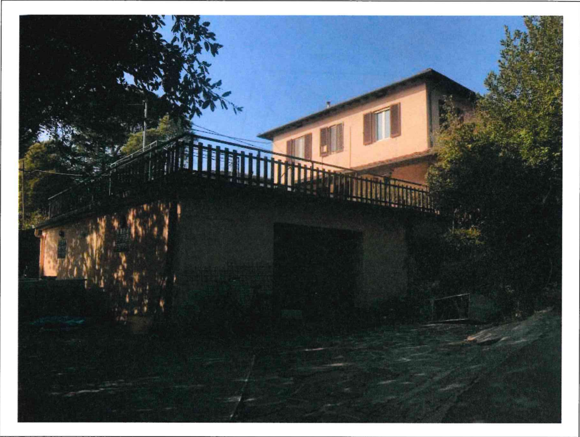
FOTO 3: Vista d'insieme del Garage e della Villetta bi-familiare, dalla zona di accesso alla strada privata.
