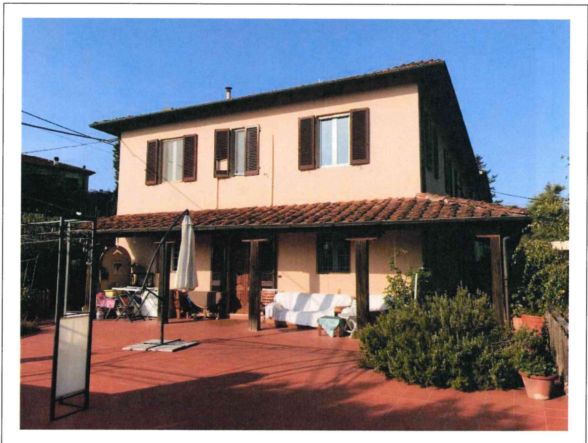
FOTO 14: Vista d'insieme della Villetta e della prospiciente Terrazza.
