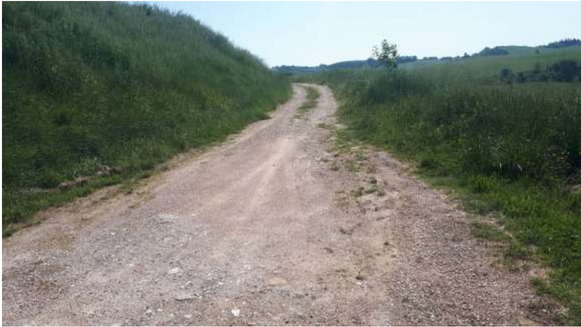
STRADA DI ACCESSO AL LOTTO 1 INSISTENTE SUL LOTTO 2
