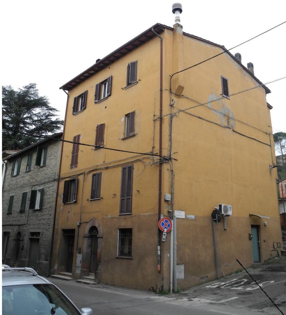
FOTO N. 1 – VISTA EDIFICIO LATO STRADA
