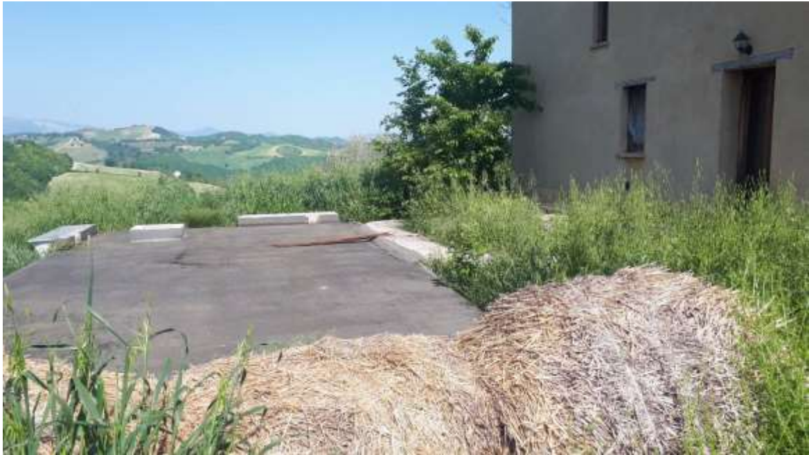
COPERTURA CENTRALE TERMICA
