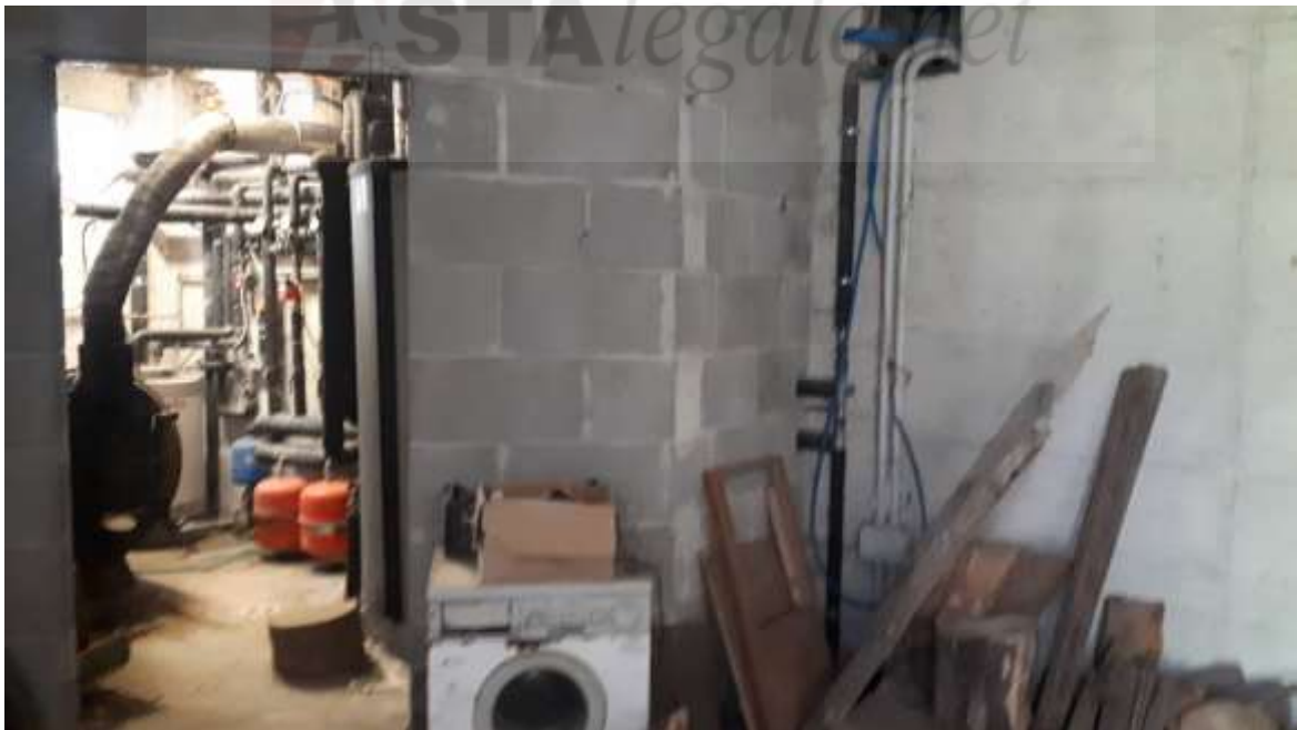
LOCALE CENTRALE TERMICA E DEPOSITO
