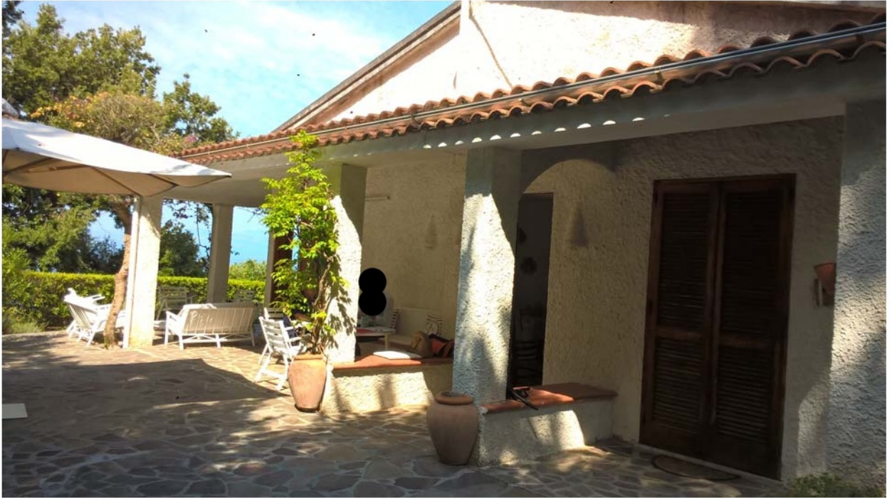
Foto n. 1 – prospetto sud lato ingresso
