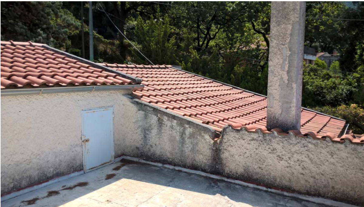
Foto n. 6 – lastrico solare con accesso alla soffitta
