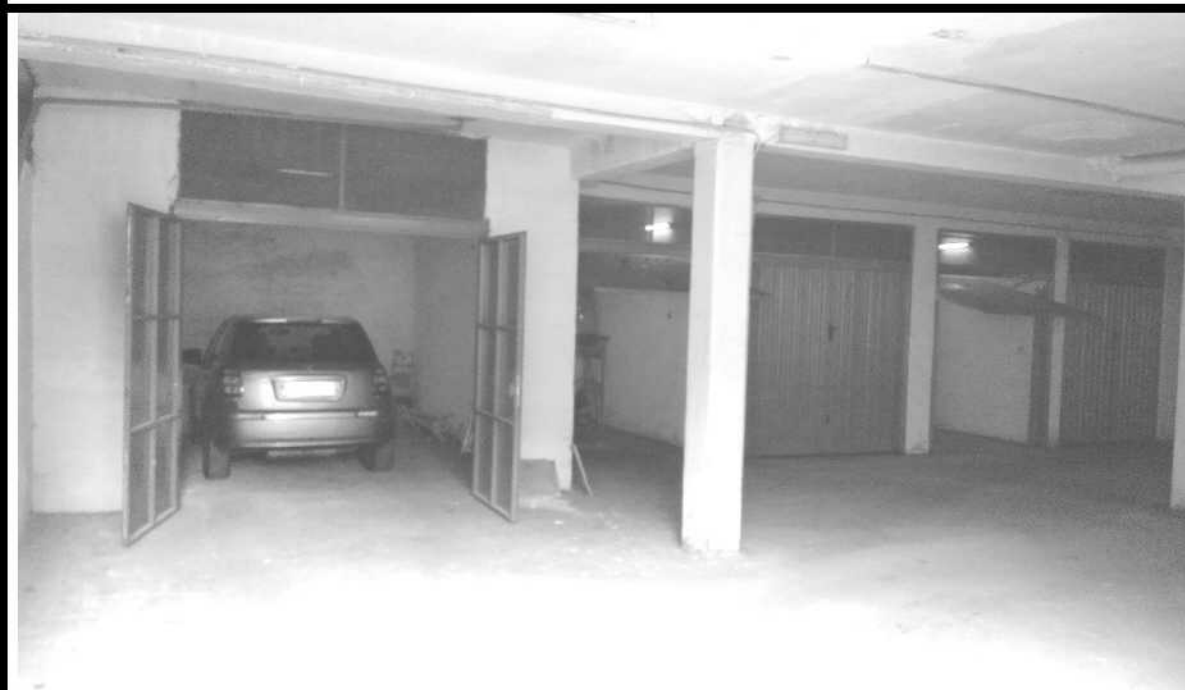
FOTO 106 – SPAZIO DI MANOVRA AUTORIMESSE – PIANO SEMINT.
