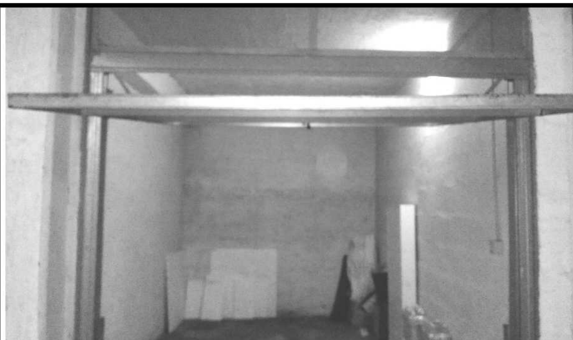
FOTO 143 – VISTA AUTORIMESSA – BOX 19 – PIANO SEMINT.
