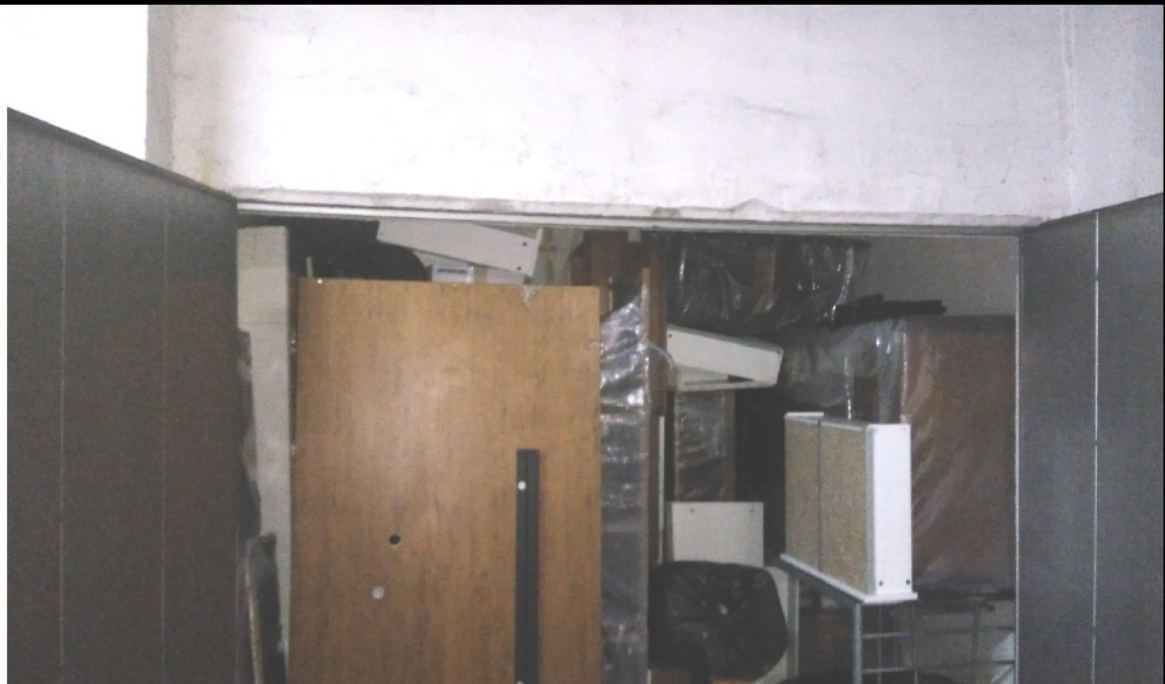
FOTO 137 – VISTA AUTORIMESSA – BOX 16 – PIANO SEMINT.
