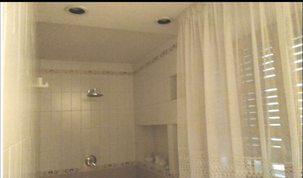
FOTO 91 – VISTA DEL BAGNO 1 – UNITA' 6 INT. 7 – SCALA A
