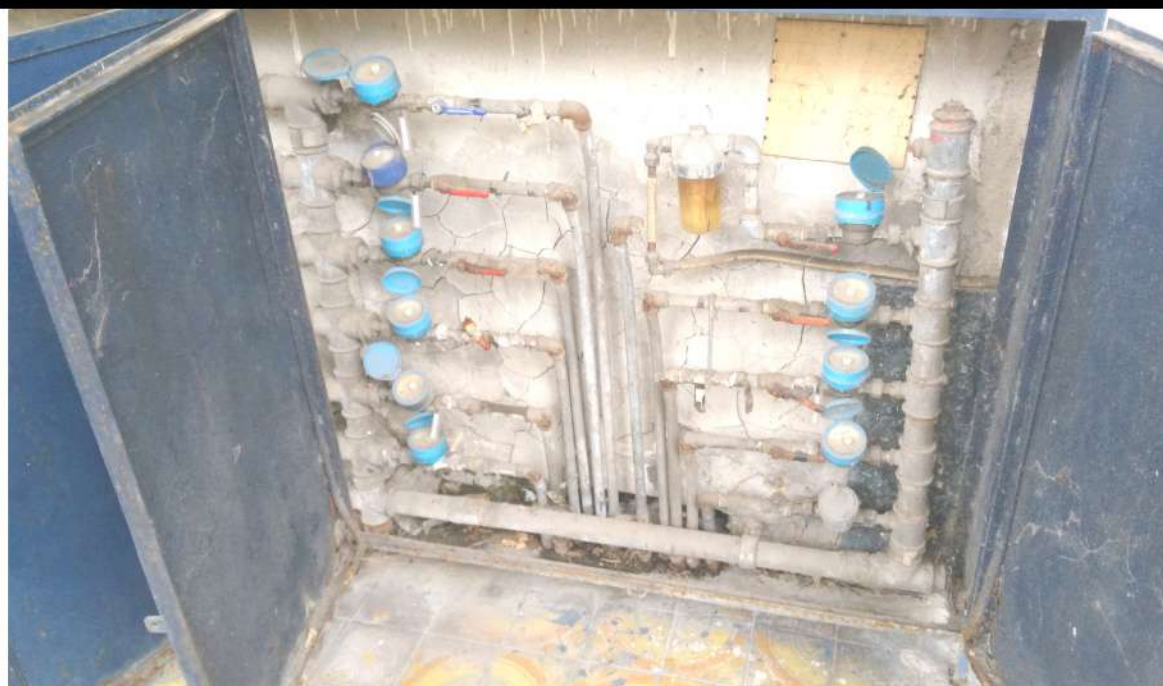
FOTO 104 – VISTA QUADRO MISURINI – UNITA DI VERTENZA
