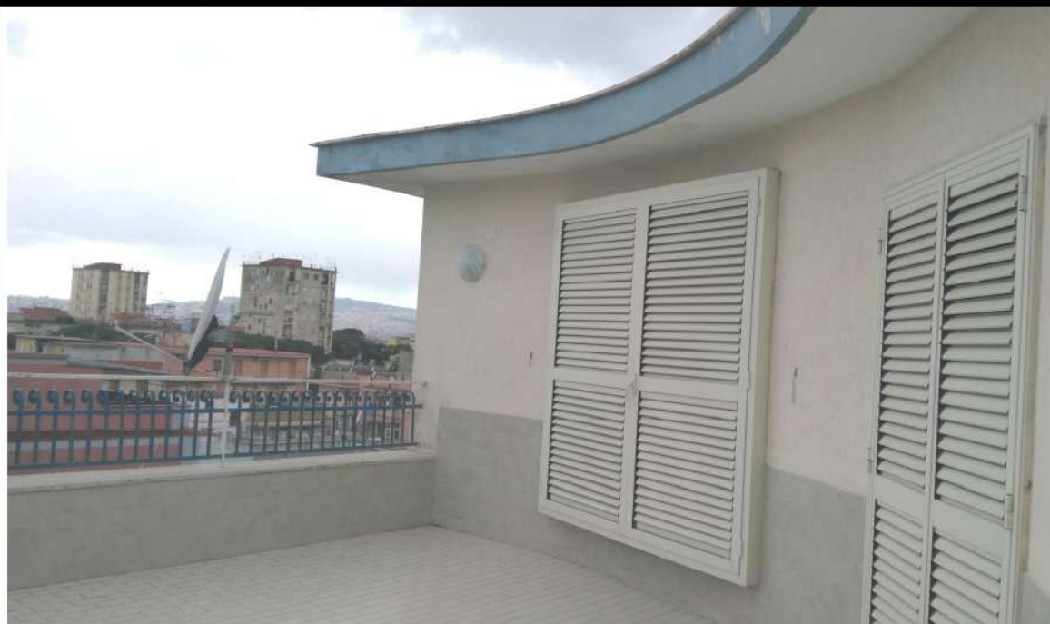
FOTO 95 – VISTA DEI TERRAZZI – UNITA' 6 INT. 7 – SCALA A
