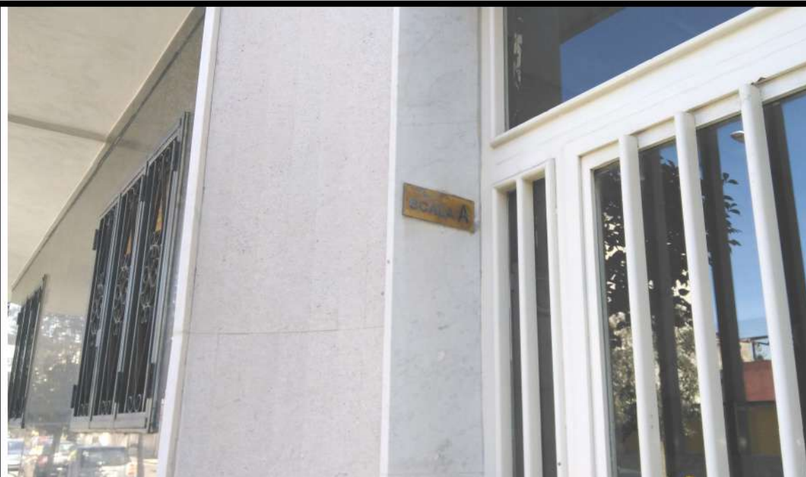
FOTO 3 – VISTA INGRESSO SCALA A SU STRADA
