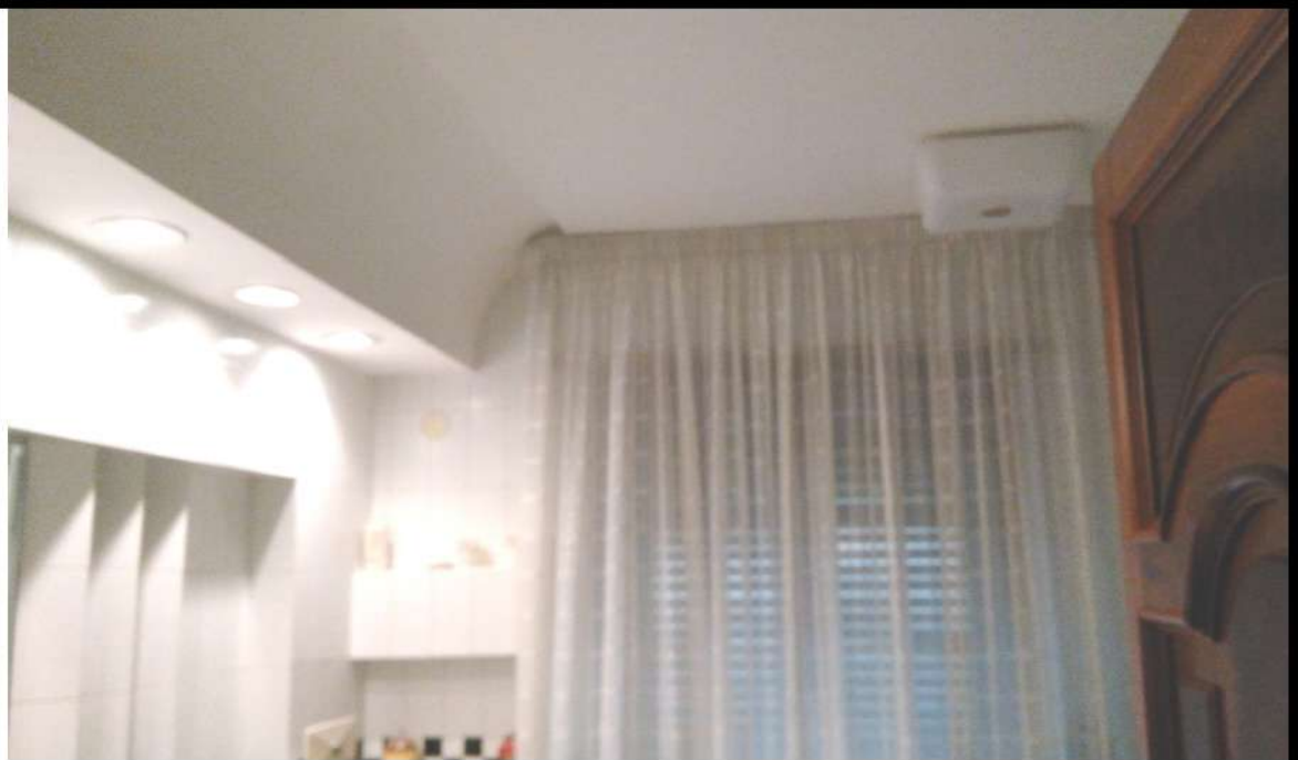
FOTO 93 – VISTA BAGNO 2 – UNITA' 6 INT. 7 – SCALA A
