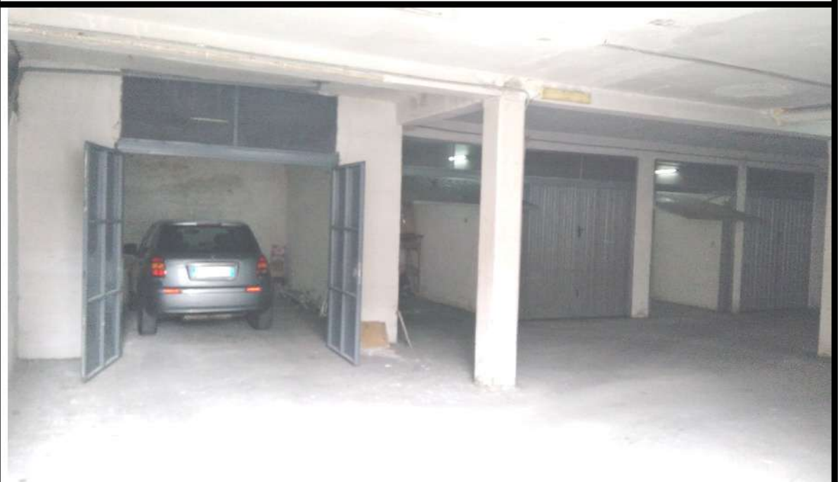
FOTO 106 – SPAZIO DI MANOVRA AUTORIMESSE – PIANO SEMINT.
