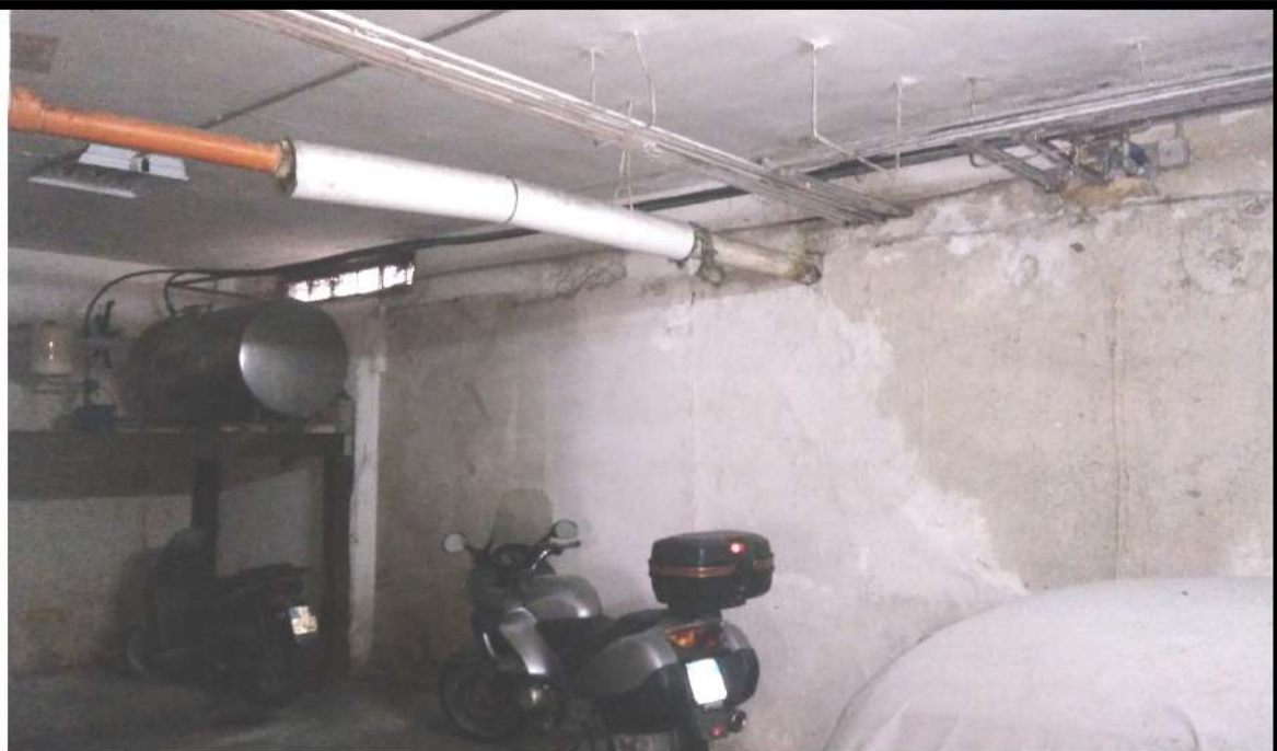
FOTO 121 – VISTA AUTORIMESSA – BOX 8 – PIANO SEMINT.
