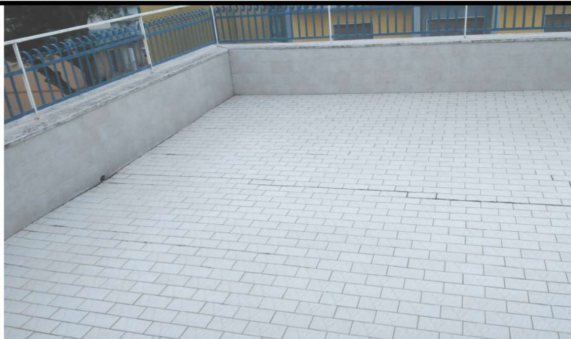
FOTO 96 – VISTA DEI TERRAZZI – UNITA' 6 INT. 7 – SCALA A
