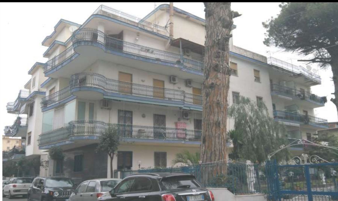
FOTO 1 – VISTA EDILIZIA DI VERTENZA – VIA VILLA BISIGNANO
