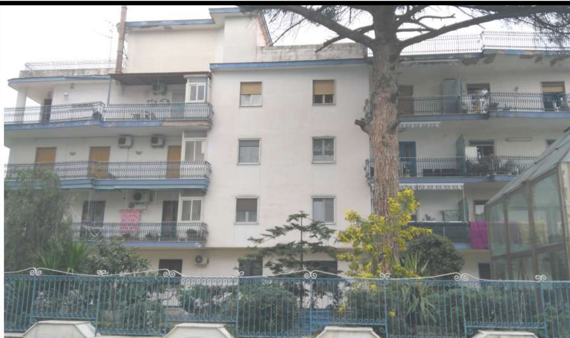
FOTO 2 – VISTA EDILIZIA DI VERTENZA – VIA VILLA BISIGNANO
