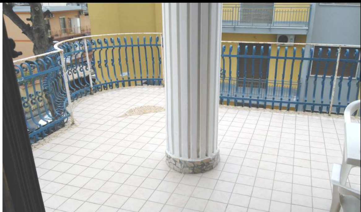
FOTO 82 – VISTA DEI BALCONI – UNITA' 6 INT. 7 – SCALA A
