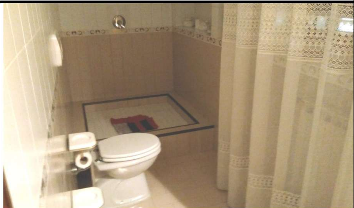
FOTO 92 – VISTA DEL BAGNO 1 – UNITA' 6 INT. 7 – SCALA A
