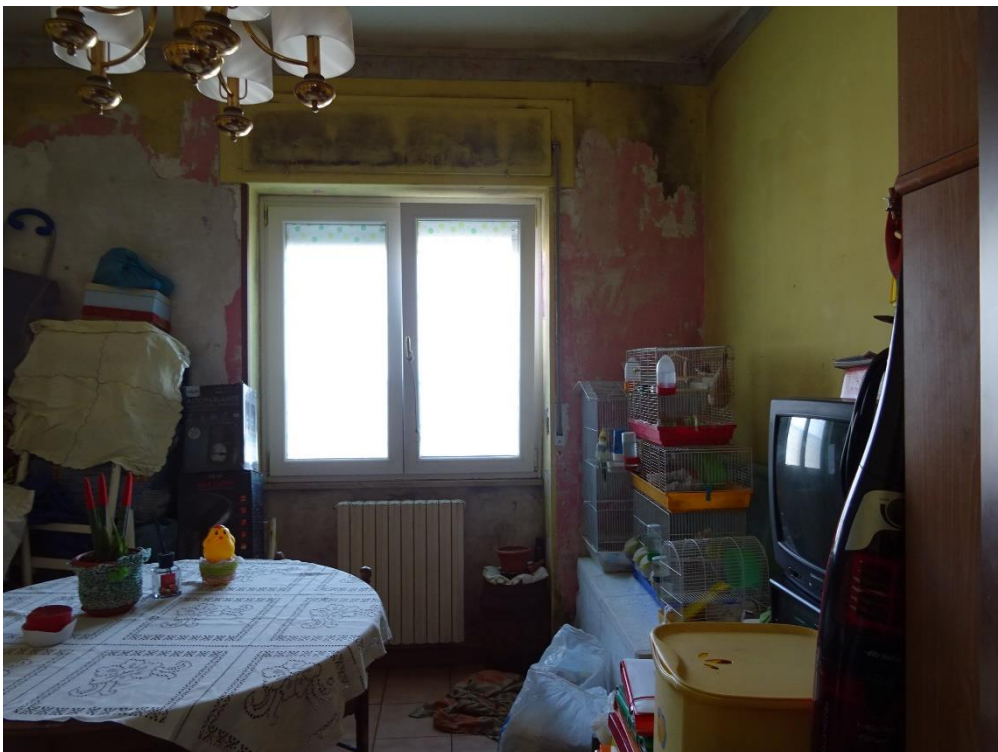
Foto n. 8: Camera Immobile San Severo NCEU Foglio 30 P.Ila 259 sub.33
