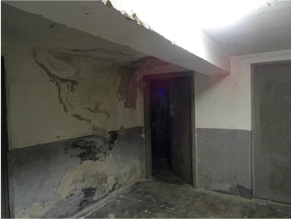
Foto n. 21: Ingresso cantina Immobile San Severo NCEU Foglio 30 P.Ila 259 sub.33
