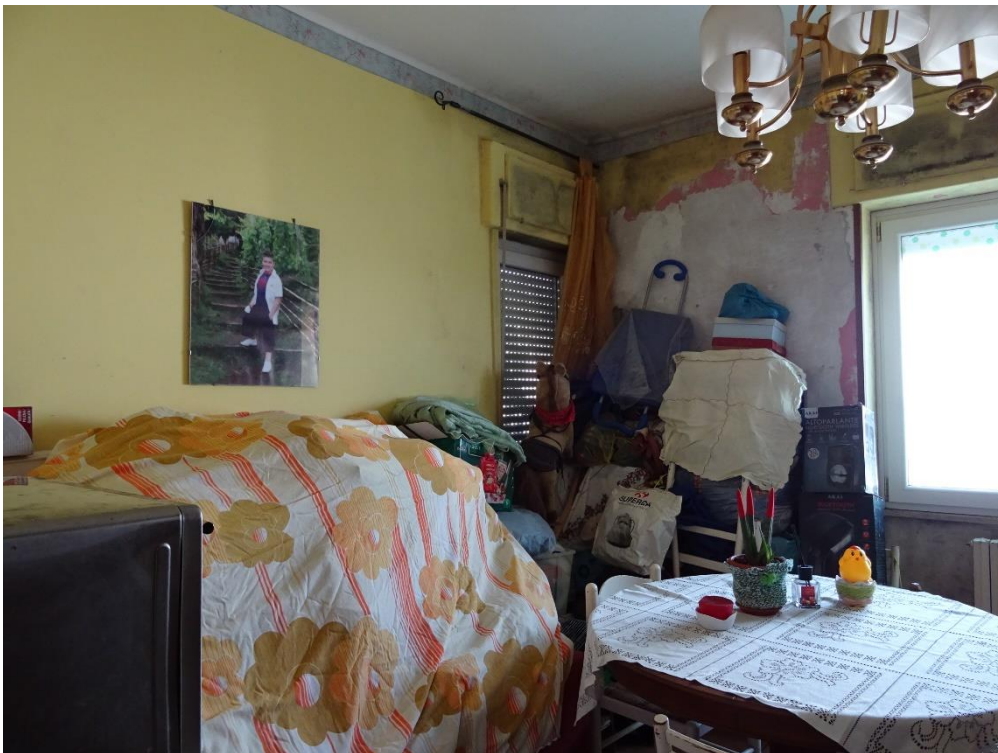
Foto n. 6: Camera Immobile San Severo NCEU Foglio 30 P.Ila 259 sub.33
