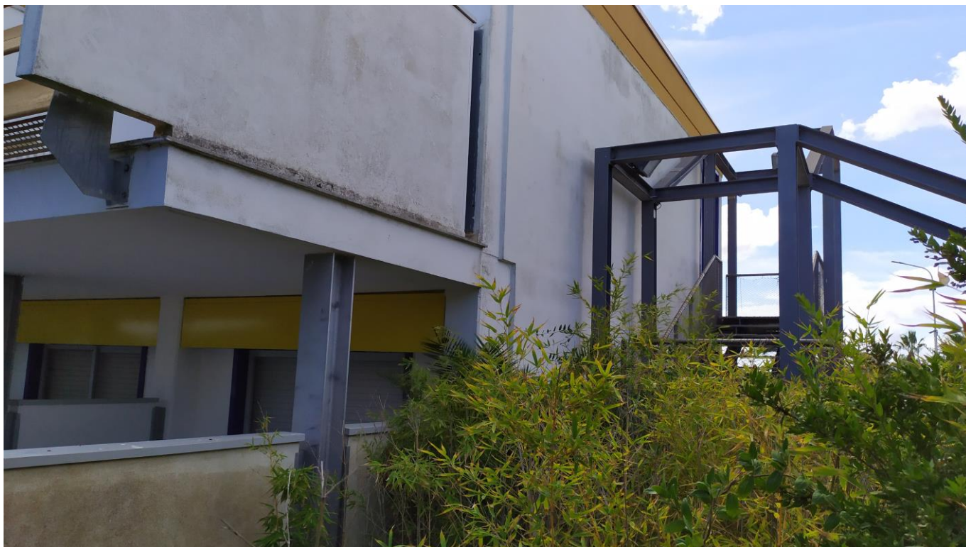
FOTO E.36: in evidenza, la scala di sicurezza esterna.
