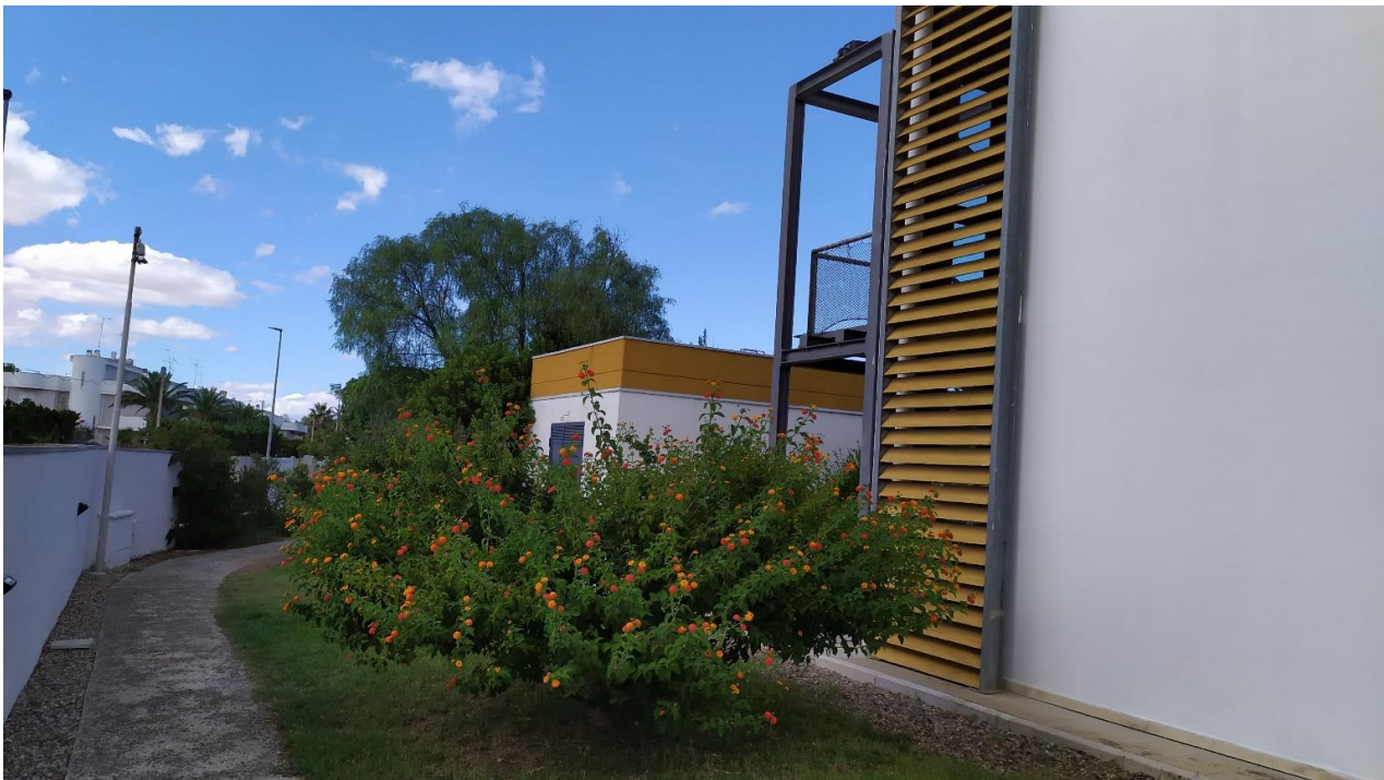
FOTO E.23: in evidenza, il patio antistante l'Hotel ed il locale centrale termica.
