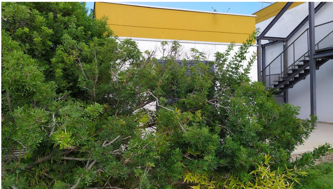
FOTO E.28: in evidenza, il patio antistante l'Hotel, la scala esterna di sicurezza ed il locale centrale termica.
