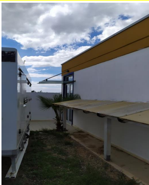
FOTO E.55: in evidenza, l'uscita di sicurezza in prossimità delle camere 1-2-3-4.
