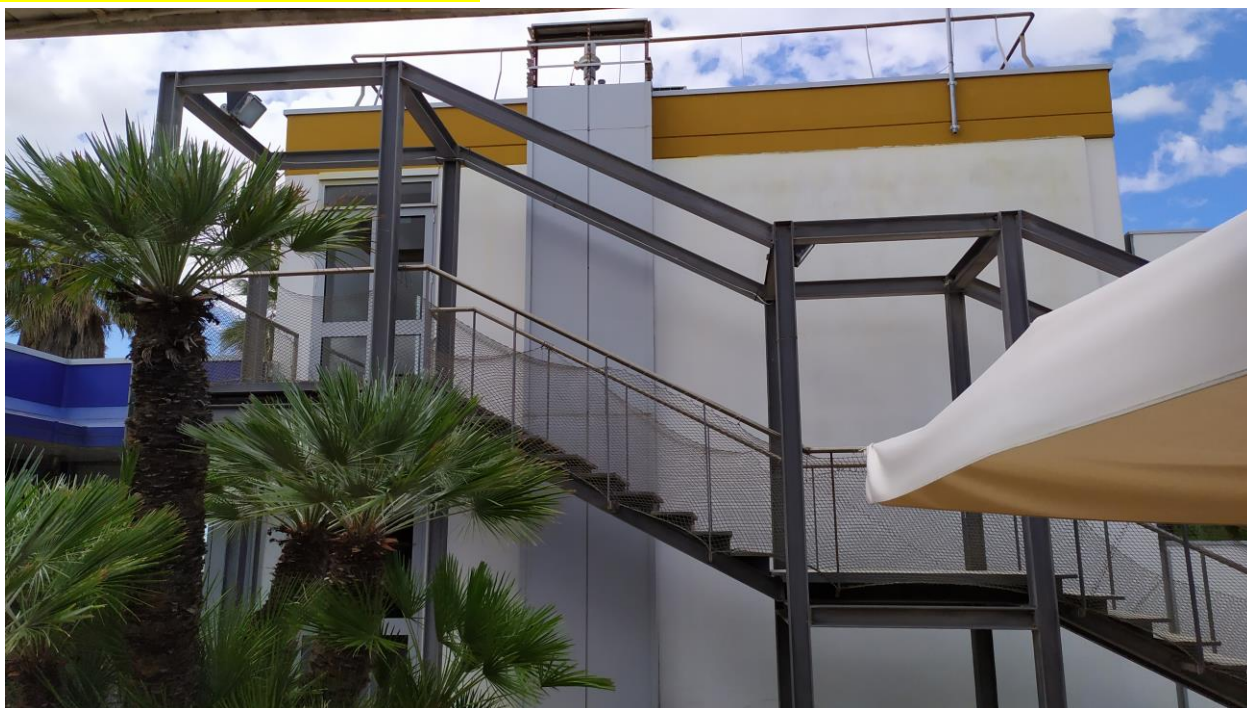
FOTO E.49: in evidenza, il giardino lato mare in prossimità dei tavoli annessi al bar, l'altra scala di sicurezza esterna.
