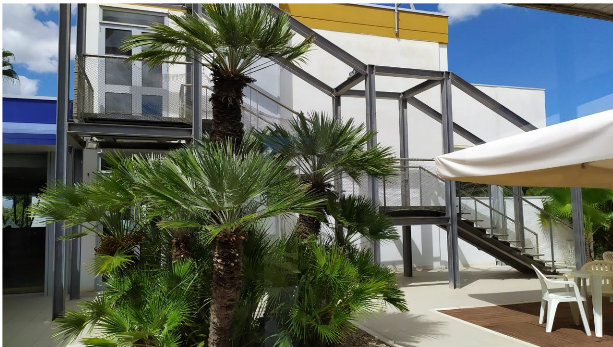
FOTO E.48: in evidenza, il giardino lato mare in prossimità dei tavoli annessi al bar, l'altra scala di sicurezza esterna.
