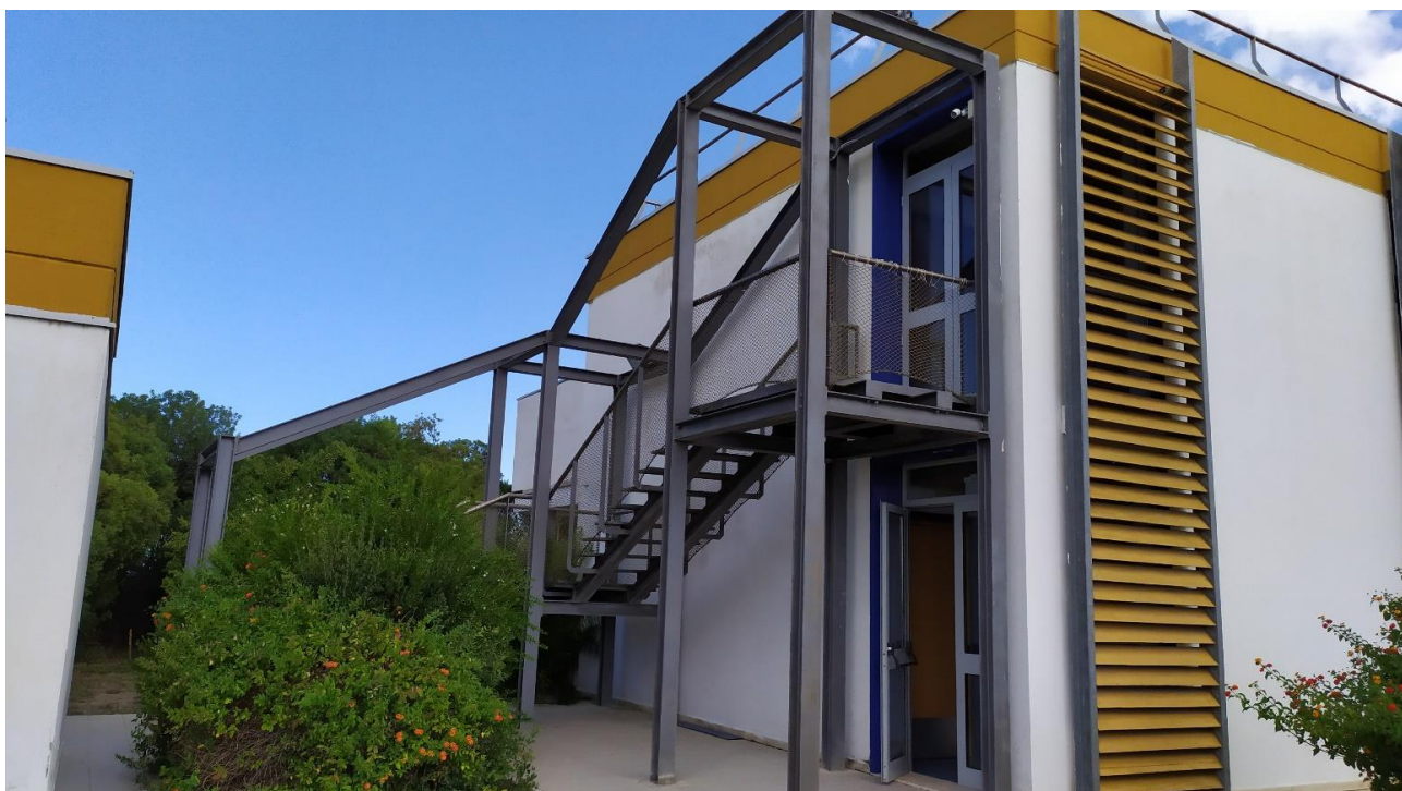
FOTO E.27: in evidenza, il patio antistante l'Hotel e la scala esterna di sicurezza.
