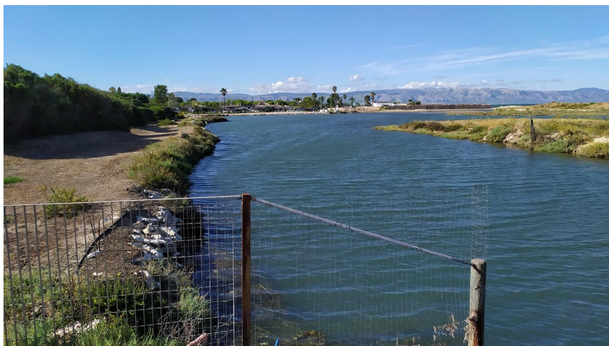
FOTO E.8: in evidenza, vista del giardino dell'Hotel lato mare (N.B.: una parte dell'area è occupata dalle acque).
