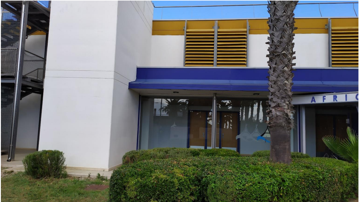
FOTO E.11: in evidenza, il patio nei pressi dell'ingresso all'Hotel.
