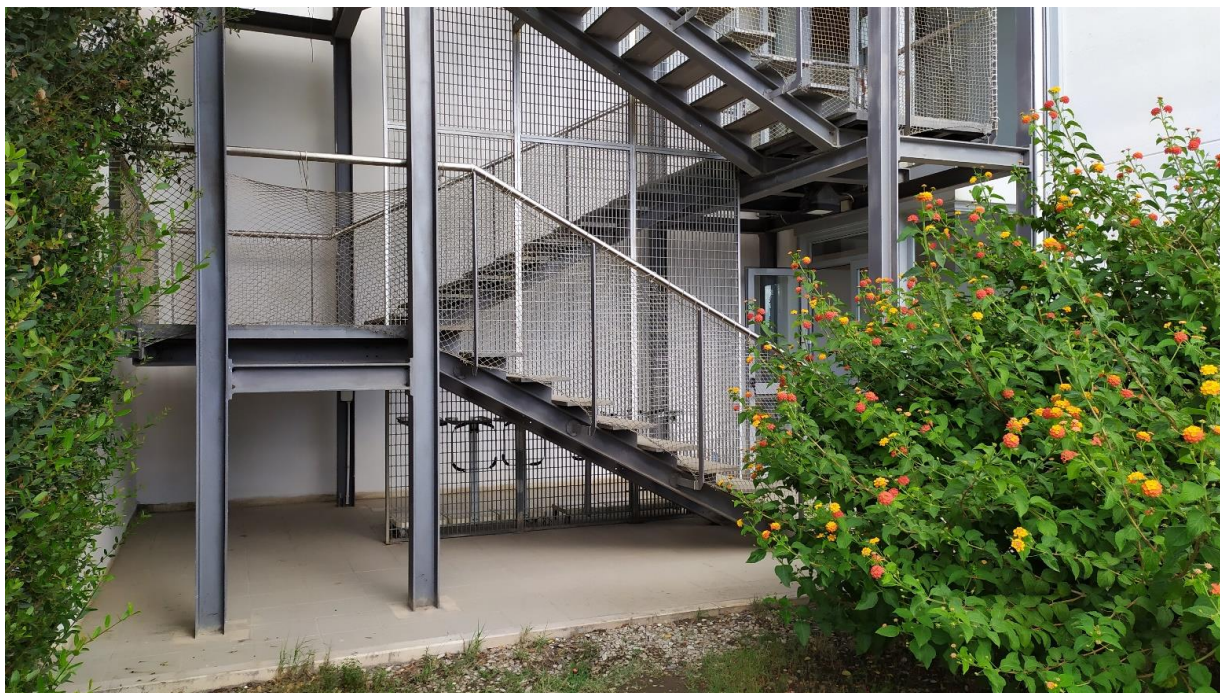
FOTO E.18: in evidenza, la scalinata esterna per l'accesso ai piani dell'Hotel, nonché di sicurezza.
