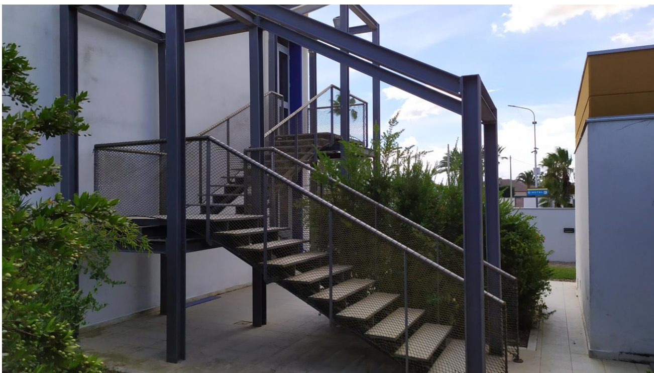
FOTO E.35: in evidenza, la scala di sicurezza esterna.
