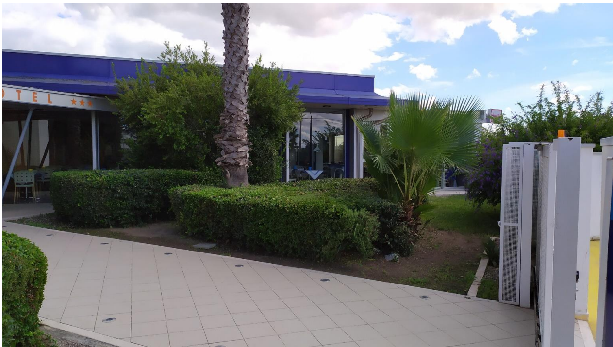
FOTO E.13: in evidenza, il patio nei pressi dell'ingresso all'Hotel.
