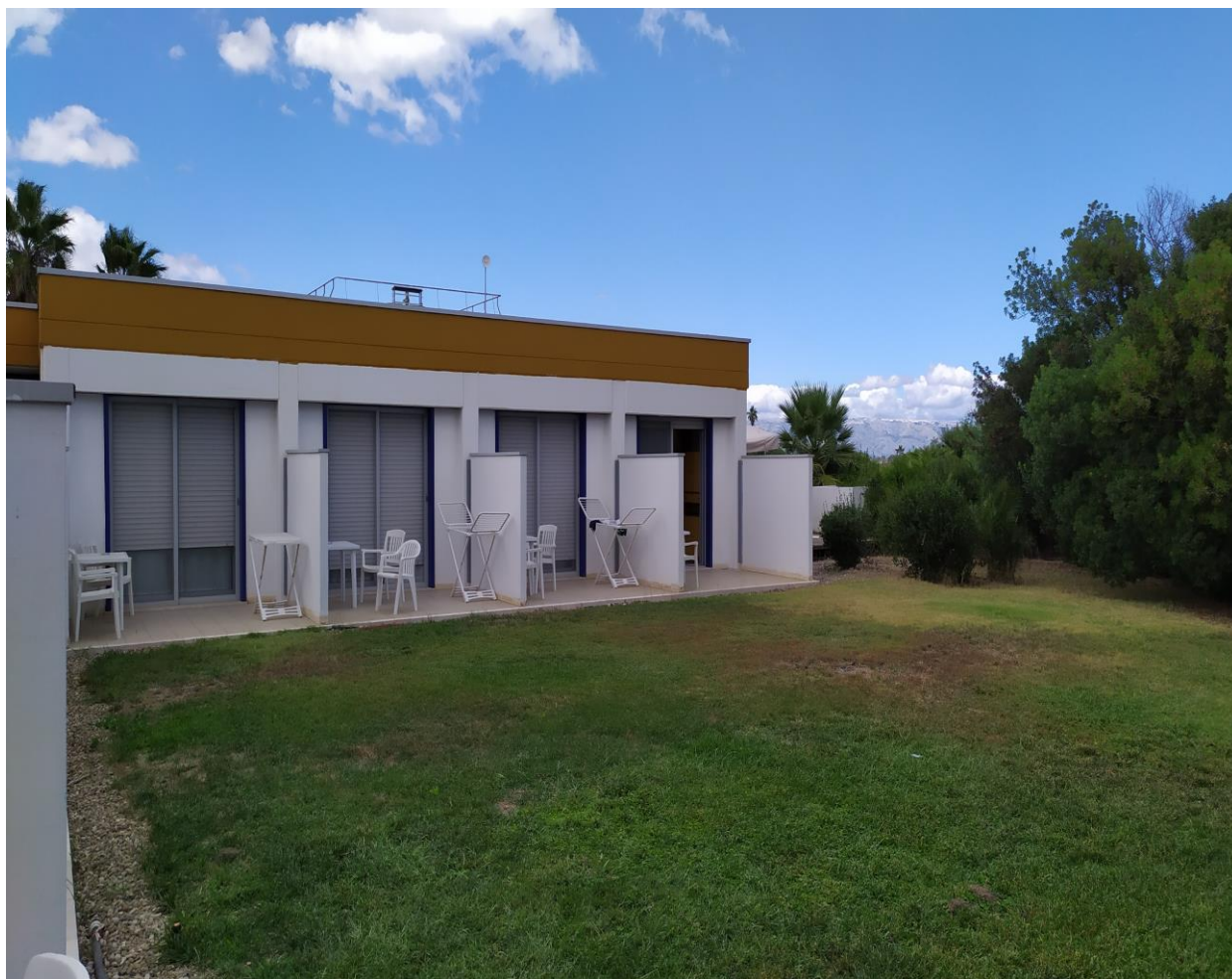
FOTO E.54: in evidenza, il giardino lato mare in prossimità delle camere 1-2-3-4 e 5-6-7-8.
