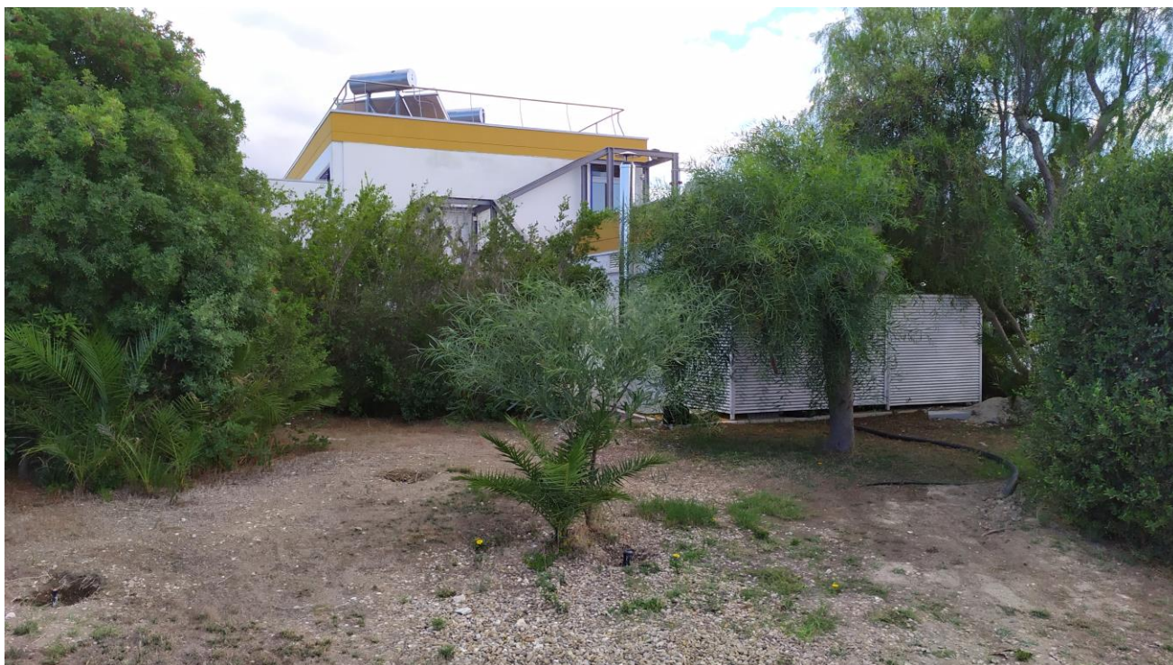
FOTO E.34: in evidenza, il giardino circostante l'Hotel, in secondo piano il vano tecnico per gli impianti d'autoclave e antincendio, la scala di sicurezza esterna.
