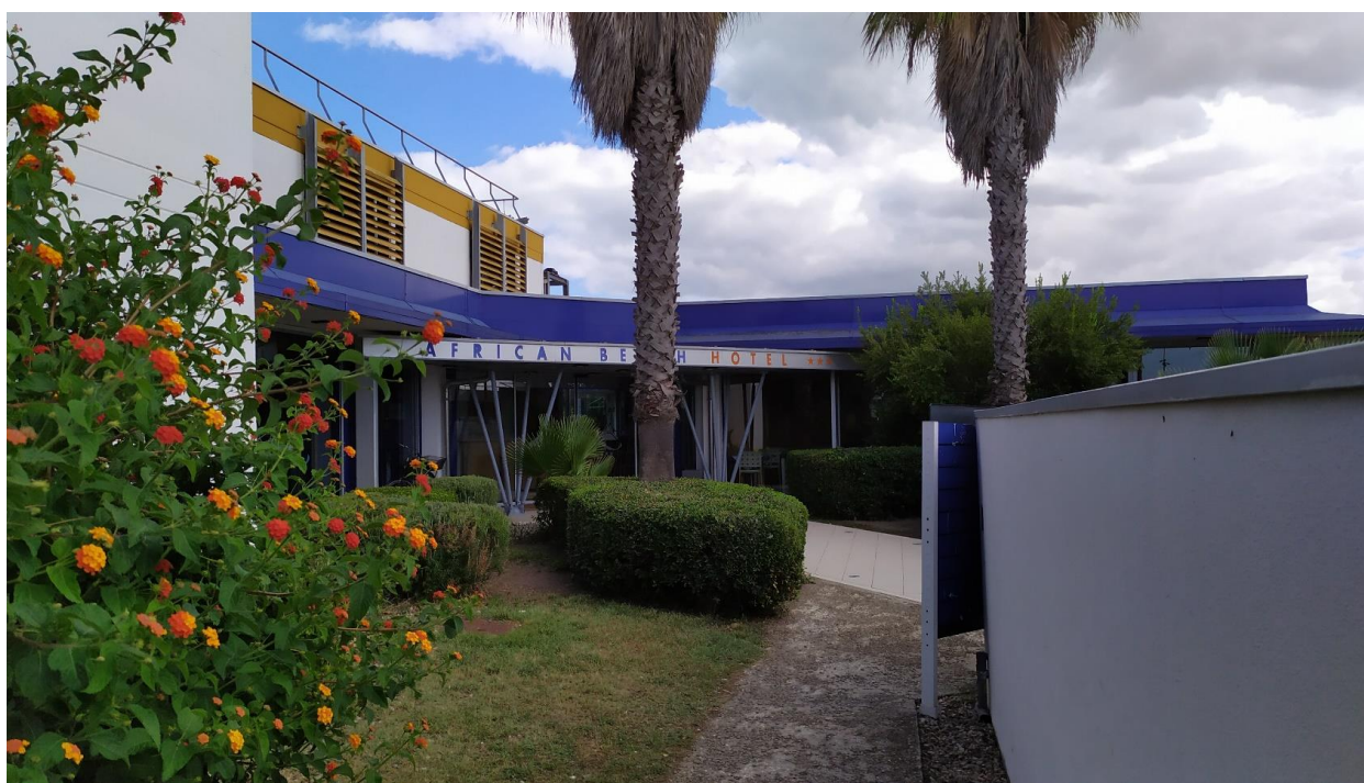
FOTO E.21: in evidenza, il patio nei pressi dell'ingresso all'Hotel.
