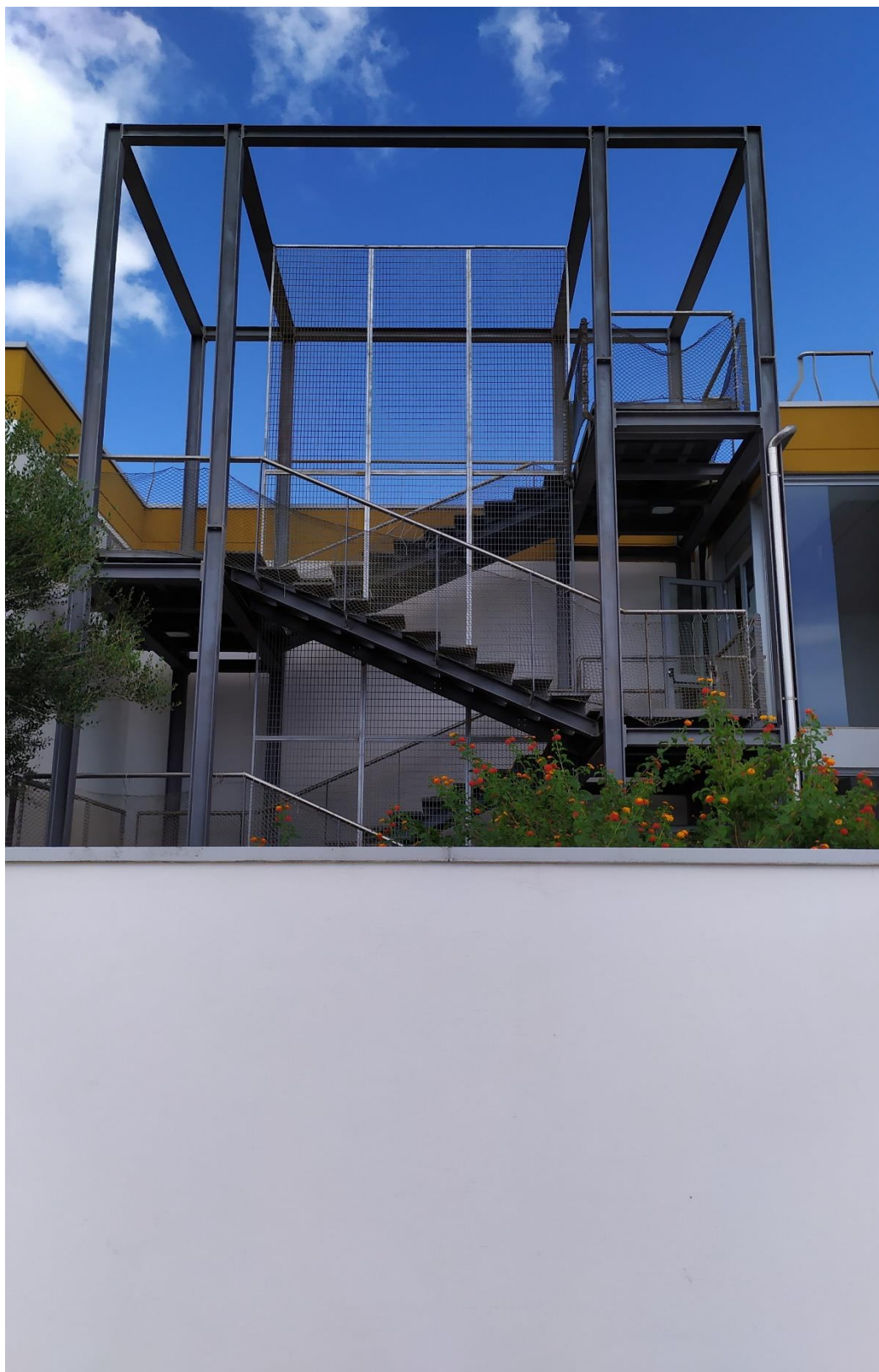
FOTO E.17: in evidenza, la scalinata esterna per l'accesso ai piani dell'Hotel, nonché di sicurezza.
