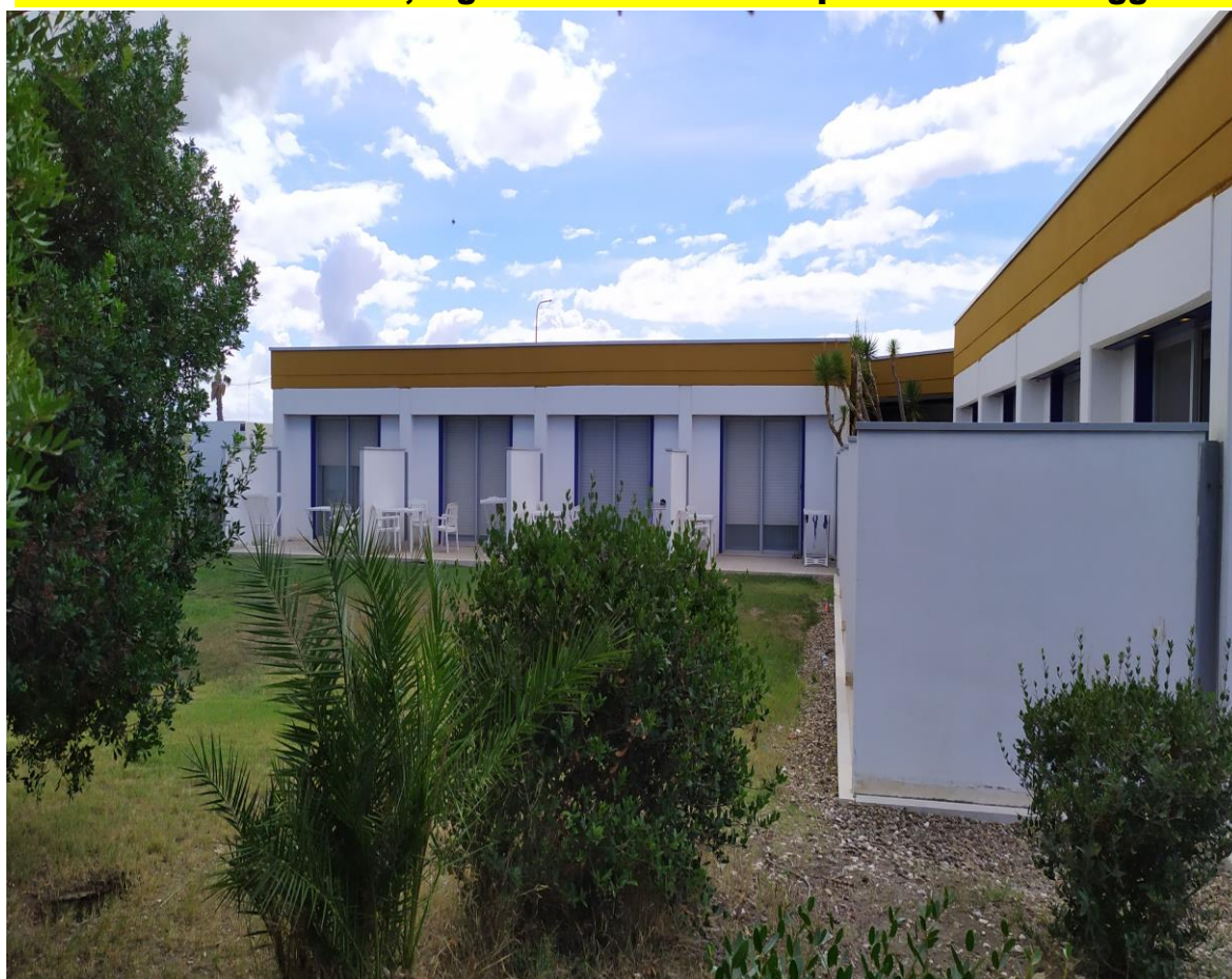
FOTO E.53: in evidenza, il giardino lato mare in prossimità delle camere 1-2-3-4 e 5-6-7-8.
