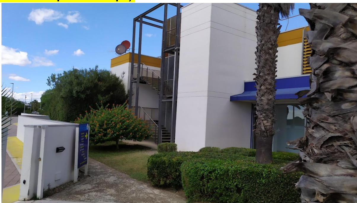
FOTO E.10: in evidenza, il patio nei pressi dell'ingresso all'Hotel.
