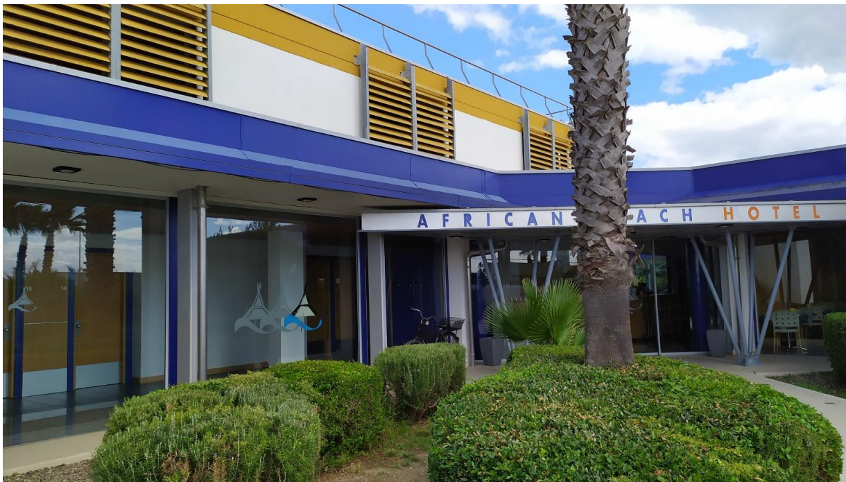
FOTO E.12: in evidenza, il patio nei pressi dell'ingresso all'Hotel.
