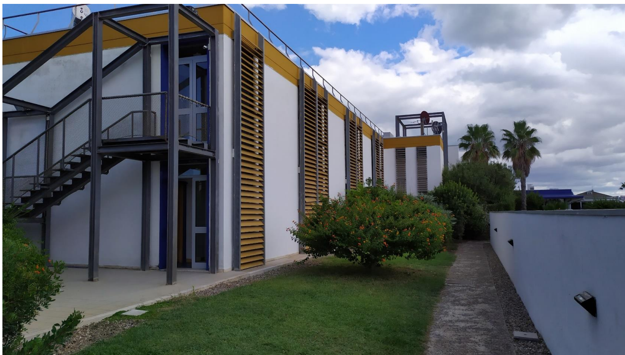
FOTO E.26: in evidenza, il patio antistante l'Hotel e la scala esterna di sicurezza.
