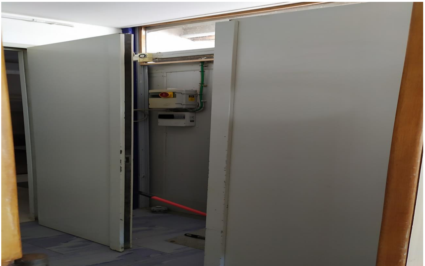
FOTO I.36: in evidenza, sul retro cucina l'ingresso di servizio al momento occupato da impianti precari.
