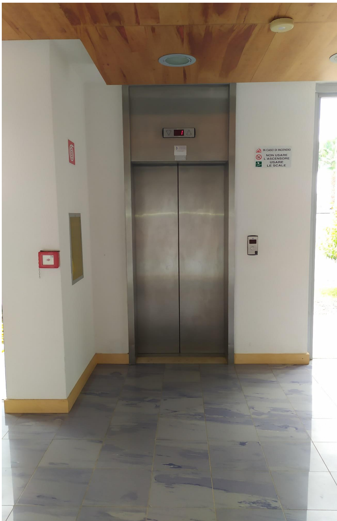
FOTO I.61: in evidenza, il pianerottolo di disimpegno e l'ascensore.
