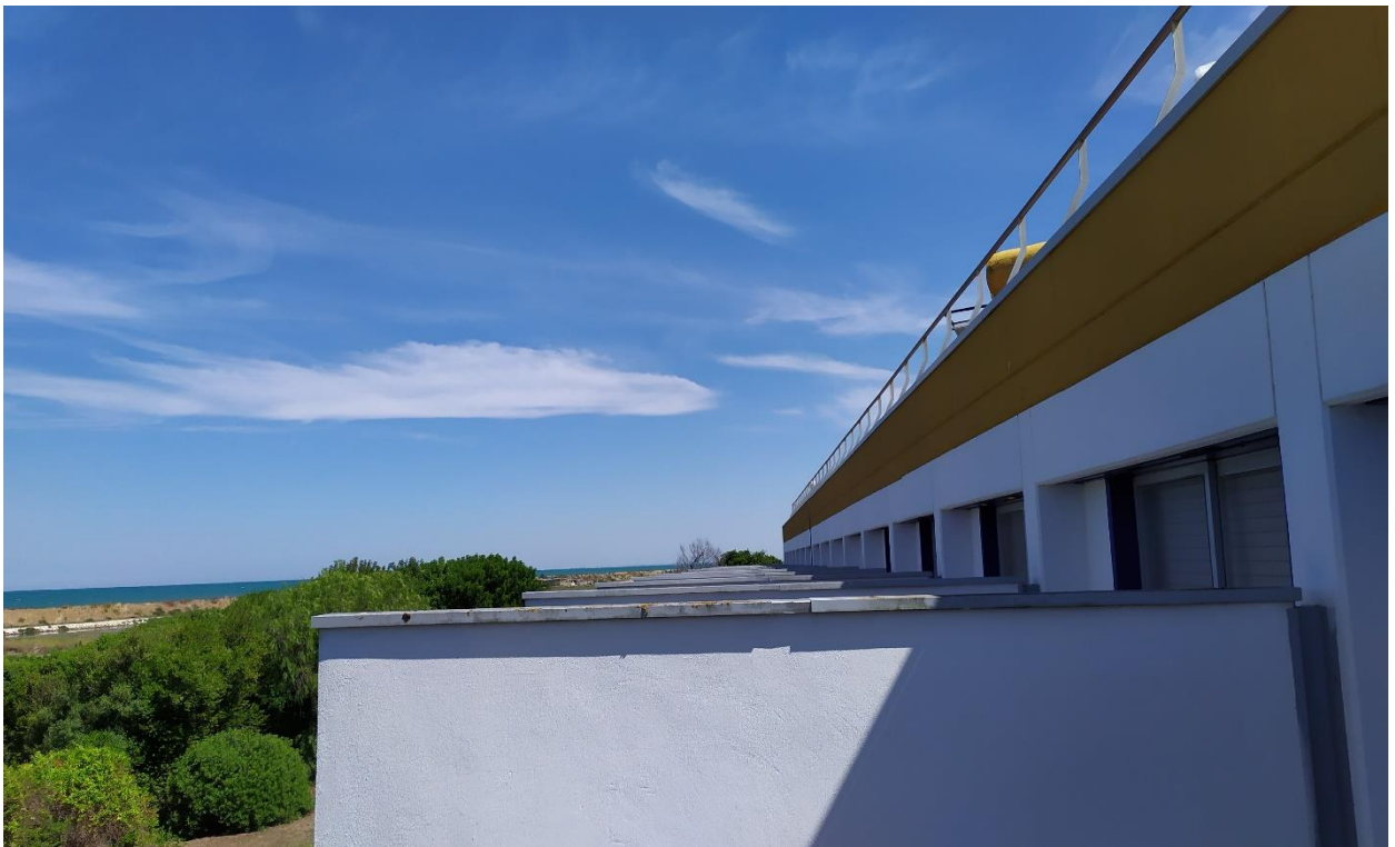
FOTO I.129: in evidenza, i setti divisori delle verande.
