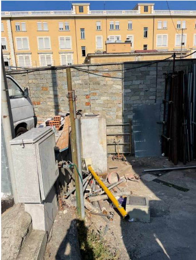
FOTO 8 – vista elemento in muratura esterno
