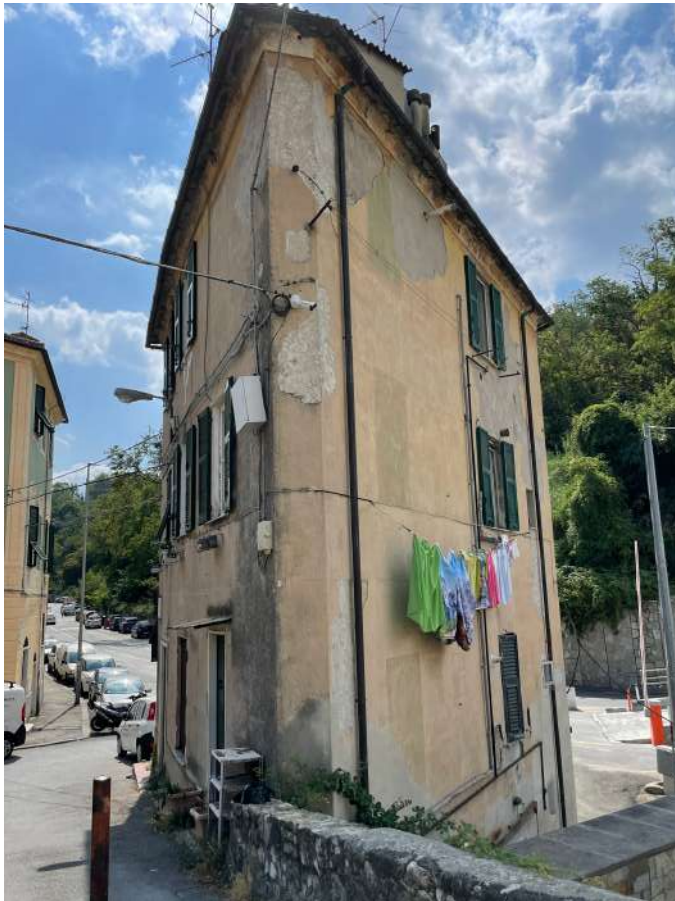
FOTO 3 – vista dal ponte sul torrente Sturla verso Via delle Casette
