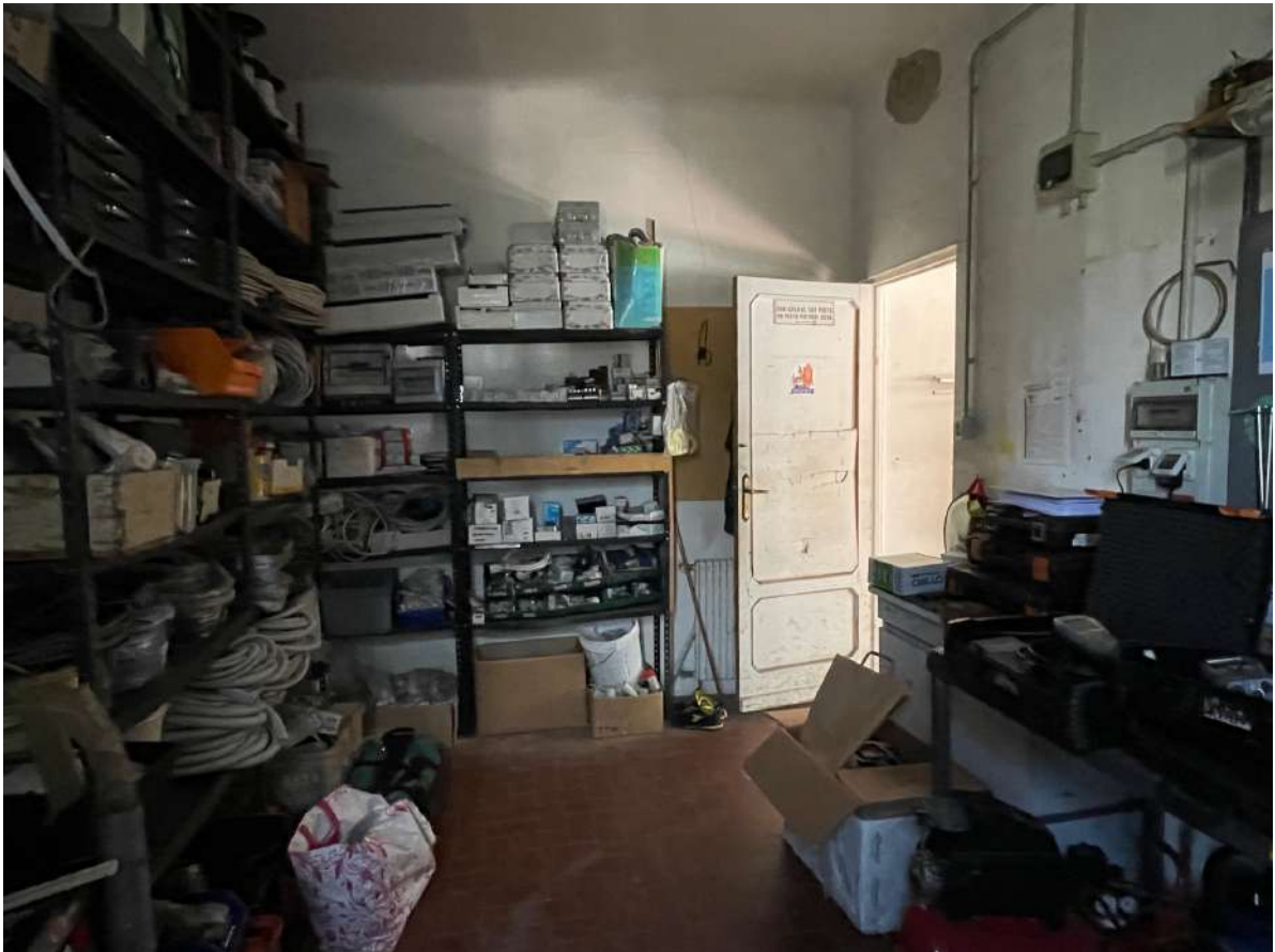
FOTO 17 – vista verso parete nord dove si nota tamponamento finestra
