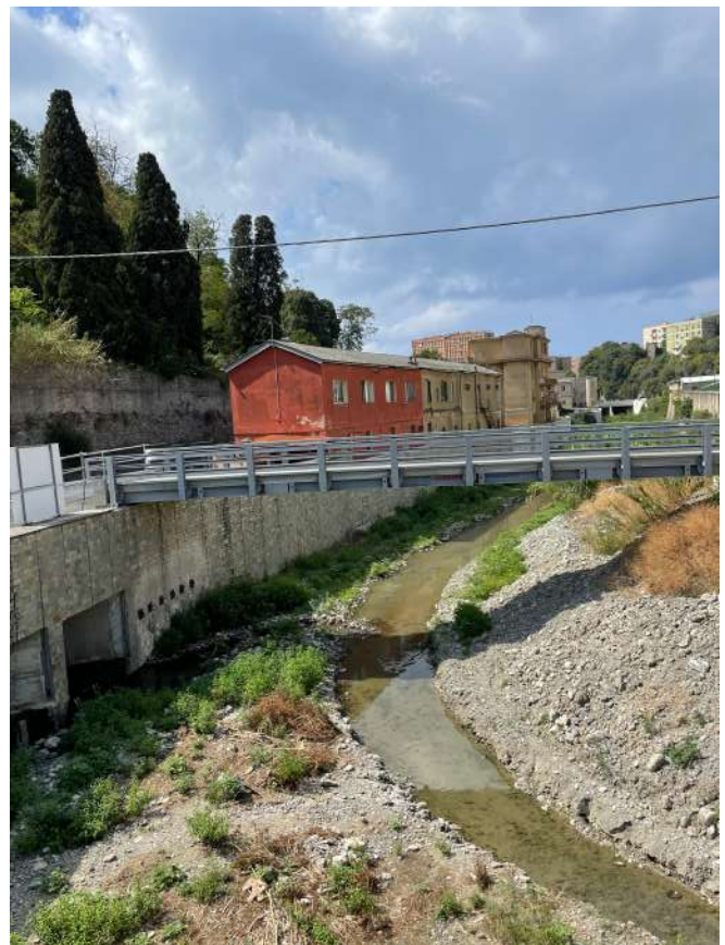
FOTO 4 – vista dal ponte sul torrente Sturla verso sud
