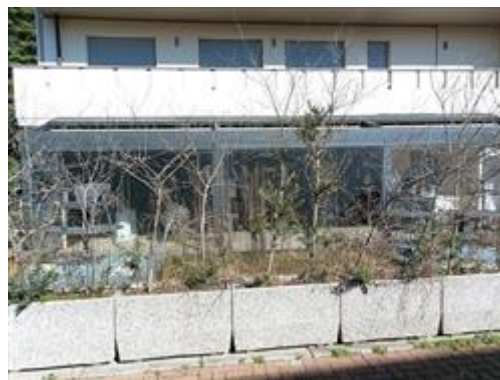
AREA ESTERNA CON VERANDA E PARTE DEL CORTILE COMUNE OCCUPATO SENZA AUTORIZZAZIONE
