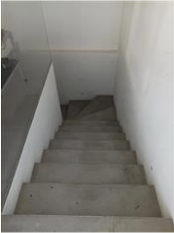
SCALA AL PIANO INTERRATO
