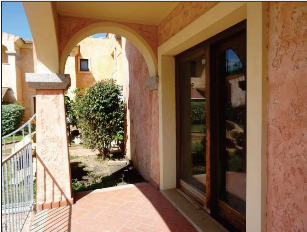
Vista della veranda coperta lato sud.
