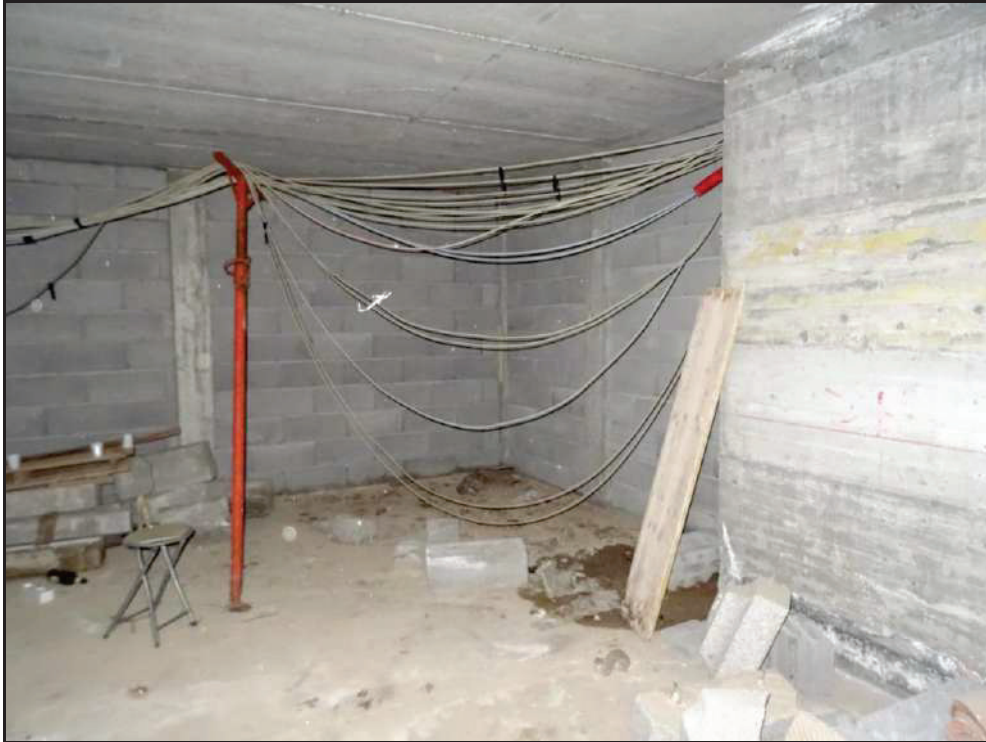
Vista del locale sub 28.
