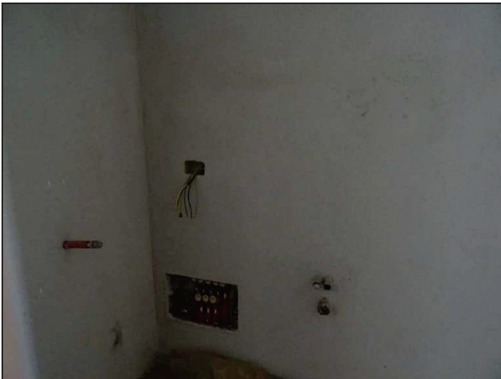
Particolare stato realizzazione impianti.
