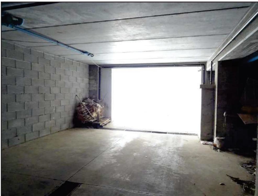
Vista dell'ingresso carrabile al garage.
