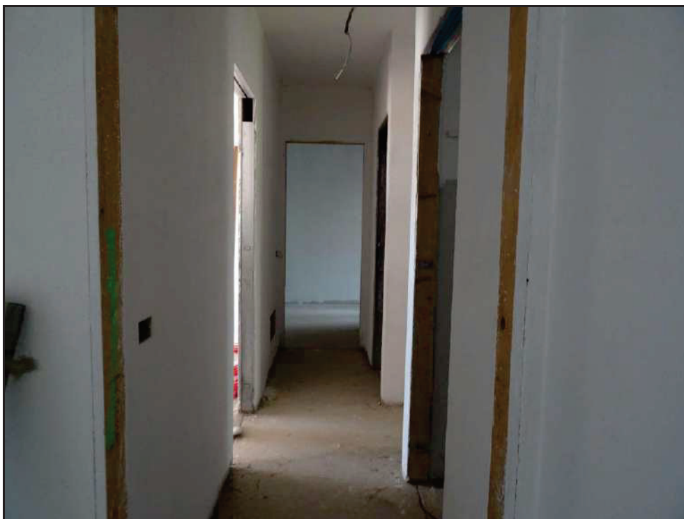
Vista del disimpegno con ingressi a camere e bagni.
