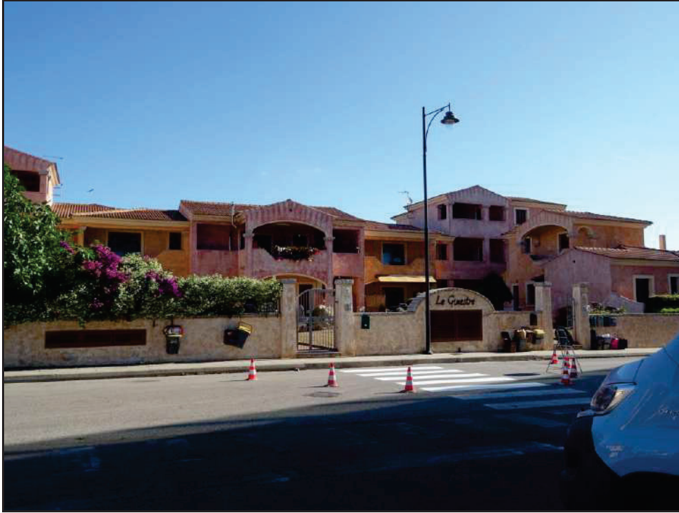
Vista dei cancelletti di accesso alla proprietà e facciata principale su via Strasburgo.
