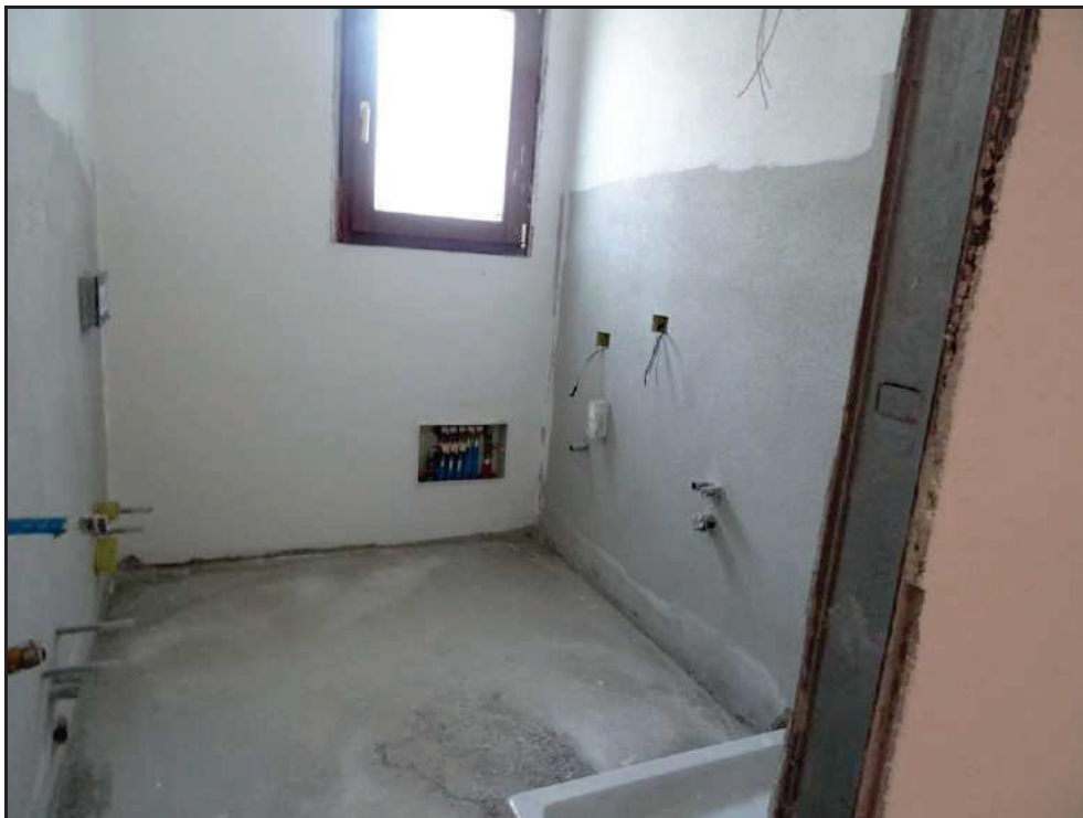
Vista ingresso al bagno lato ovest.
