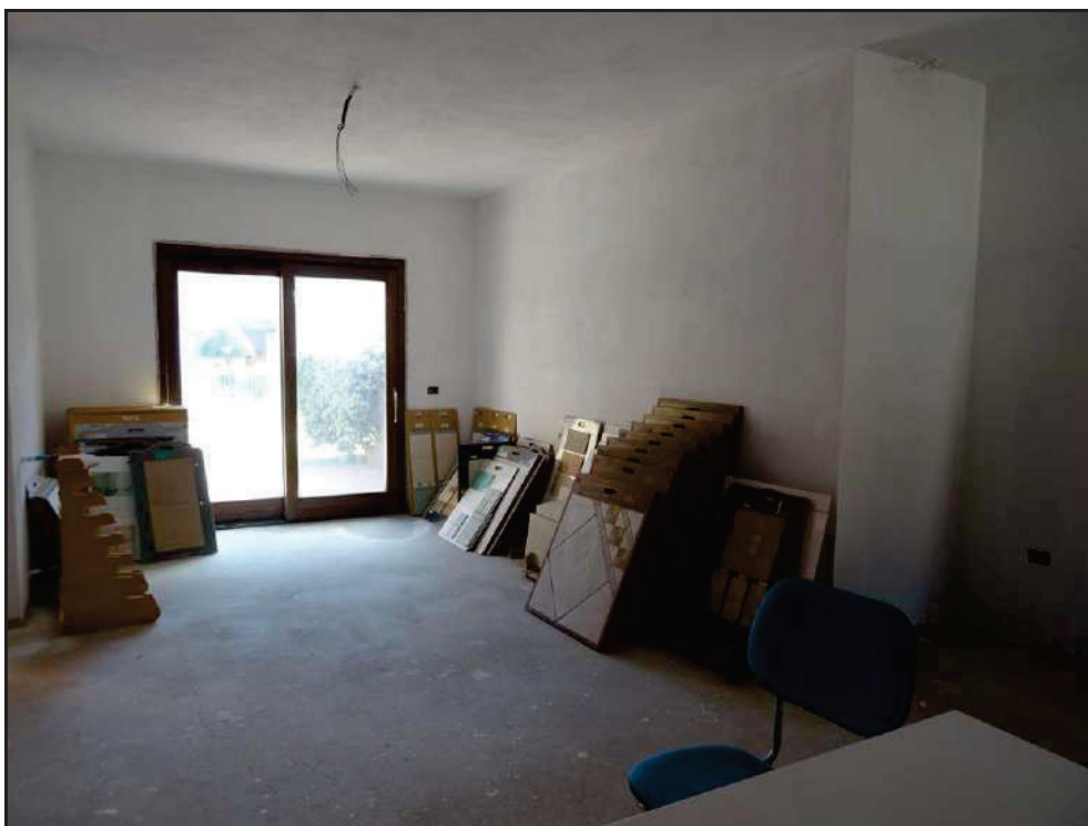
Vista del soggiorno con affaccio alla pertinenza lato est.
