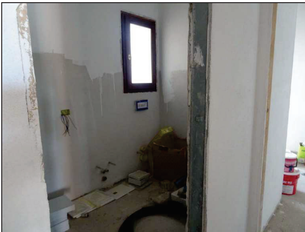
Vista ingresso al bagno lato nord.
