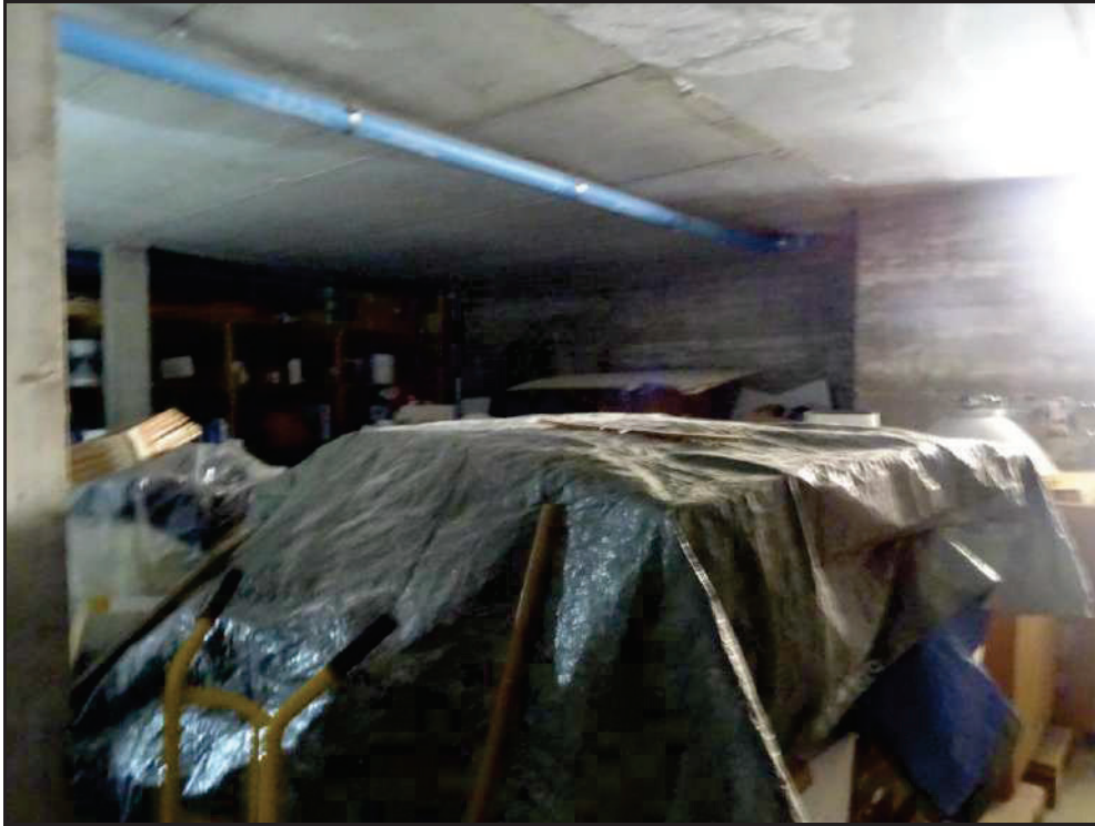
Vista dei locali subb. 22, 23.
