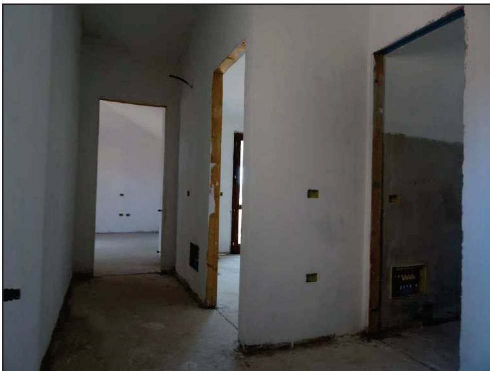
Vista del disimpegno al piano primo con accesso alle camere.
