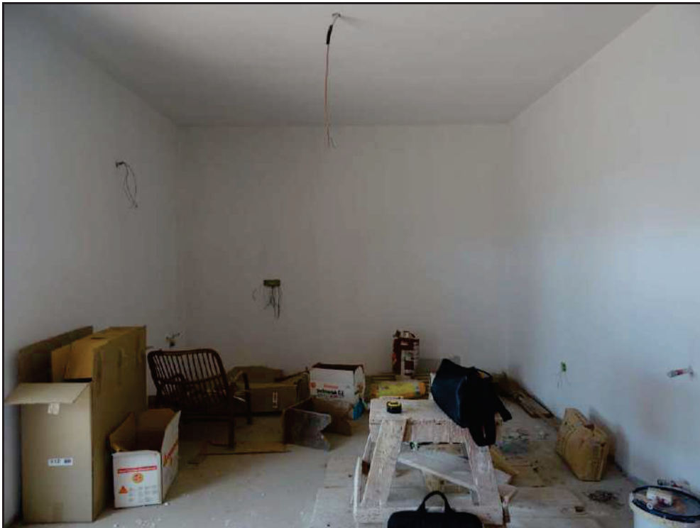
Vista del soggiorno e zona cottura.
