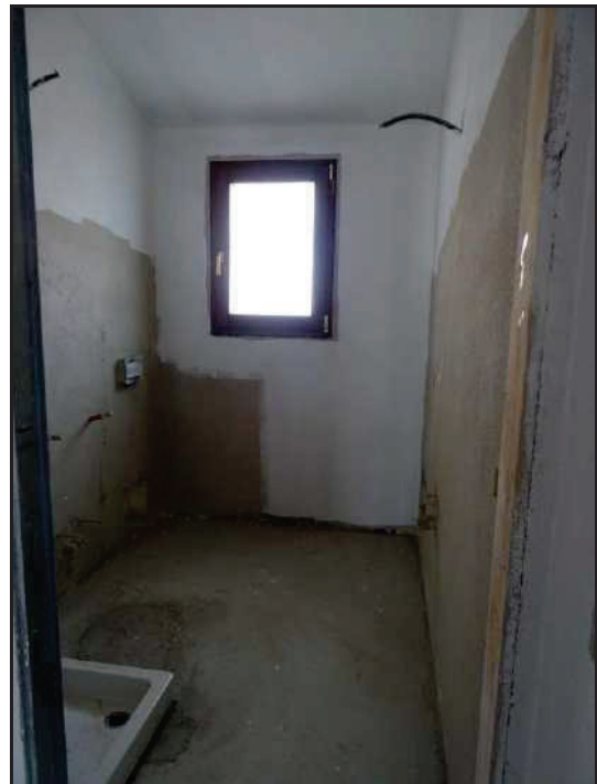
Vista ingresso al bagno lato nord.
