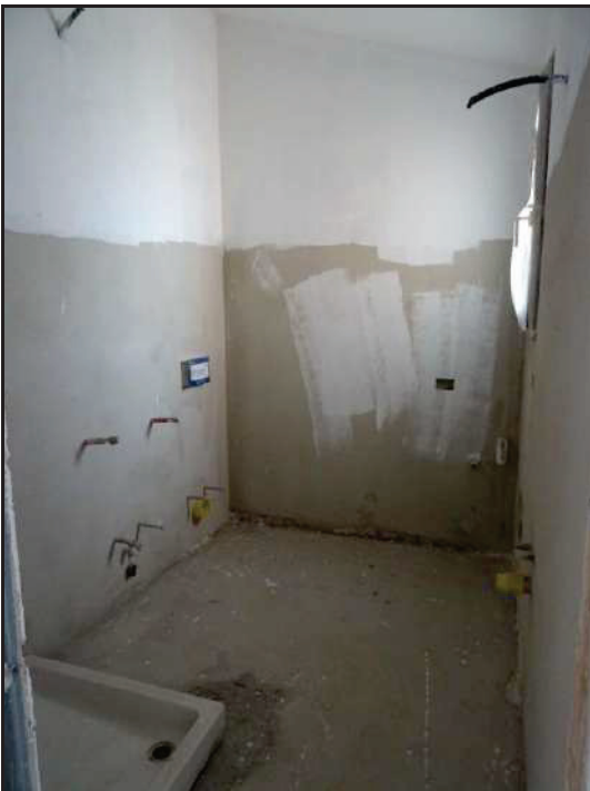
Vista ingresso al bagno lato ovest.
