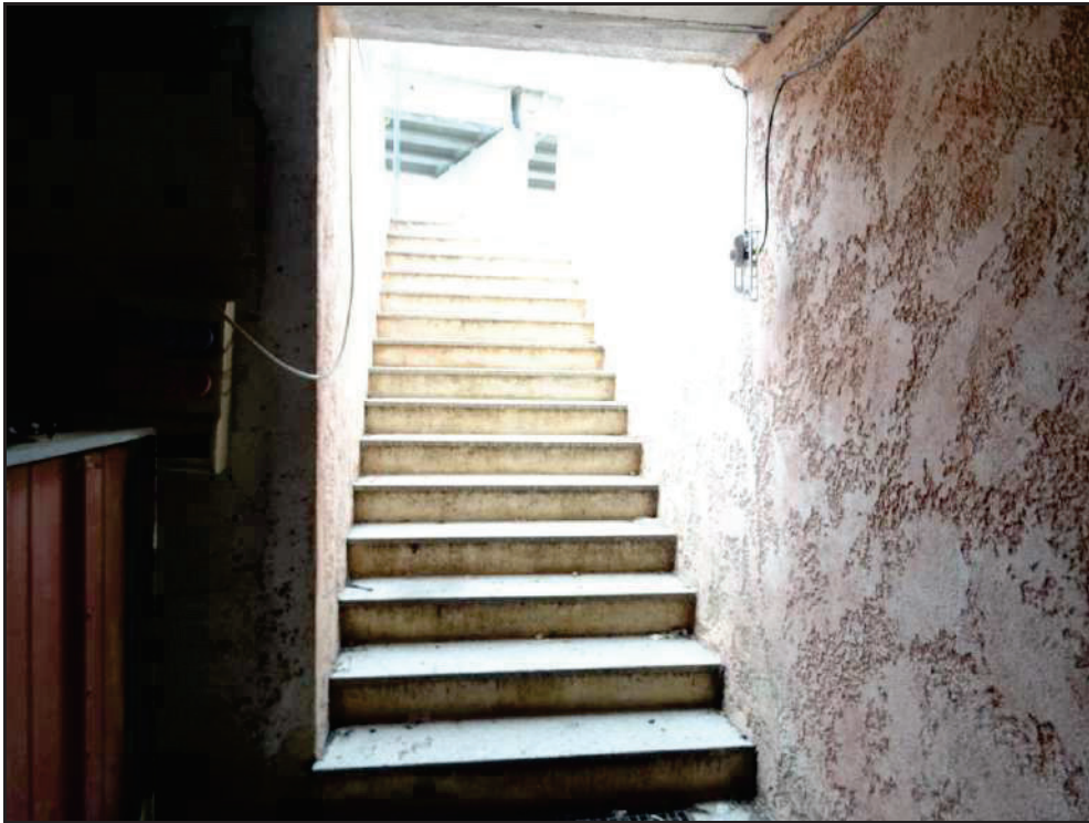
Vista della scala di accesso al piano interrato.
