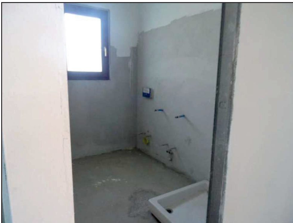
Vista ingresso al bagno lato nord.
