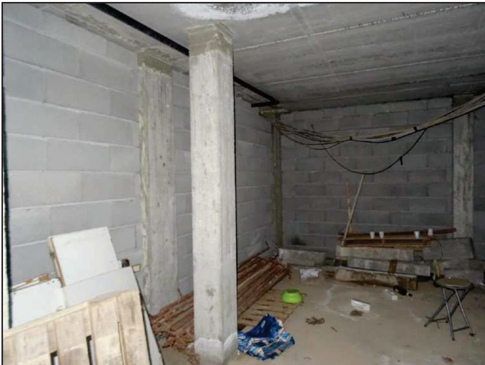
Vista del locale sub 28.
