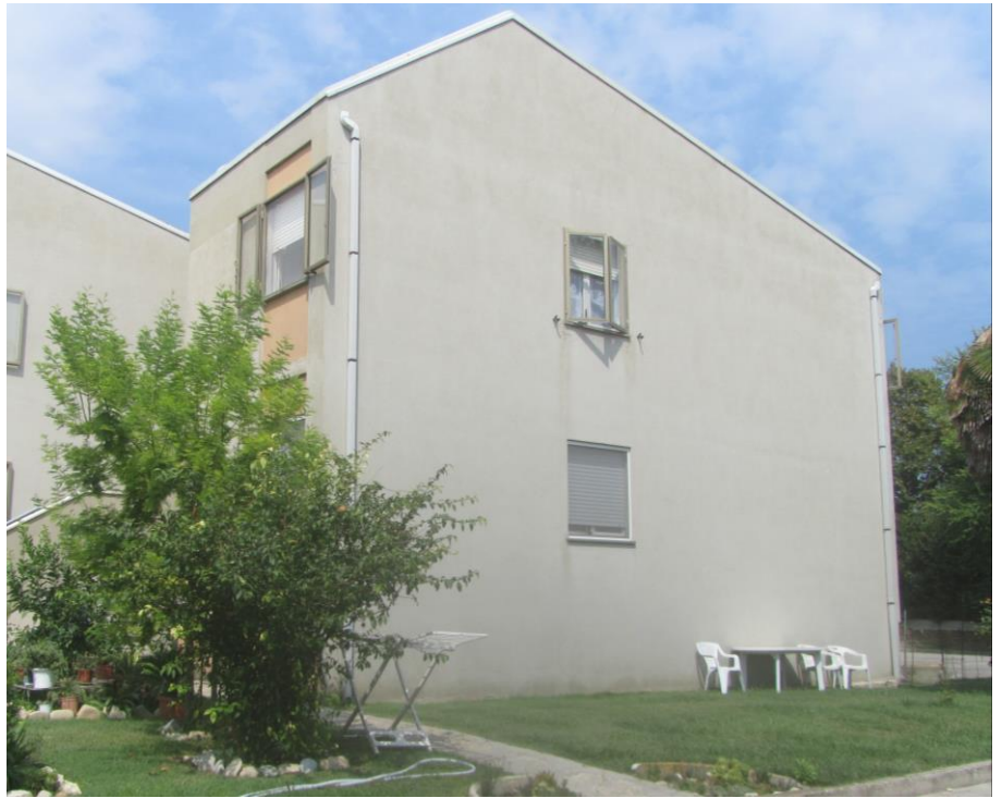
Foto 4 vista fronte laterale sud-est
