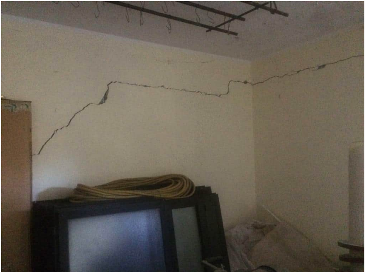
Foto n° 24 – Locale deposito censito nel N.C.E.U. al foglio 22 particella 435 sub 3
