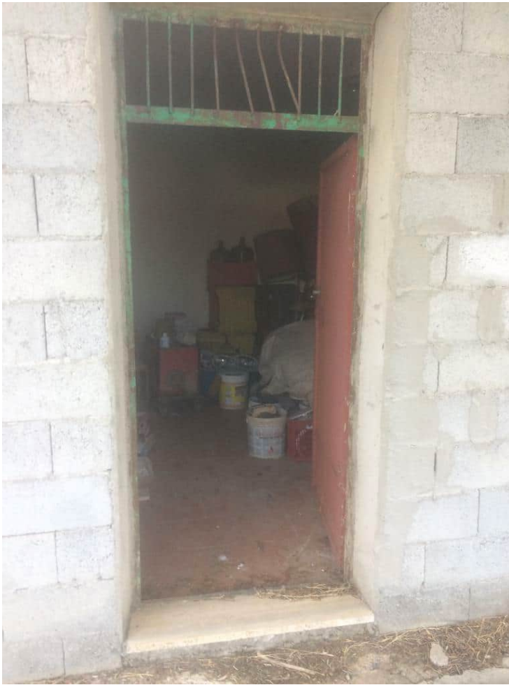
Foto n° 22 – Locale deposito censito nel N.C.E.U. al foglio 22 particella 435 sub 3
