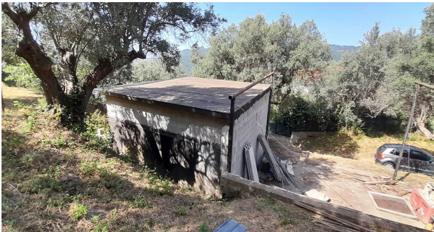
Foto n° 25 – Locale deposito censito nel N.C.E.U. al foglio 22 particella 435 sub 3 – Angolo Nord-Est
