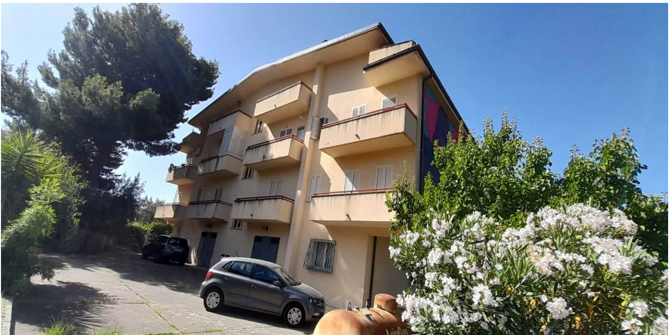
Foto n° 2 – Edificio condominiale in cui sono ubicati gli immobili censiti nel N.C.E.U. al foglio 22, particella 308 sub 9,10,14 e 1102 (Prospetto Nord-Est)
