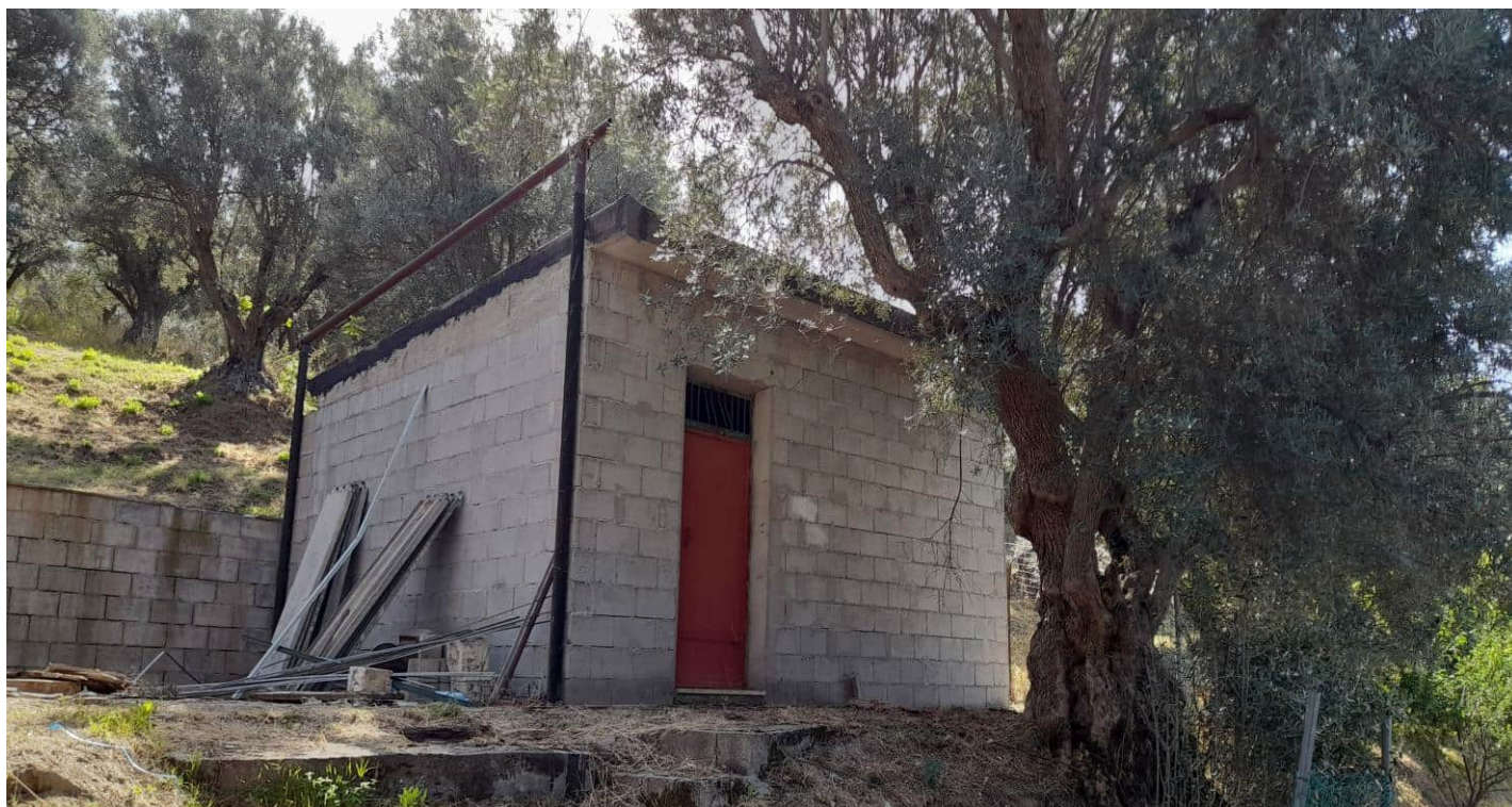
Foto n° 21 – Locale deposito censito nel N.C.E.U. al foglio 22 particella 435 sub 3 – Angolo Nord-Ovest
