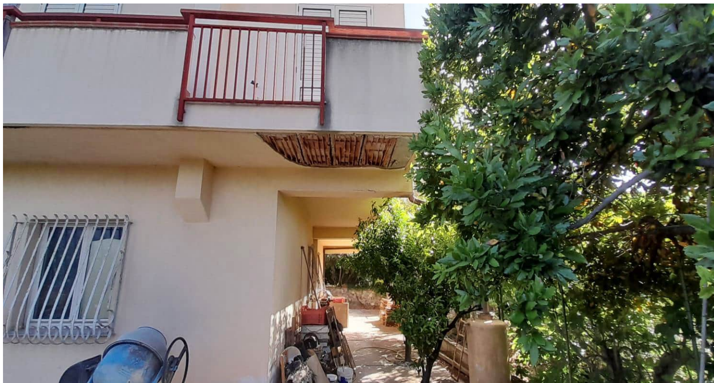
Foto n° 11 – Immobile censito nel N.C.E.U. al foglio 22 particella 308 sub 9 – Particolare balcone lato Sud-Ovest
