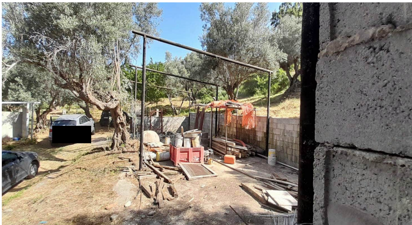
Foto n° 27 – Struttura della tettoia censita nel N.C.E.U. al foglio 22 particella 435 sub 4
