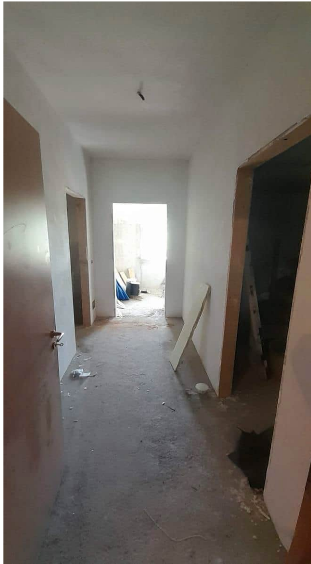
Foto n° 9 – Immobile censito nel N.C.E.U. al foglio 22 particella 308 sub 9 - Ingresso dal sub 14
