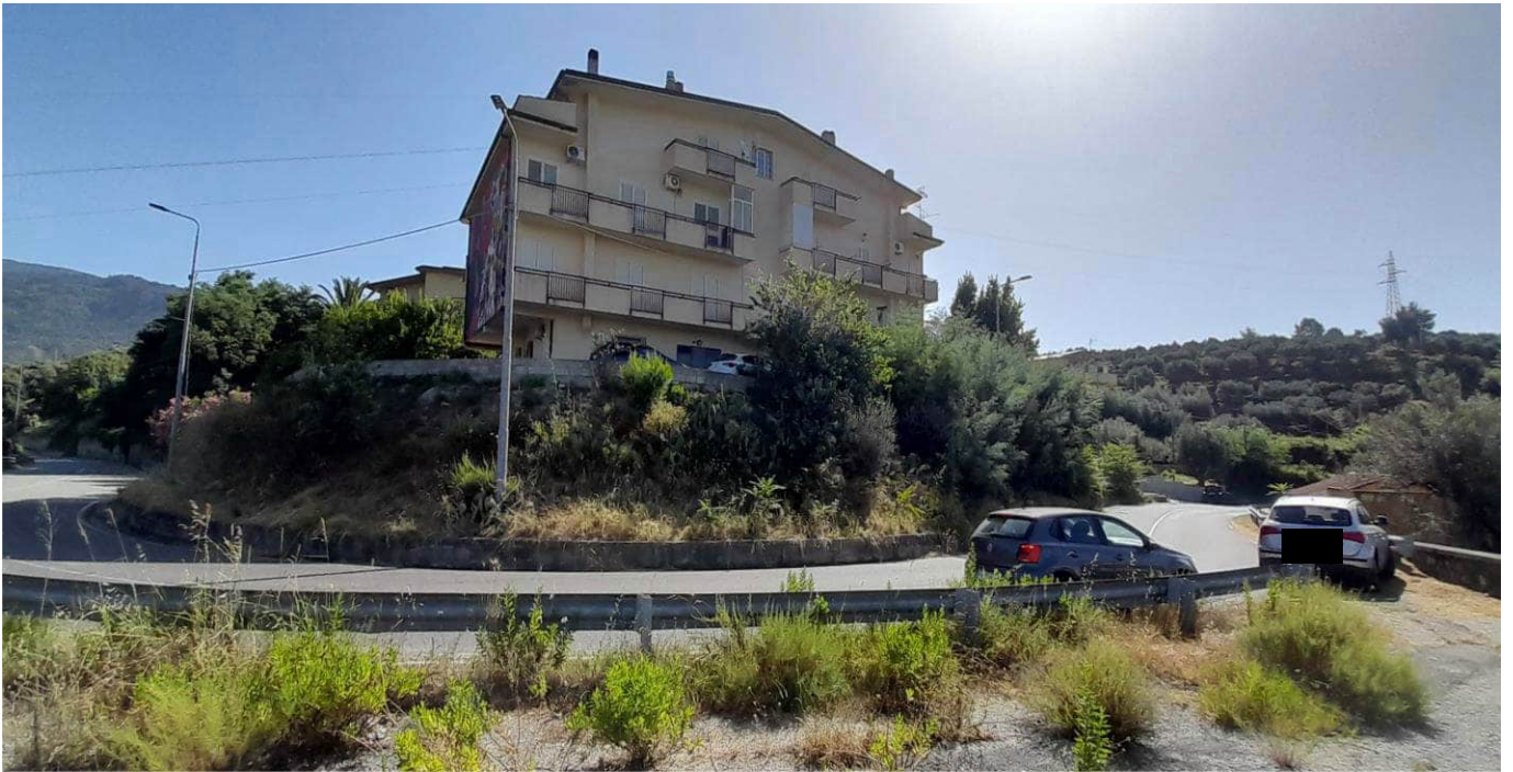
Foto n° 1 – Edificio condominiale in cui sono ubicati gli immobili censiti nel N.C.E.U. al foglio 22, particella 308 sub 9,10,14 e 1102 (Prospetto Sud-Ovest)
