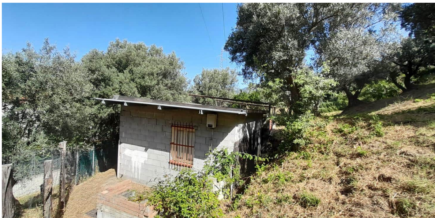
Foto n° 21 – Locale deposito censito nel N.C.E.U. al foglio 22 particella 435 sub 3 – Prospetto Sud-Est
