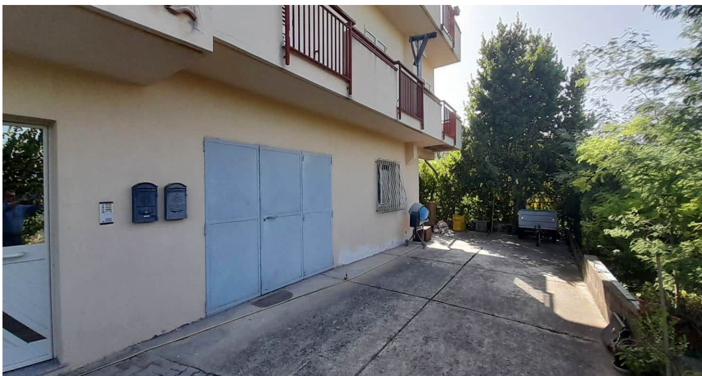
Foto n° 17 – Locale deposito censito nel N.C.E.U. al foglio 22 particella 308 sub 1102 – Ingresso da esterno
