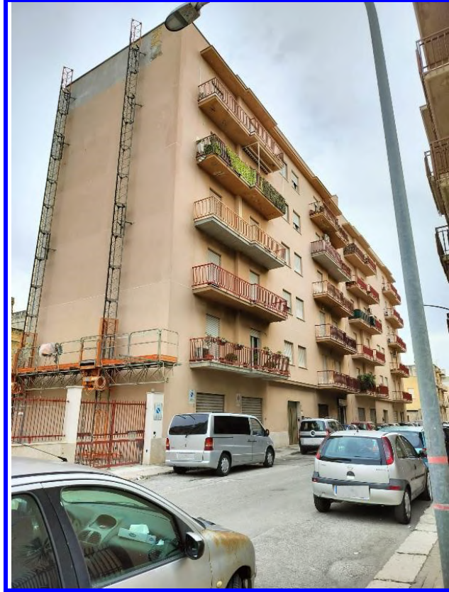
Foto 1 – prospetto fabbricato su via Messina
