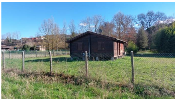
Foto nr.12: vista immobile Lotto 2
