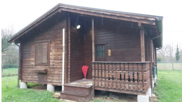
Foto nr.14: vista immobile Lotto 2
