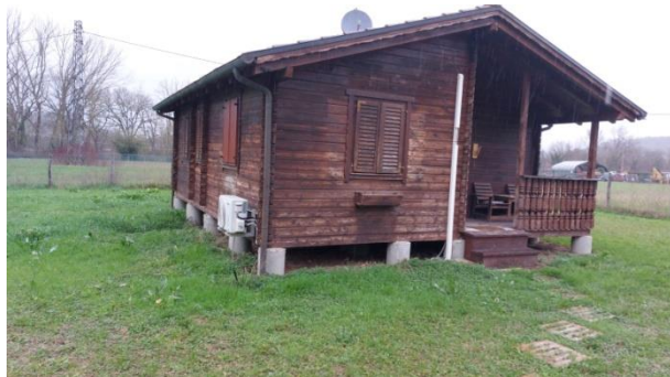
Foto nr.15 : vista immobile Lotto 2
