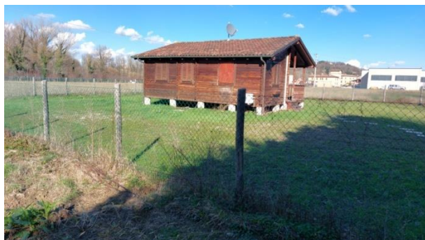
Foto nr.13 : vista immobile Lotto 2
