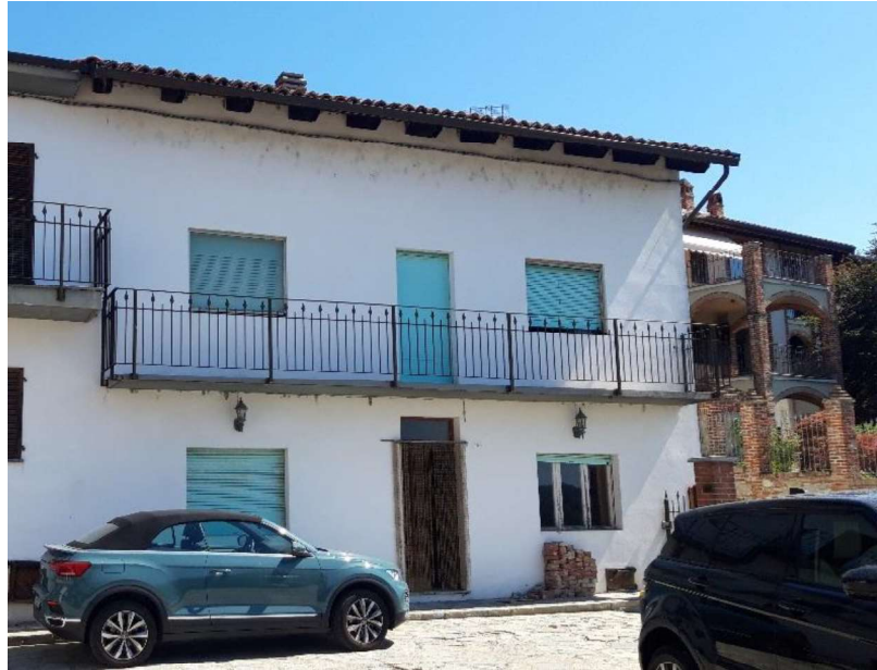
Fig. 1 Facciata dell'immobile corpo a Nord.
