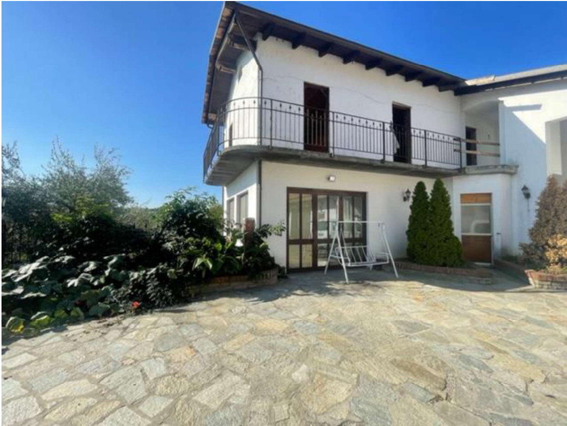
Fig. 1 Accesso a Locale Sgombero dal Cortile.
