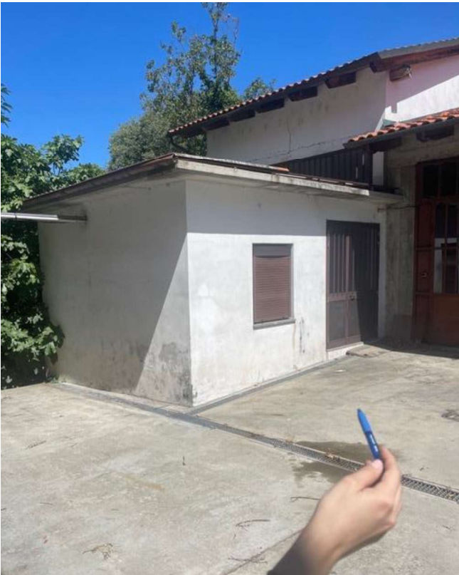
Fig. 1 Accesso ad Autorimessa da Cortile Retro di Via Santa Lucia n. 18
