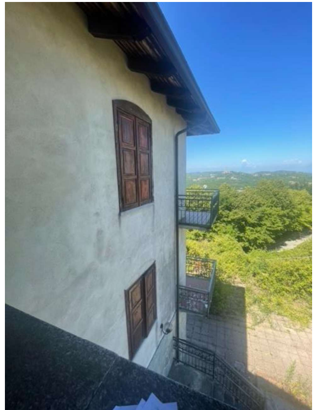
Fig. 9 Vista della facciata dal terrazzo coperto.
