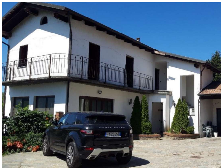
Fig. 8 Facciata dell'immobile corpo a Sud.
