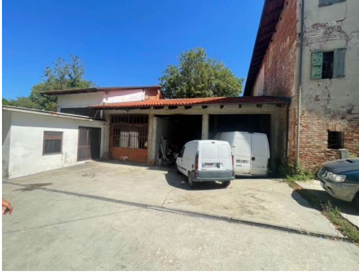
Fig. 1 Accesso a Ricovero Automezzi-Tettoia dal cortile retro di Via Santa Lucia n.18
