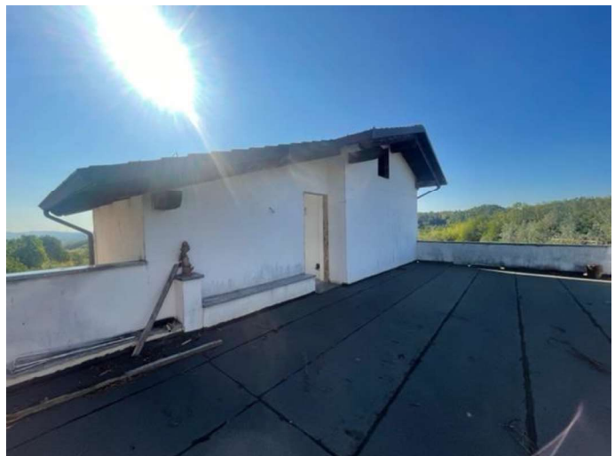
Fig. 17 Accesso a Terrazzo dell'unità (F.22 P. 383 Sub. 3) - Piano Primo.
