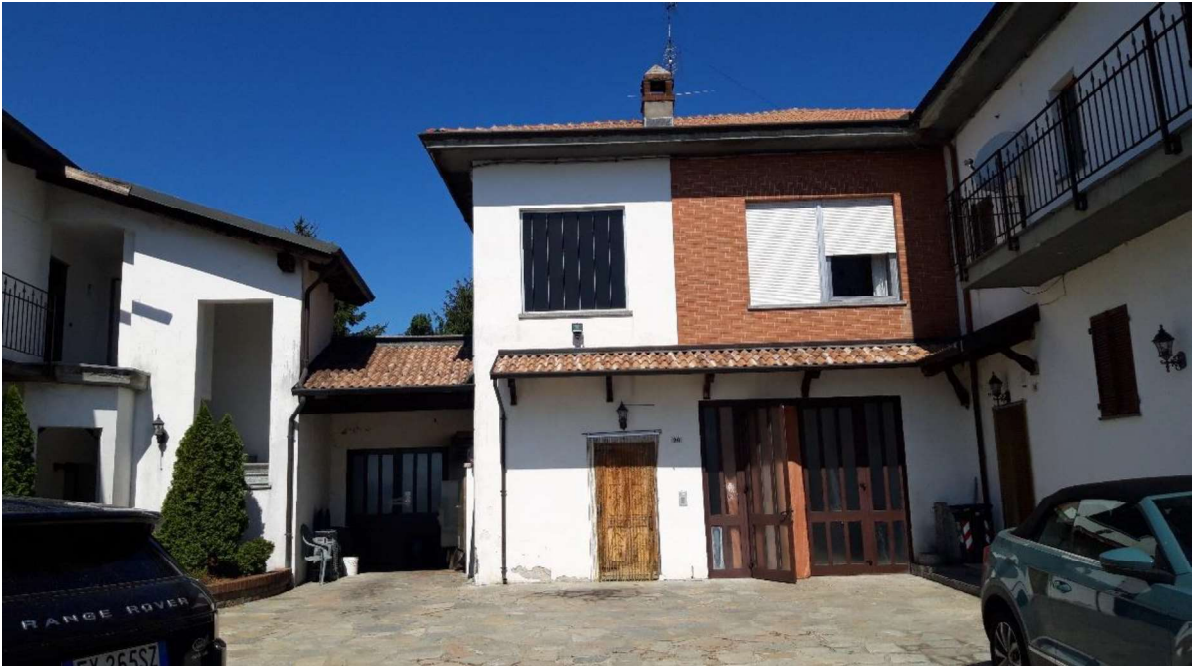
Fig. 1. Accesso all'immobile dal cortile comune su Via Santa Lucia n.20
