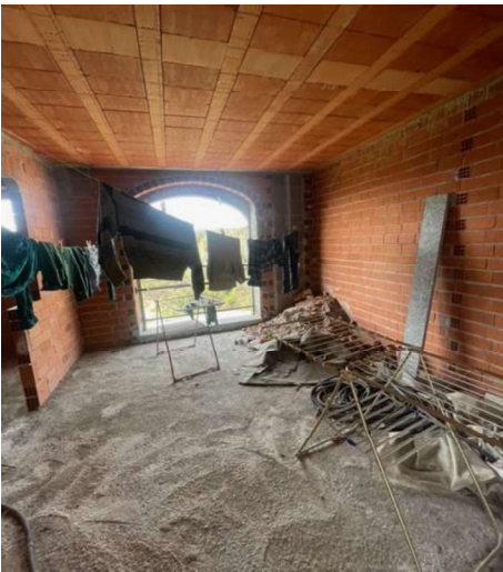
Fig. 14 Interno - Piano Primo.
