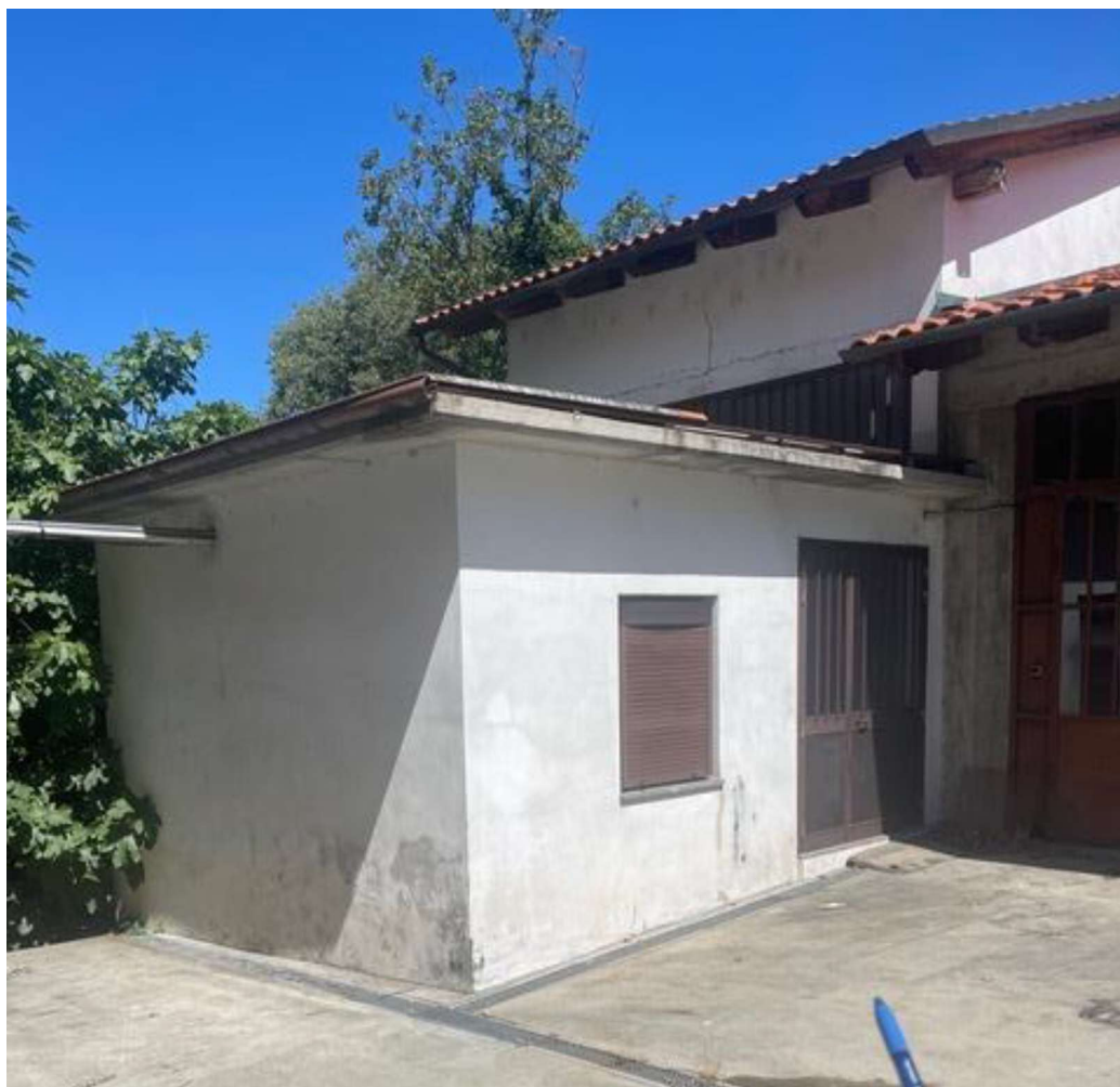
Fig. 1 Accesso a Silos e portone di accesso a camera.
