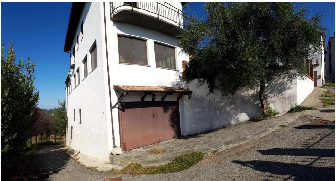
Fig. 2 Vista Prospetto EST del Piano terra.
