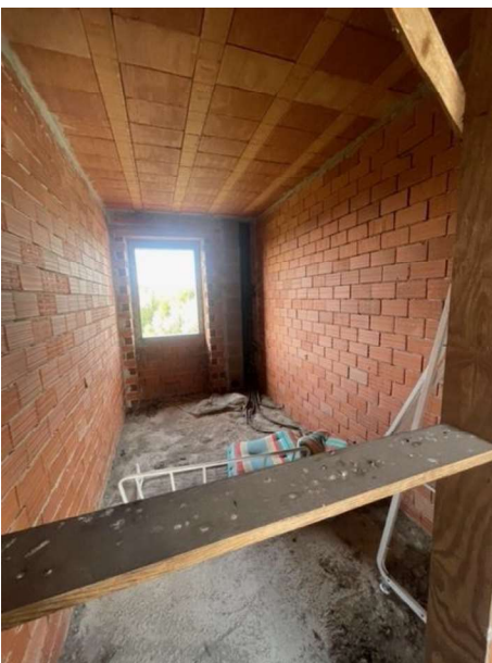
Fig. 16 Interno - Piano Primo.
