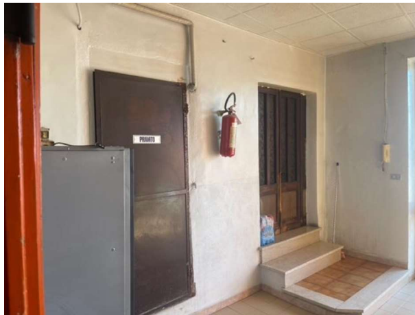
Fig. 3. Ripostiglio e accesso a unità adiacente F. 22 P. 383 Sub. 2
