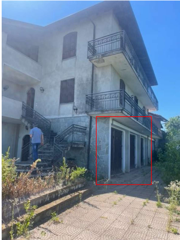
Fig. 1 Accesso dal Cortile a Deposito in Piano Terra.
