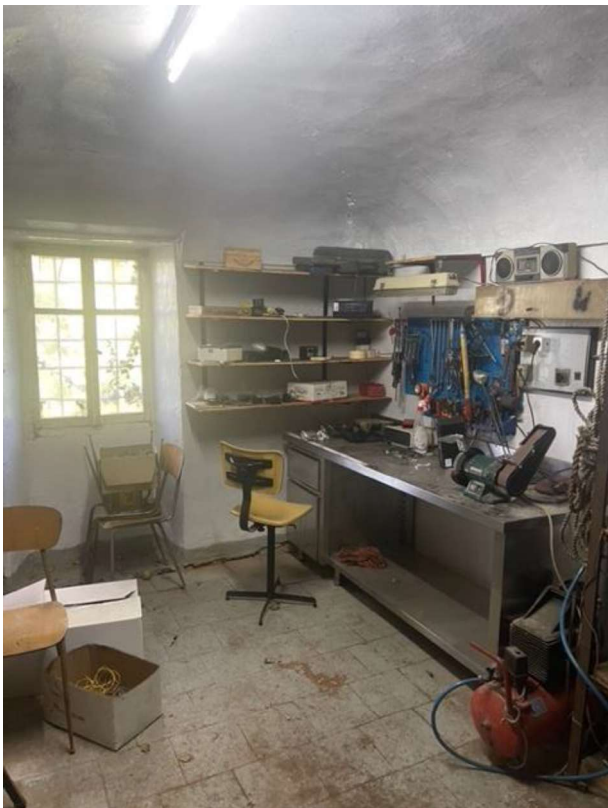
Fig. 3 Camera al Piano Terra.
