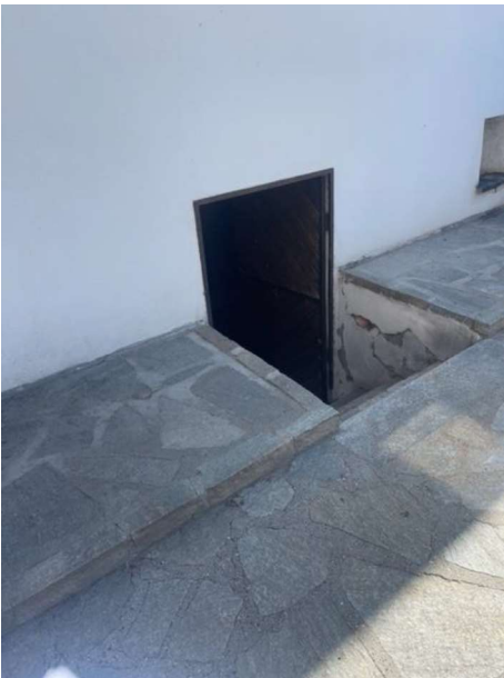
Fig. 6 Accesso a Cantina dal Cortile comune.
