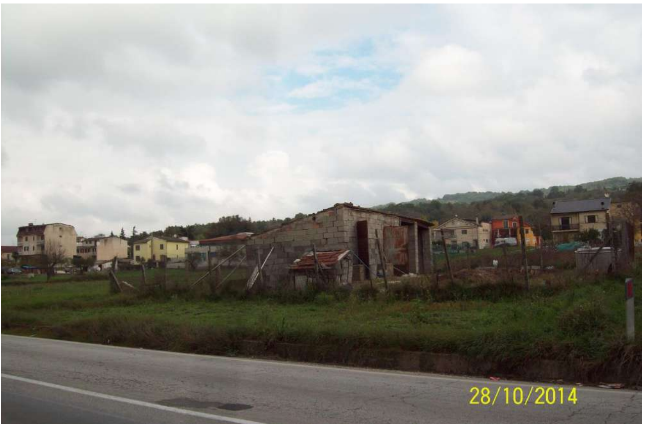
Fabbricato con area F.28 part.la 960 sub1 e 2 graffato,C/6 di mq 50. Lotto n.4
