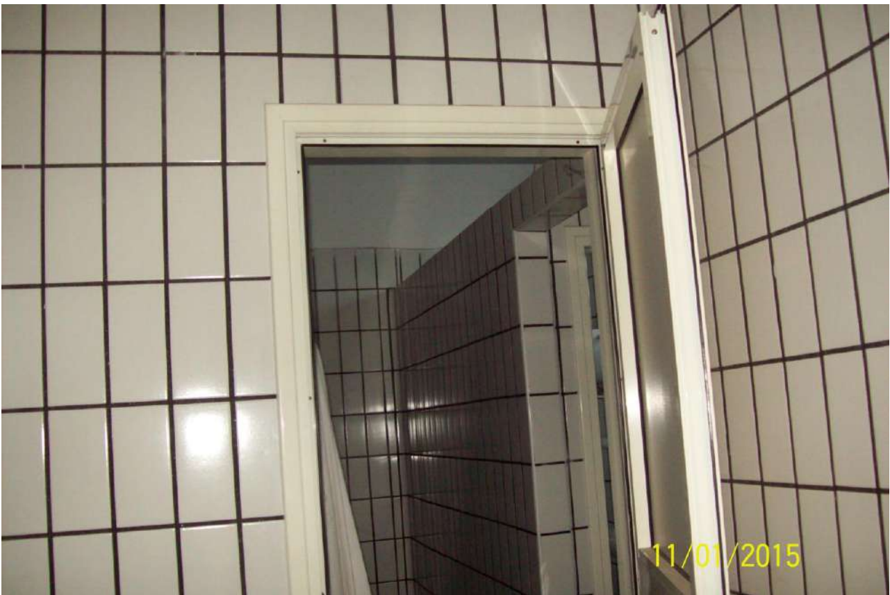
Lotto n.3. Interno della porzione di fabbricato F.28 particella 495 sub1 trasformato da C/6 a D1 uffici e servizi igienici del caseificio da regolarizzare attraverso sanatoria
