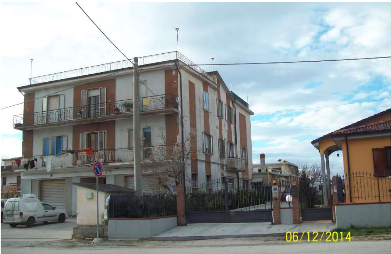
Fabbricato F.28,part.la 495 tipo A/4 costituente l'abitazione dei tre soggetti eseguiti. Lotti n.1 e 2
