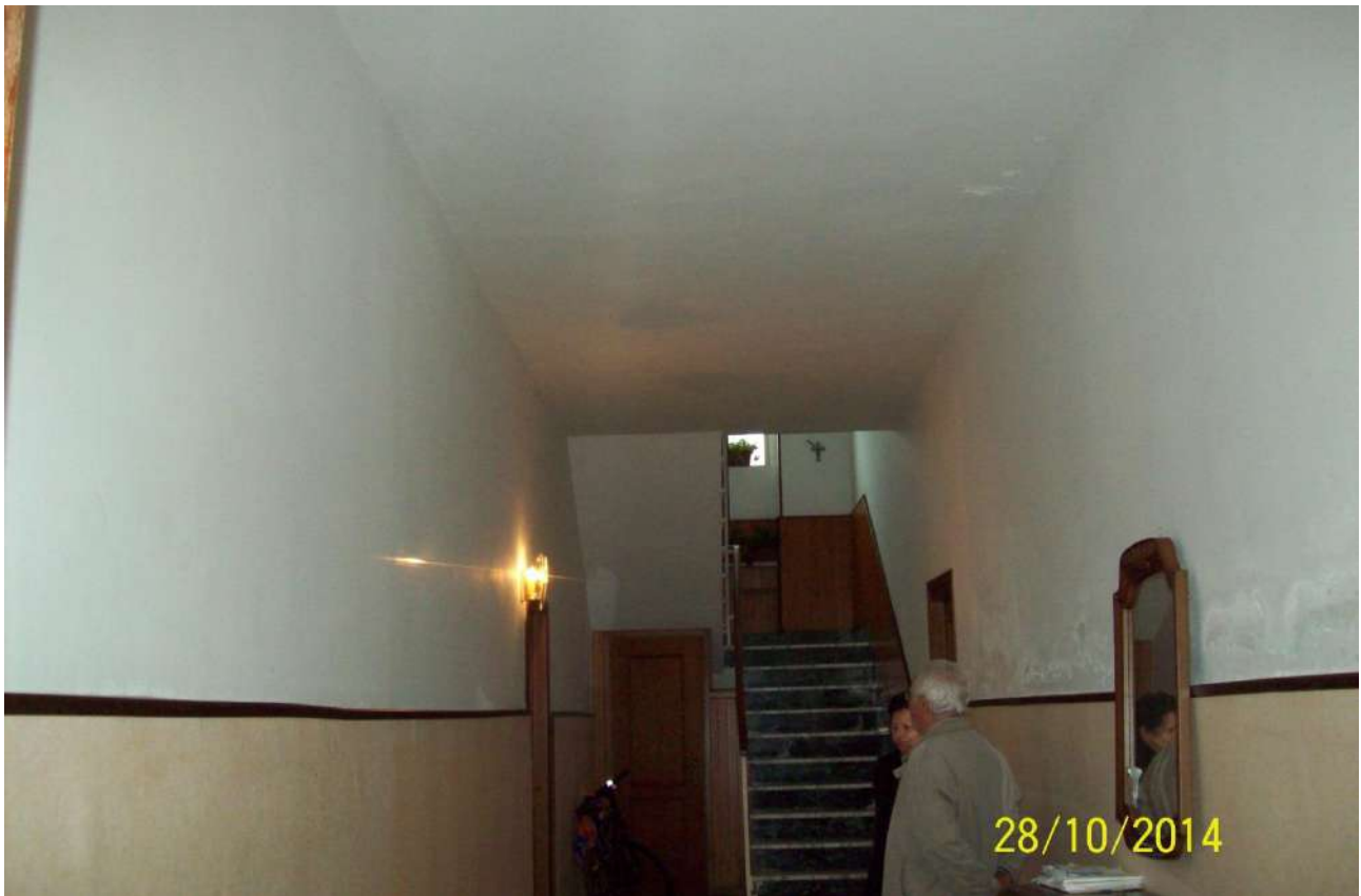
Ingresso con scala comune ai due appartamenti F.28 part.le 495 sub 6 e sub 5 con lastrico solare, ingresso e scala comune ai lotti 1 e 2.
