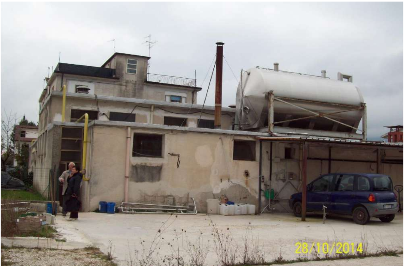
Vista del caseificio con area di parcheggio F.28,part.la 812. Lotto n.3
