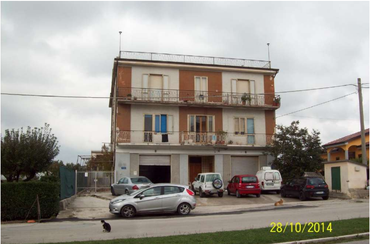
Fabbricato F.28,part.la 495 tipo A/4 costituente l'abitazione dei tre soggetti esegutati. Lotti n.1 e 2
