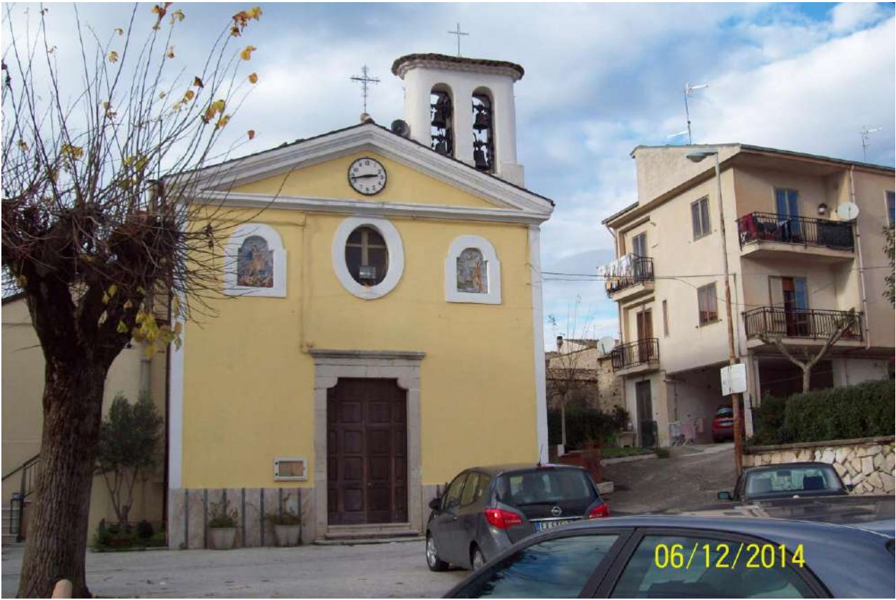
Altra Chiesa del contesto del centro urbano delle aree edificabili F.27, part.le 470,153 e 467,BA2
