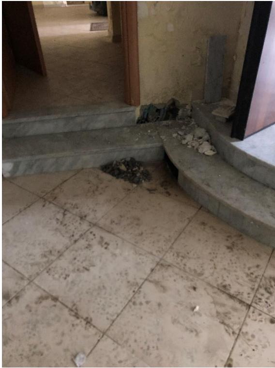
Saggi effettuati sulla muratura per l'individuazione del punto di rottura della tubazione e fuoriuscita di acqua che affiora in corrispondenza dello scalino di collegamento con il lotto adiacente
