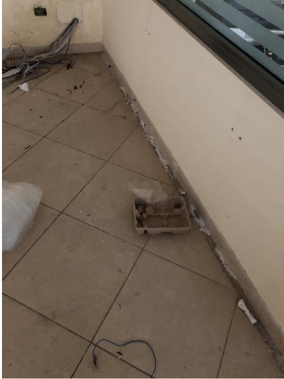
Efflorescenze negli ambienti del lotto n°2 adiacente a causa della stagnazione dell'acqua presente sul pavimento e saggi effettuati per la ricerca del punto di rottura della tubazione privata
