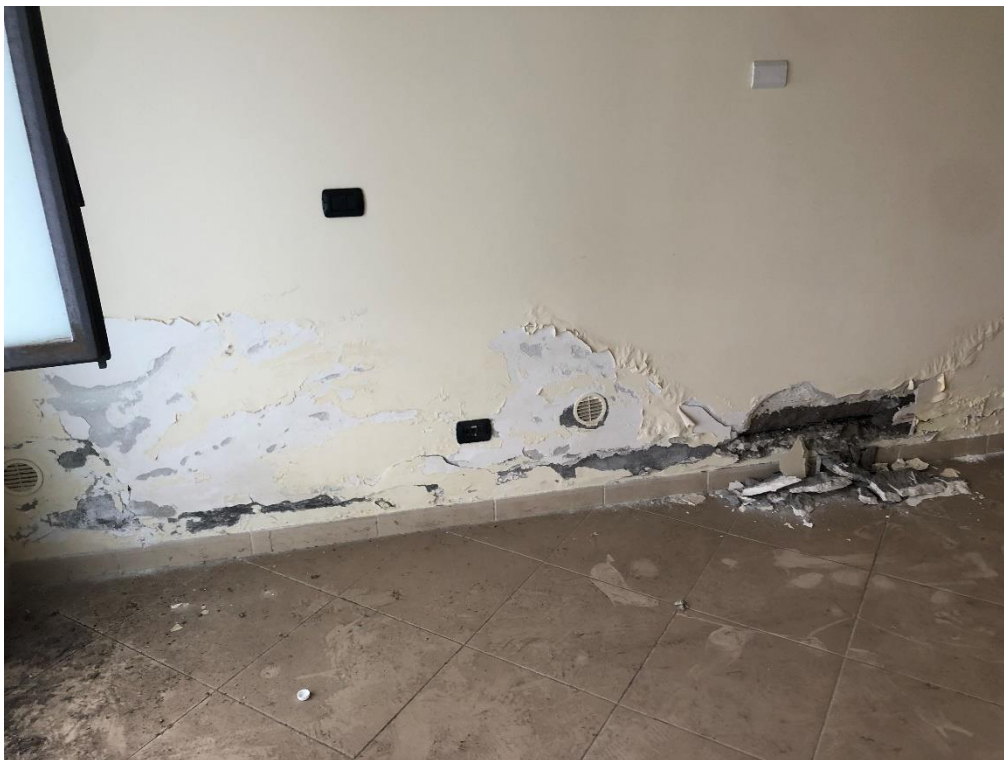
Saggi effettuati per la ricerca del punto di rottura della tubazione privata
