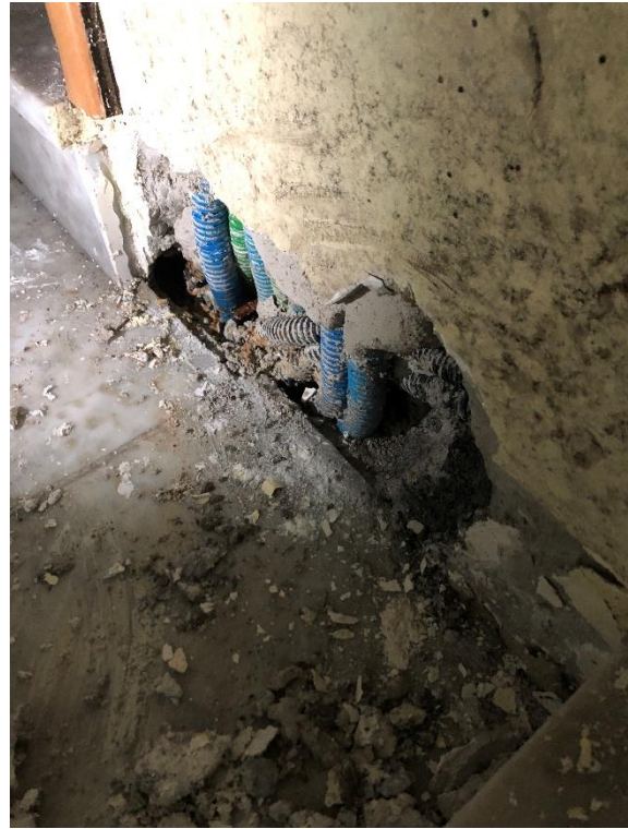
Saggi effettuati sulla muratura per l'individuazione del punto di rottura della tubazione e fuoriuscita di acqua che affiora in corrispondenza dello scalino di collegamento con il lotto adiacente
