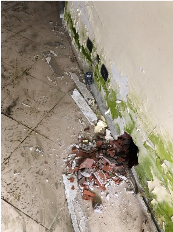
Parete interessata da degrado della finitura dell'intonaco e perdita di materiale (a seguito di saggi effettuati per la ricerca del punto di rottura della tubazione privata)
