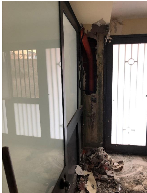
Degrado della parete in corrispondenza della colonna condominiale di scarico interessata dalla rottura
