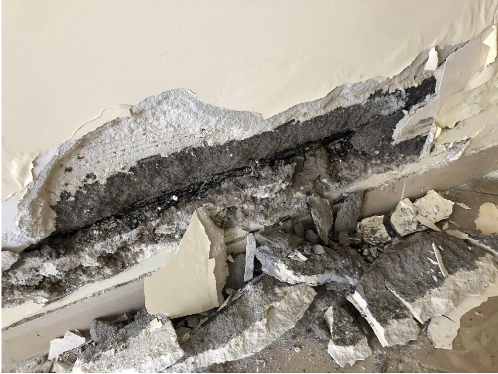
Saggi effettuati per la ricerca del punto di rottura della tubazione privata
