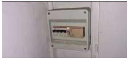
All'interruttore magnetotermico-differenziale sono collegati conduttori, che raggiungono, tramite corrugati sottotraccia, il quadro elettrico di distribuzione. Il quadro elettrico è realizzato con un centralino a parete con sportello di chiusura, al cui interno sono presenti un interruttore quadripolare automatico, generale quadro, e vari magnetotermici-differenziali e magnetotermici per la protezione delle varie linee elettriche presenti nel locale.
