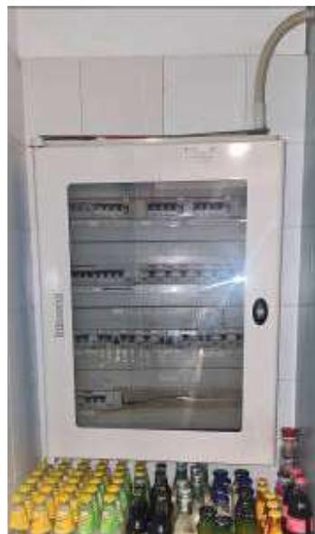
All'interno del bar è altresì presenti un ulteriore quadro elettrico di distribuzione, posizionato all'interno della cucina, posto in una nicchia, ricavata nel muro, al cui interno è presente un quadro elettrico realizzato con un centralino a parete senza sportello di chiusura, al cui interno sono presenti un interruttore quadripolare automatico, generale quadro, e vari magnetotermici-differenziali e magnetotermici per la protezione delle varie linee elettriche presenti nel locale.
