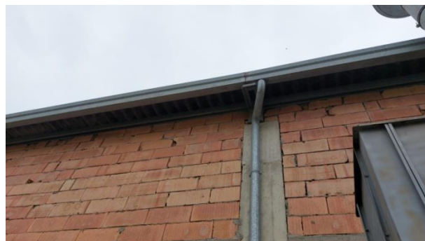
Foto nr.09: esterni immobile
