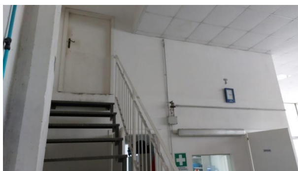
Foto nr.43: interni immobile
