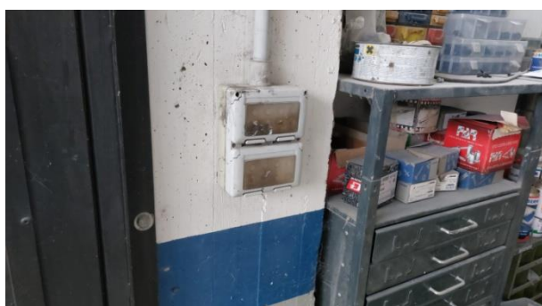
Foto nr.31: interni immobile
