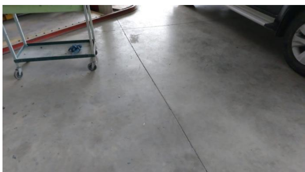
Foto nr.26: interni immobile
