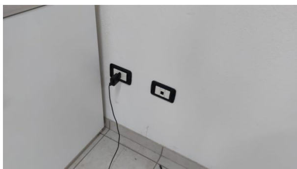
Foto nr.35: interni immobile
