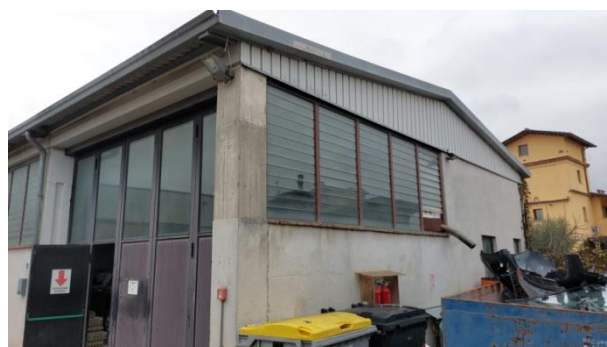
Foto nr.07: esterni immobile
