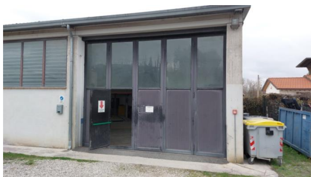
Foto nr.06: esterni immobile
