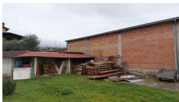
Foto nr.11: esterni immobile
