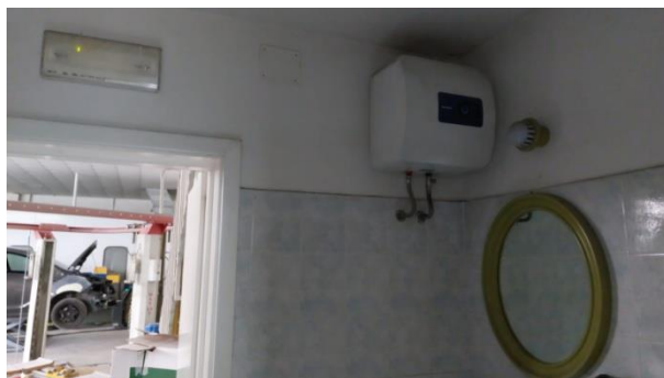
Foto nr.41: interni immobile
