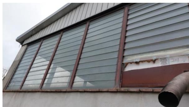
Foto nr.13: esterni immobile
