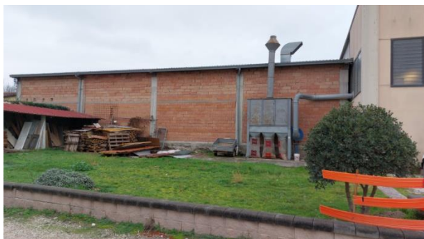
Foto nr.08: esterni immobile
