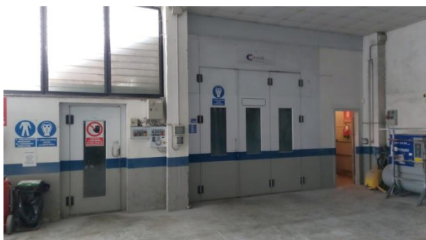
Foto nr.20: interni immobile
