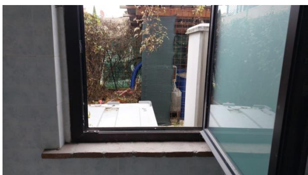
Foto nr.42: interni immobile
