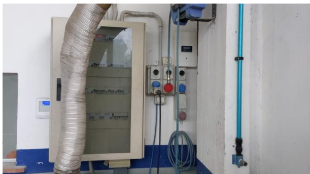
Foto nr.32: interni immobile
