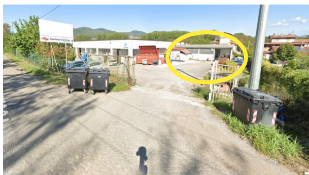
Foto nr.04: esterni immobile
