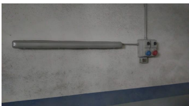
Foto nr.30: interni immobile
