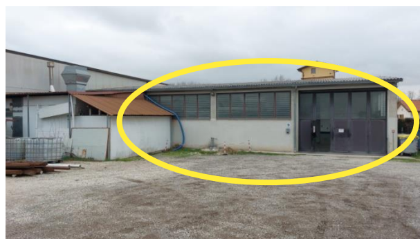
Foto nr.05: esterni immobile
