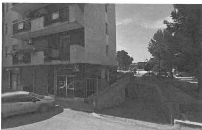
Foto n°4 la rampa di accesso al iano interrato
