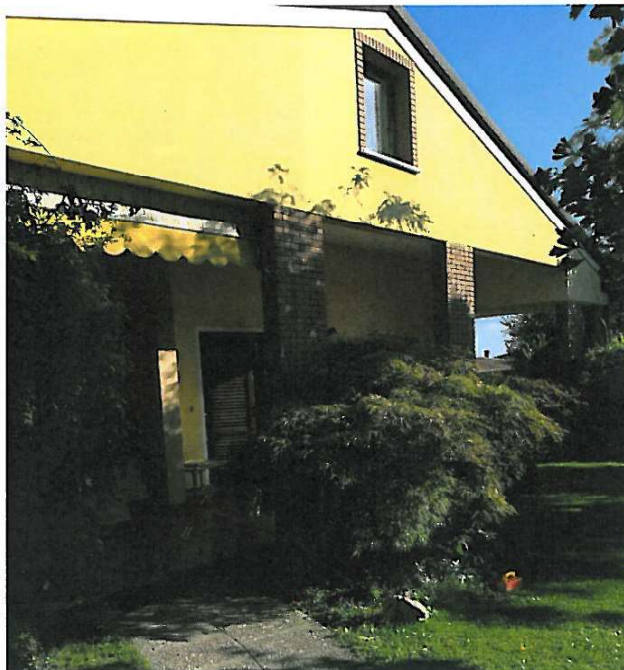
Foto 1 – Facciata principale angolo nord - ovest
