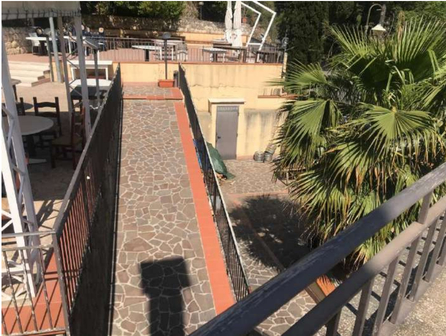
Foto n.45 Magazzino B: accesso dall'area esterna pertinenziale
