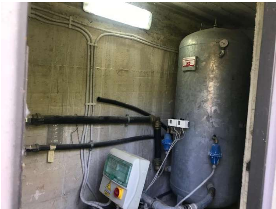
Foto n.49 Locale tecnico – corpo D
