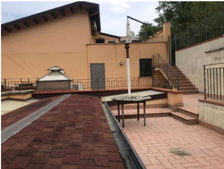
Foto n.30 Ingresso unità immobiliare A.7
