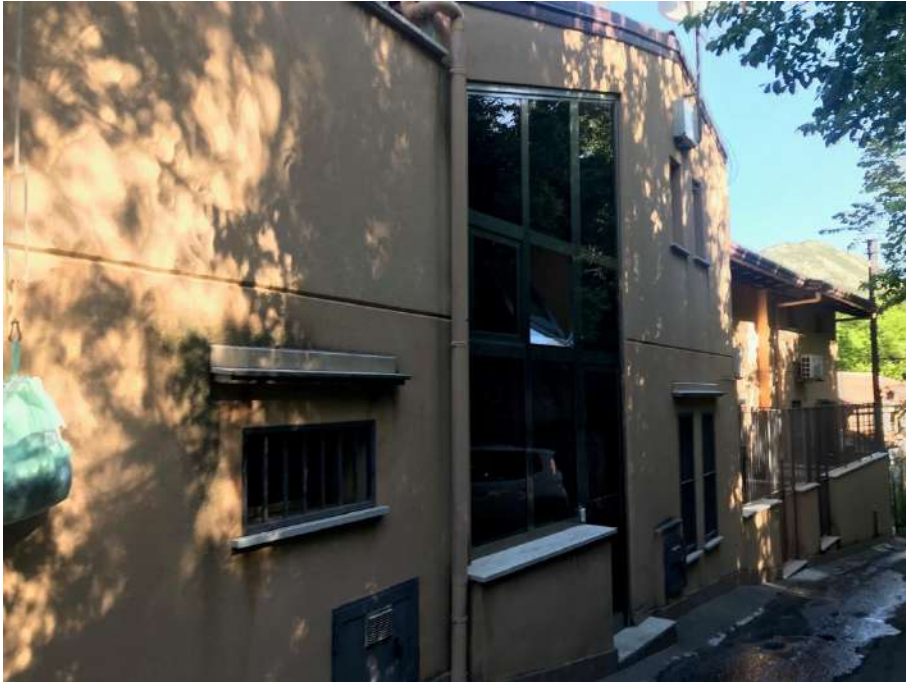
Foto n.19 Prospetto fabbricato principale su via Monreale
