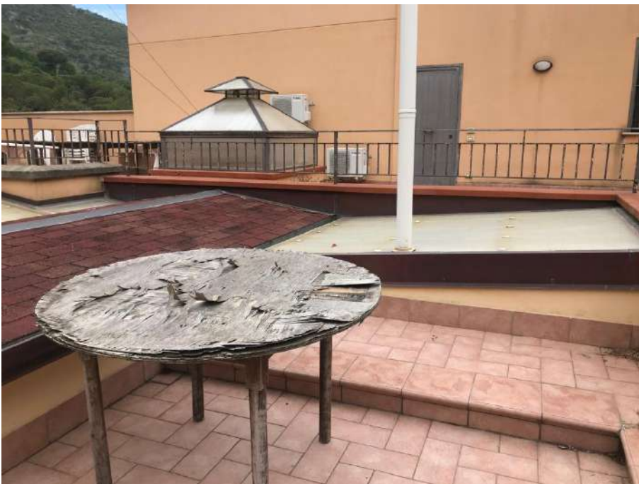
Foto n.54 Aree esterne terrazzate
