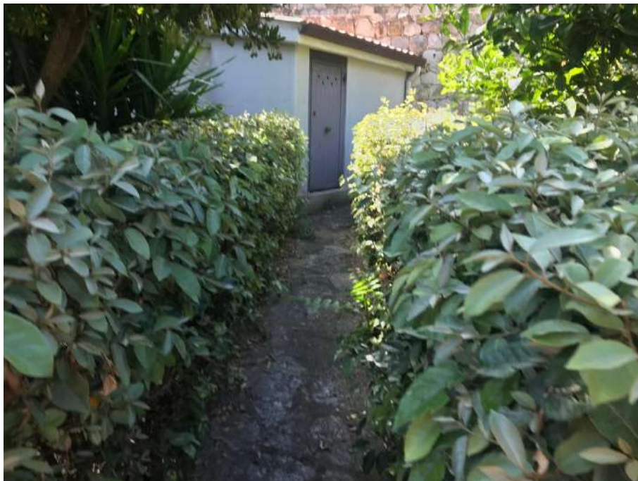
Foto n.48 Locale tecnico – corpo D
