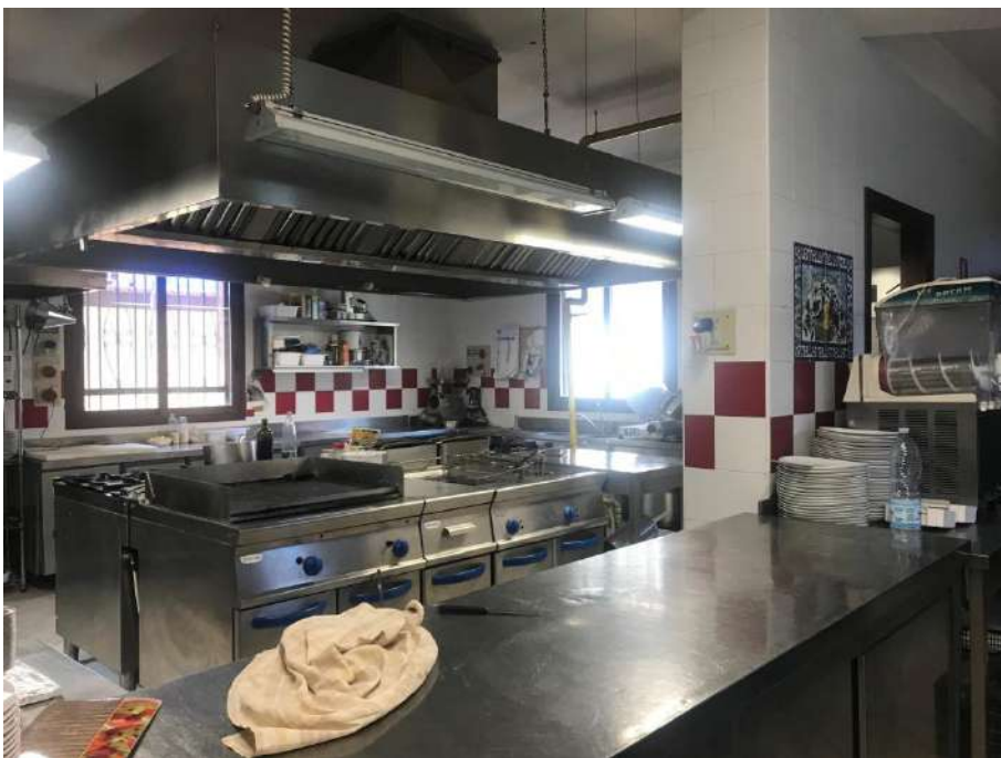
Foto n.6 Locale ristorante bar pizzeria A.1: la cucina
