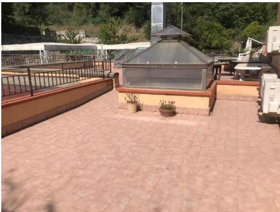
Foto n.55 Aree esterne terrazzate
