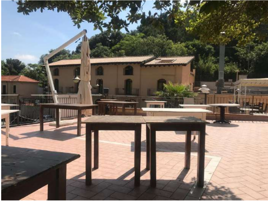
Foto n.1 Fabbricato principale visto dalle aree pertinenziali
