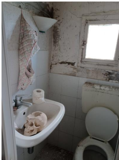
5. FOTO APPARTAMENTO BAGNETTO PT
