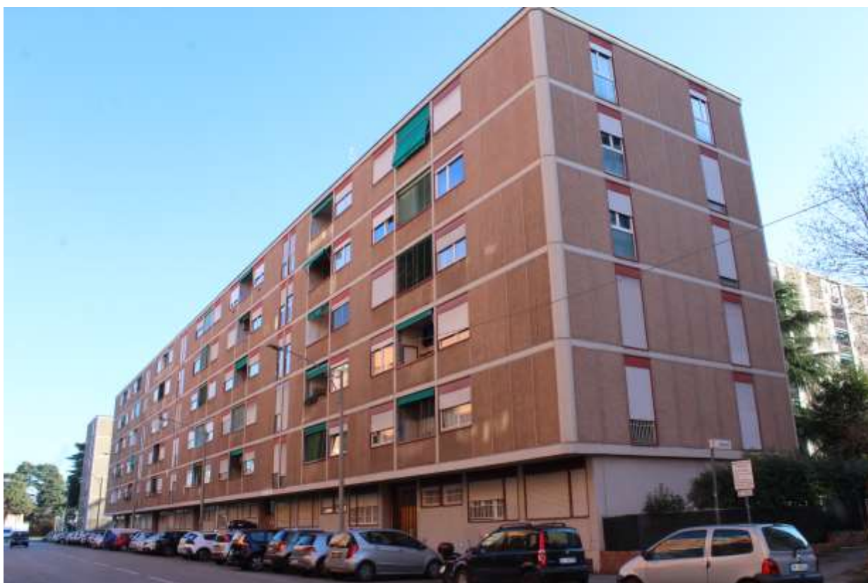
Fabbricato via Napoli, Bologna – Prospetto principale nord-ovest
