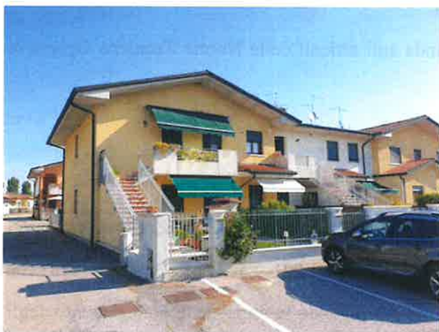
Area urbana a parcheggio fronte strada
