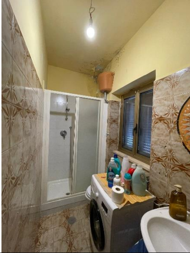
Bagno piano primo
