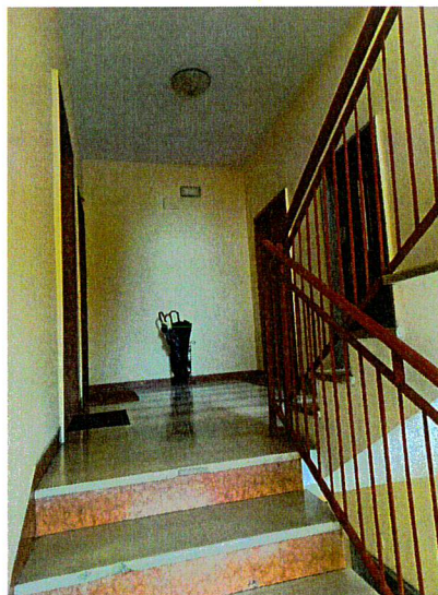
Fig. 13 – Vano scala condominiale
