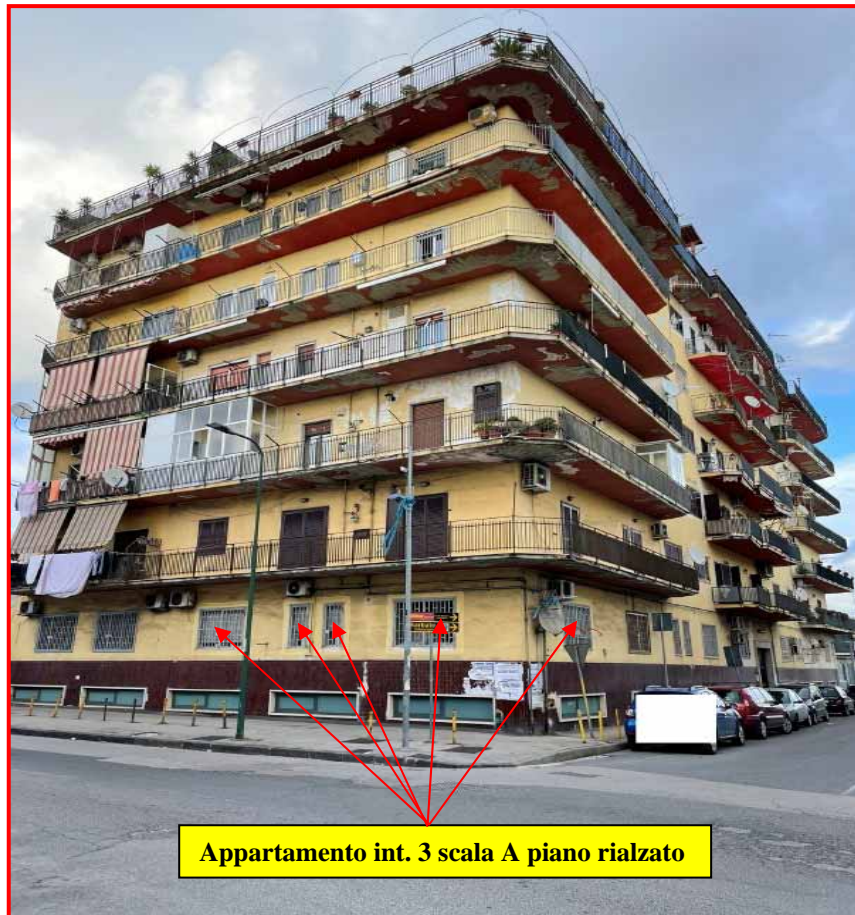
Fabbricato ubicato al Viale Delle Industrie n. 1 – Casavatore (NA)
