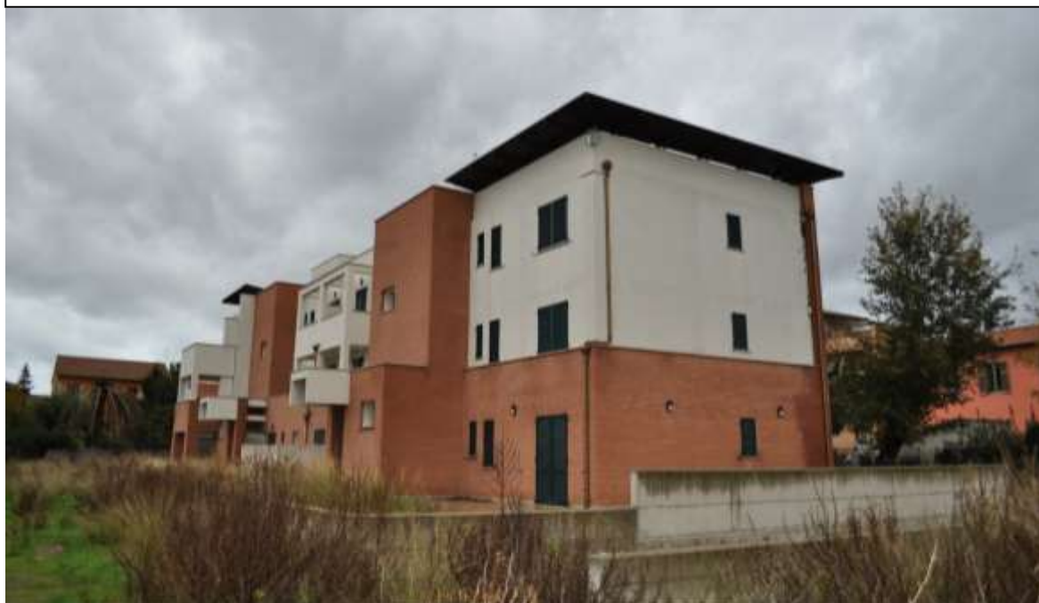
VISTA DEL FABBRICATO U.M.I. 7
