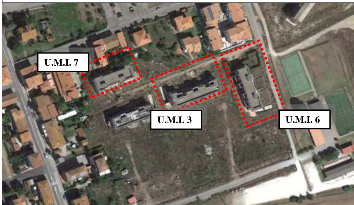
LOCALIZZAZIONE FABBRICATI: VISTA AEREA - mappa Google Earth
