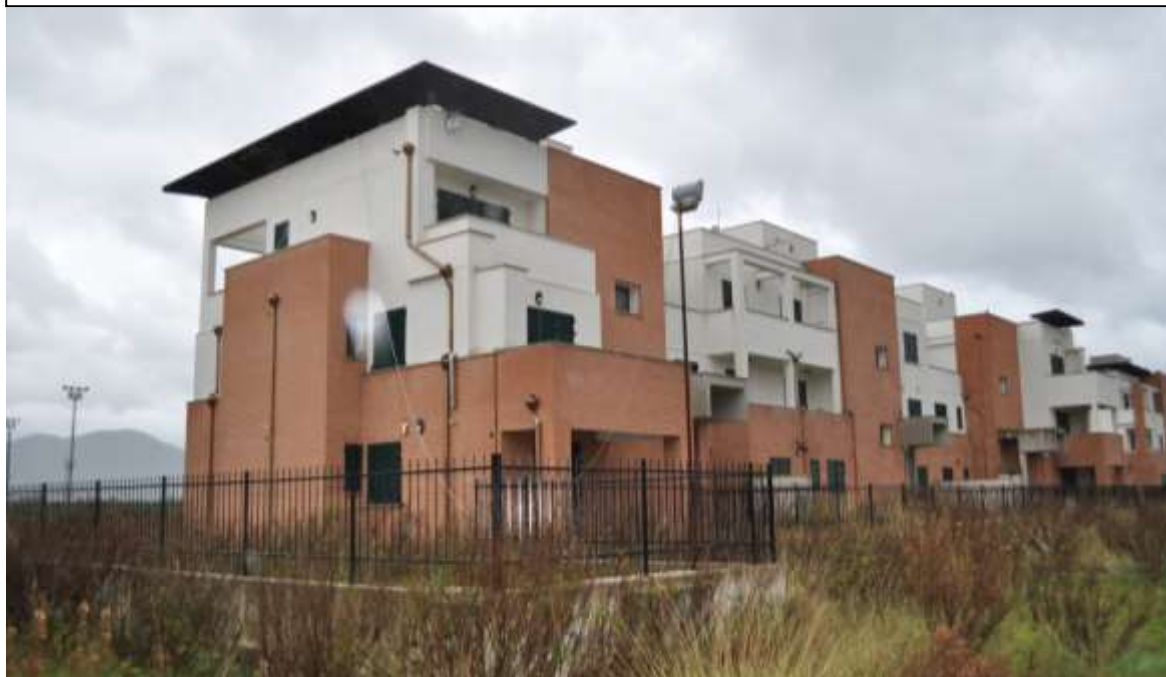
VISTA DEL FABBRICATO U.M.I. 3
