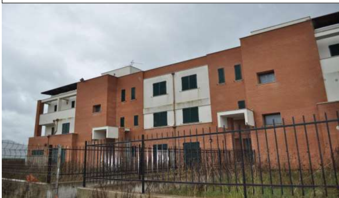
VISTA DEL FABBRICATO U.M.I. 6 SU VIA RODOLFO MORANDI – Google Street View
