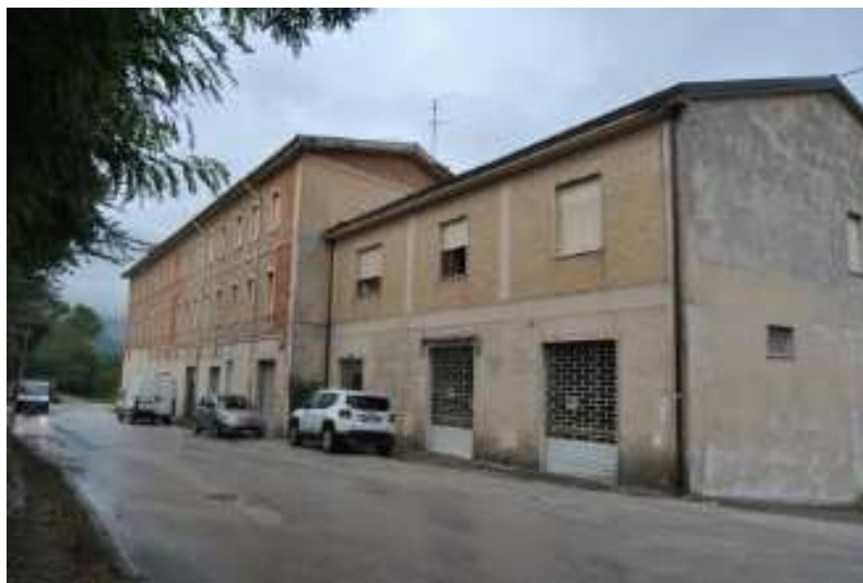
Foto 3 – Lotto 1, corpo A, Vista dalla pubblica strada, prospetto lato NORD/OVEST
