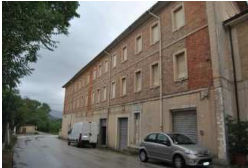
Foto 2 – Lotto 1, corpo A, vista dalla pubblica strada, prospetto lato NORD
