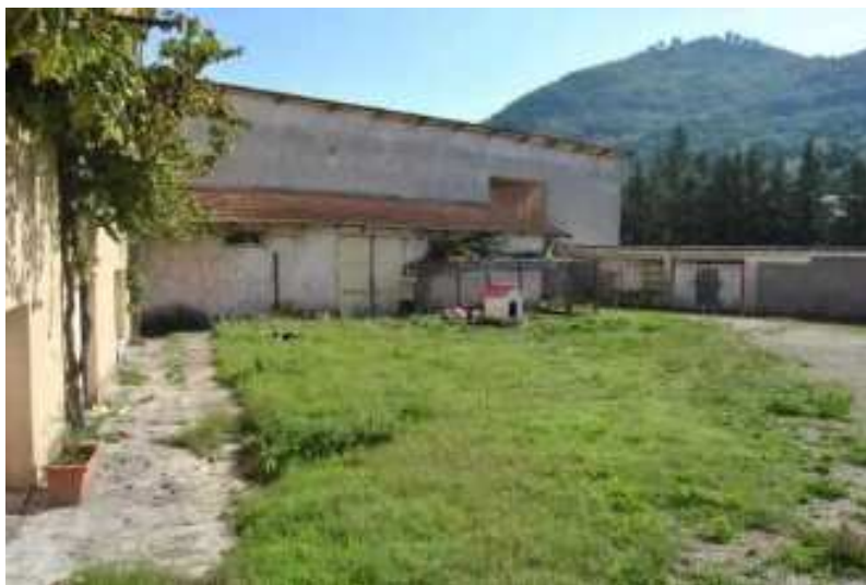
Foto 12 – Lotto 1, corpo B e C, vista dall'interno della particella 637, prospetto lato OVEST
