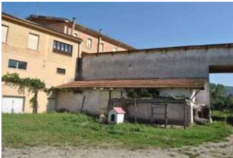
Foto 11 – Lotto 1, corpo B, vista dall'interno della particella 637, prospetto lato OVEST
