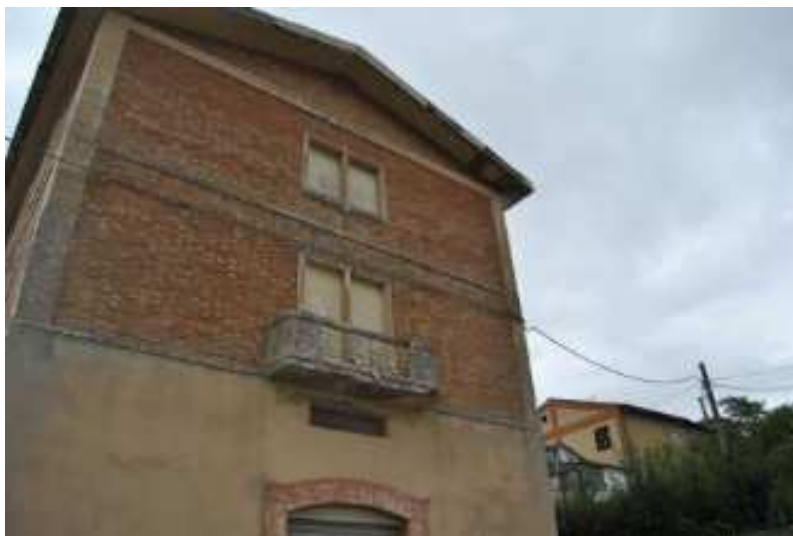
Foto 6 – Lotto 1, corpo A, vista dall'interno della corte, prospetto lato NORD/EST
