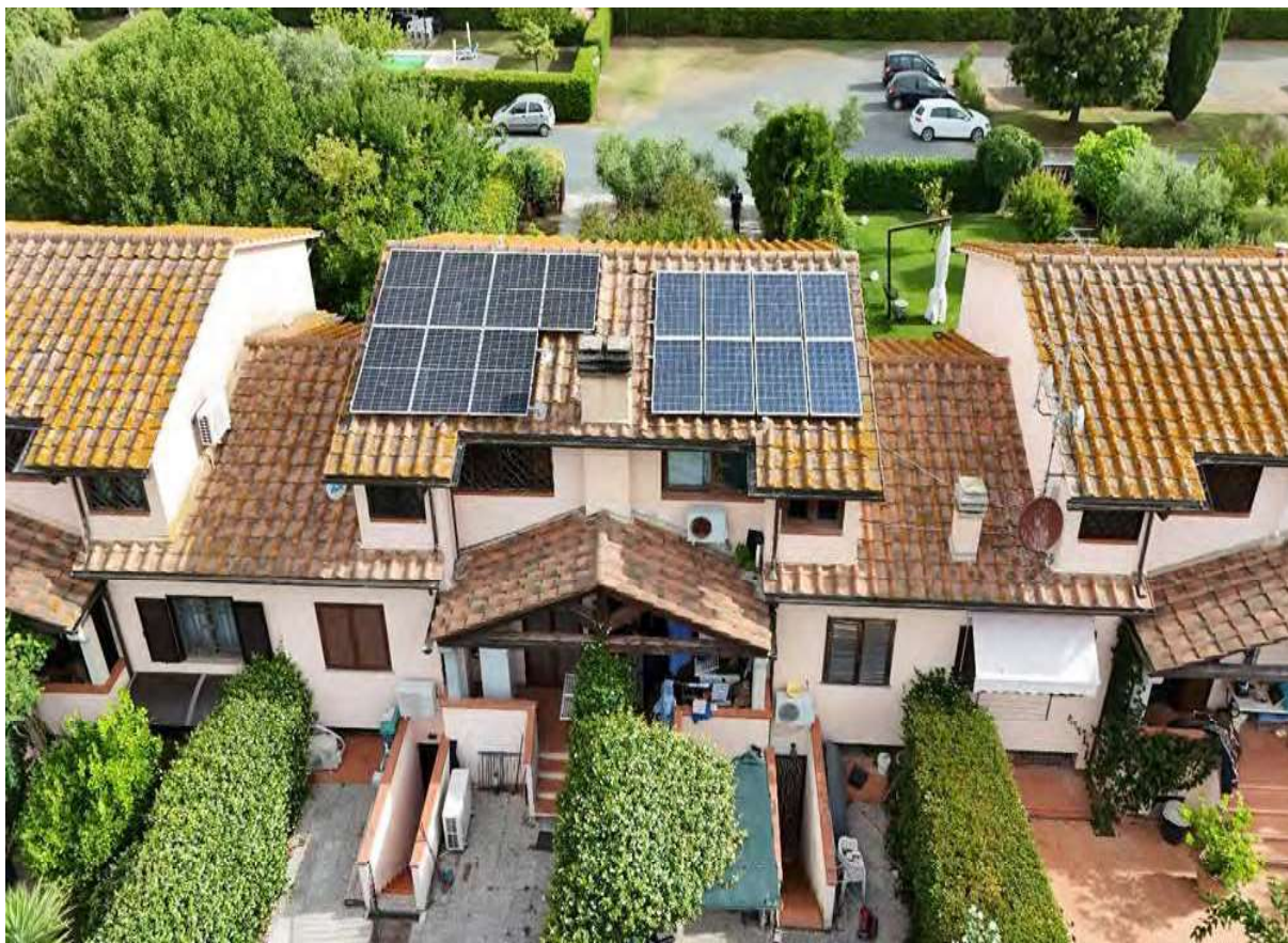
Foto n° 2 Prospetto retro dell'immobile
