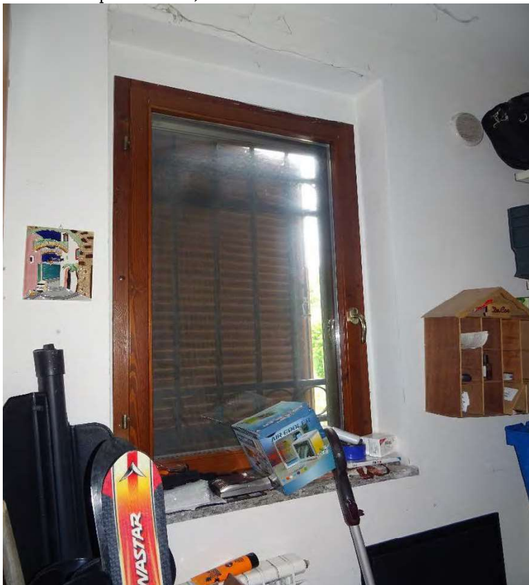
Foto n° 33 piano terra, ripostiglio
