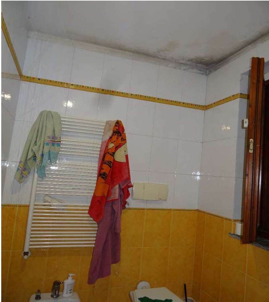
Foto n° 32 piano terra, w.c.
