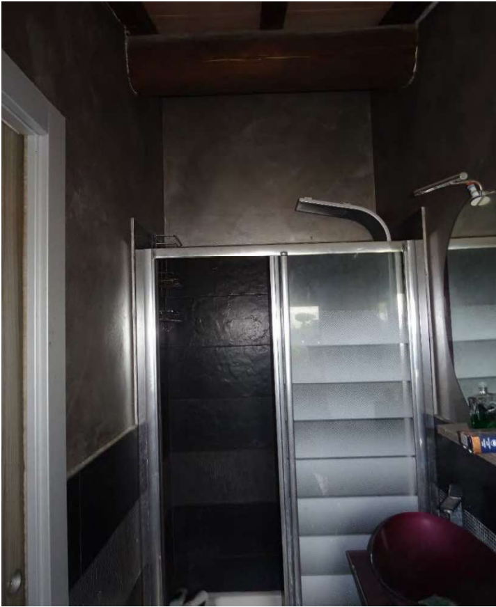
Foto n° 42 piano primo, w.c.
