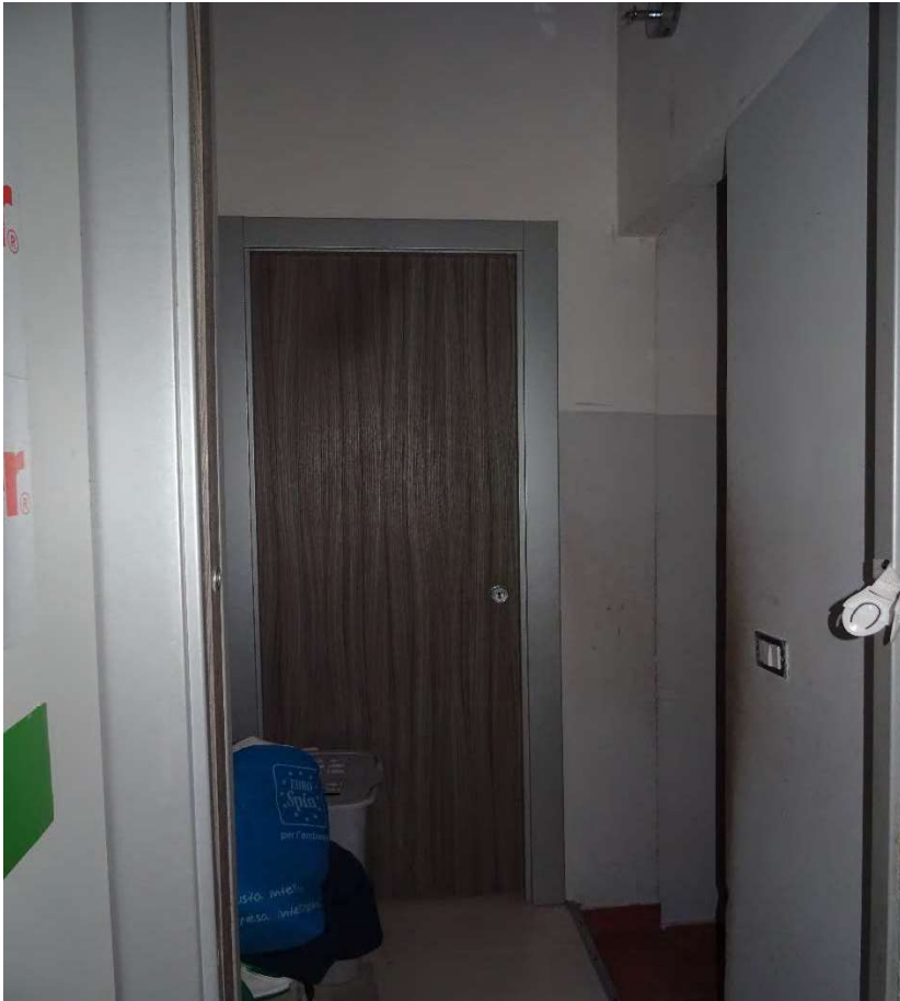
Foto n° 36 piano primo, disimpegno, ingresso: camere, w.c. e ripostiglio
