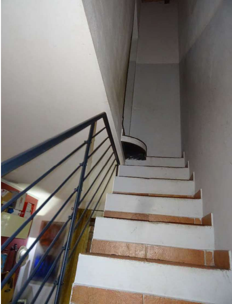
Foto n° 34 piano terra, scala di accesso al piano primo
