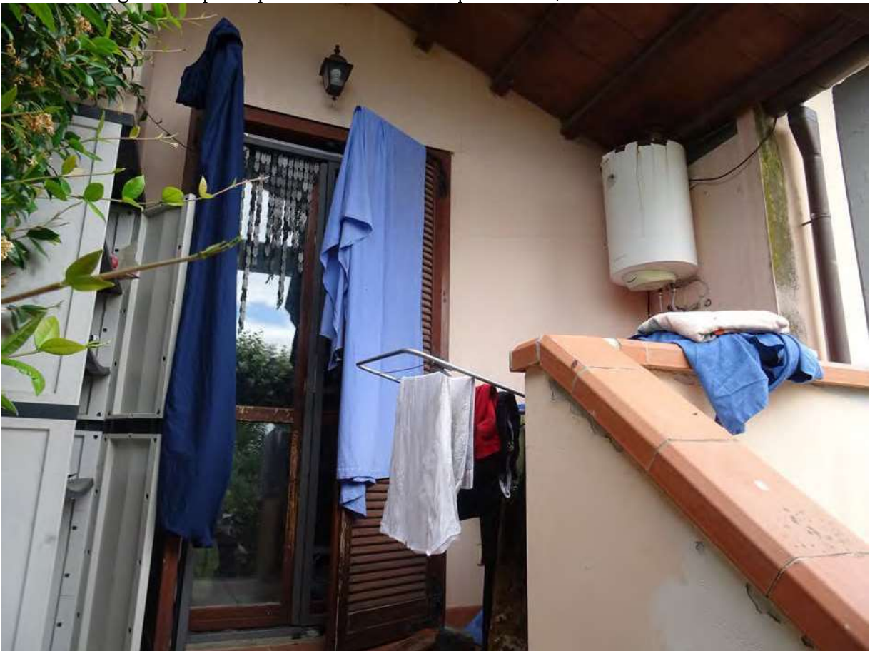
Foto n° 13 ingresso (Particolare) al piano terra, dal retro
