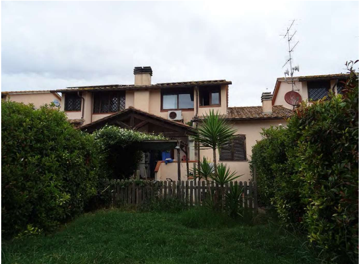
Foto n° 14 Vista ingresso dal giardino sul retro
