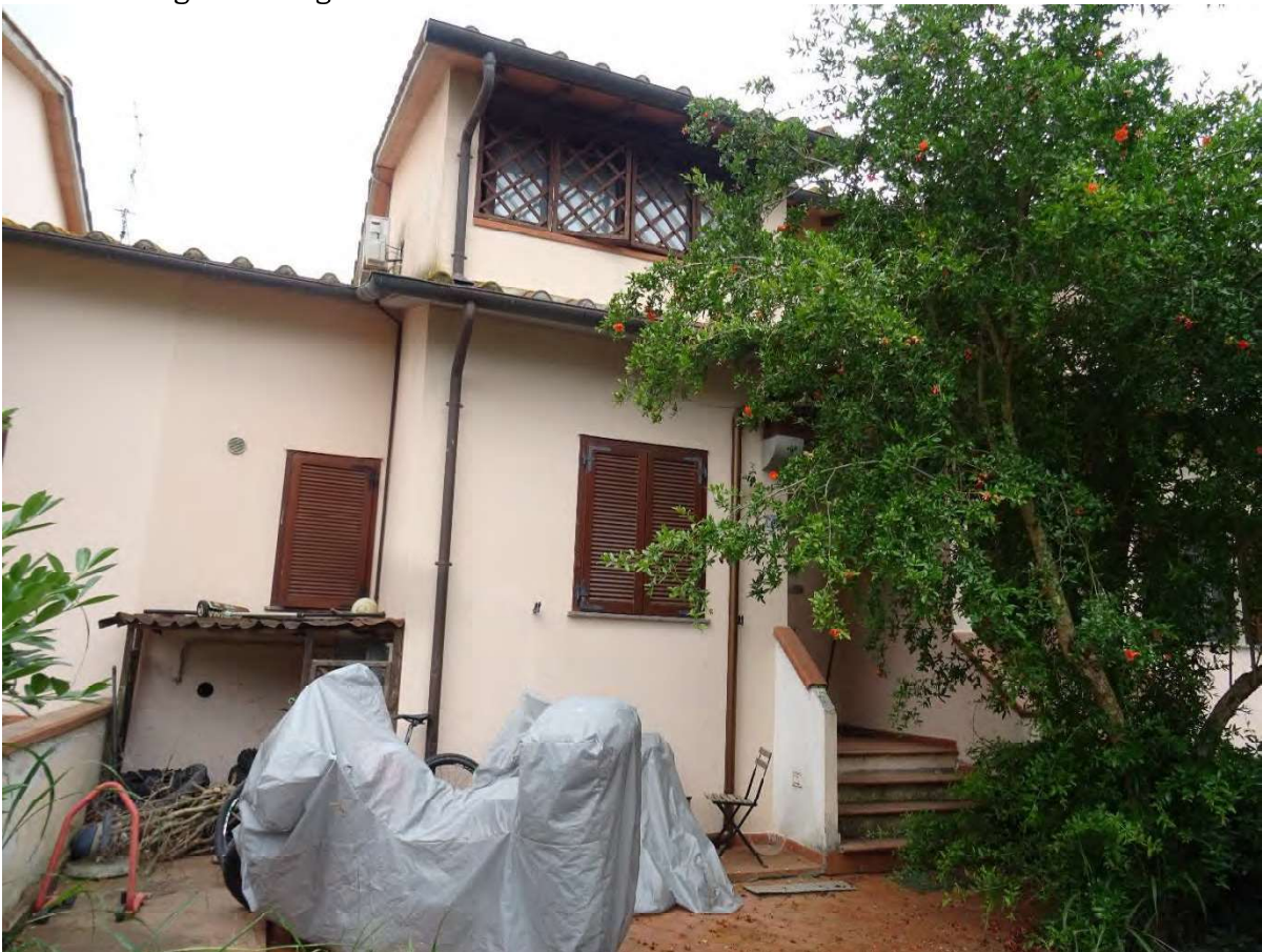
Foto n° 11 ingresso piano terra
