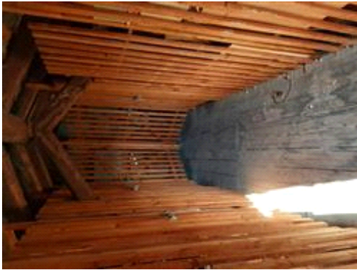
Vista disimpegno di accesso alla soffitta
