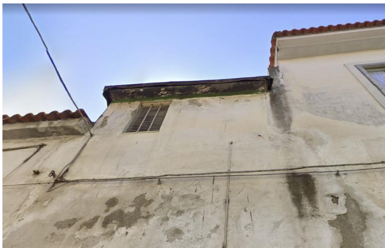
ESTERNO TERMINALE SUB 15/BAGNO LATO STRADA
