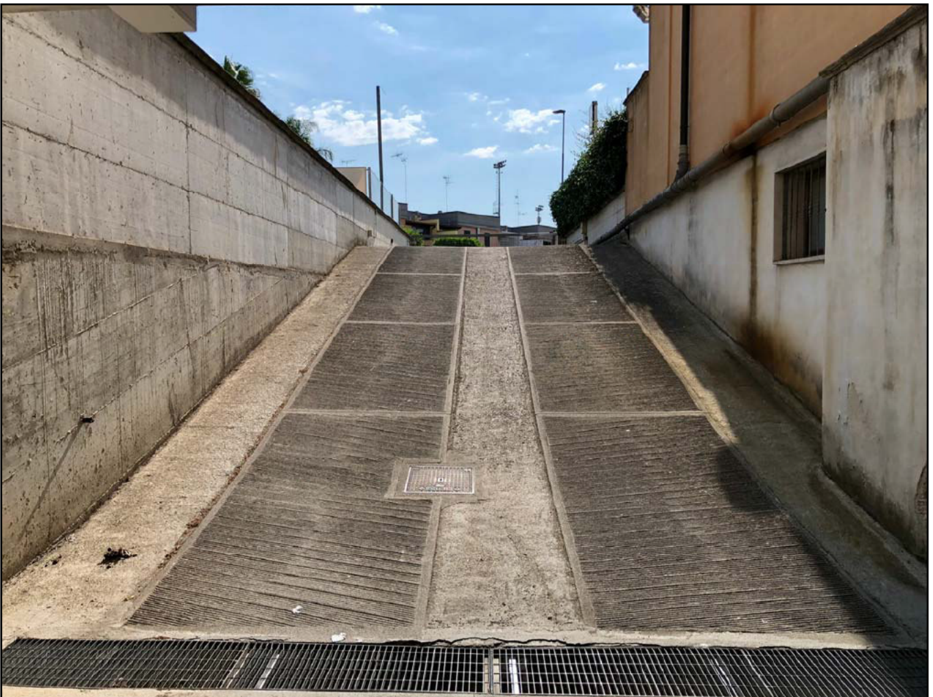
rampa di accesso al box al p. interrato
