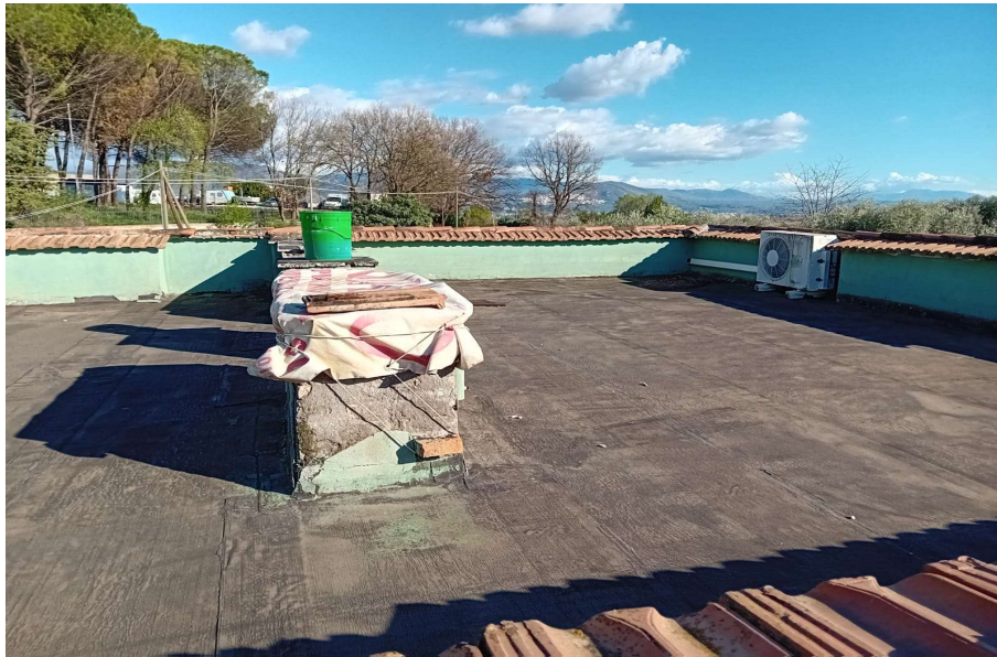
il terrazzo di copertura
