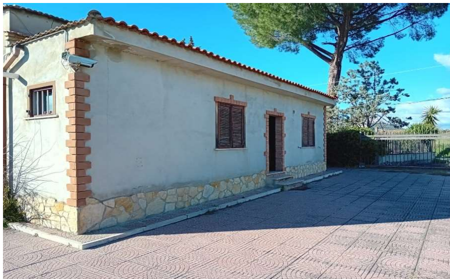
il prospetto d'ingresso
