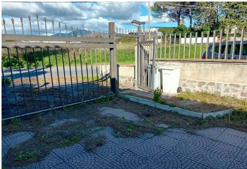
il cancello d'ingresso al lotto
