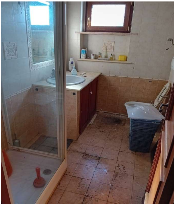
il bagno all'ingresso con particolare delle infiltrazioni dal solaio di copertura
