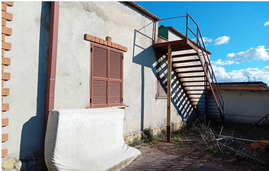
la scala di accesso al terrazzo di copertura
