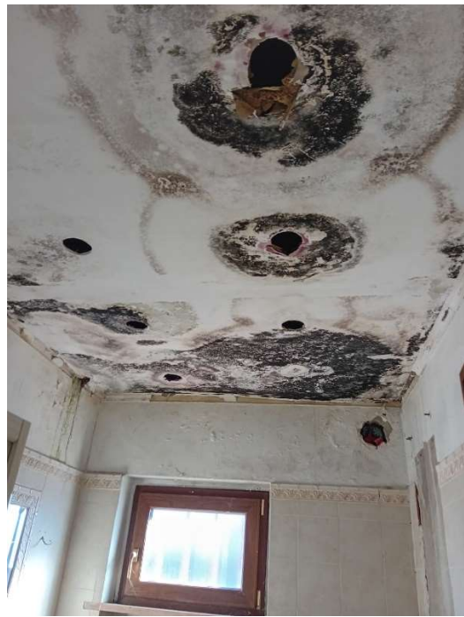
il bagno all'ingresso con particolare delle infiltrazioni dal solaio di copertura
