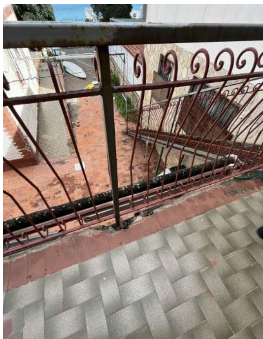
Foto 55 - B.C.N.C. costituente il corpo j
