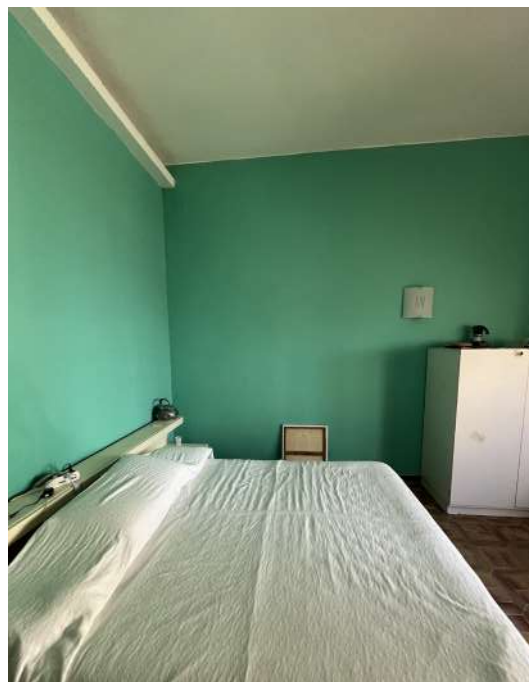
Foto 30 - Vano a debito a Camera 2 (piano primo)
