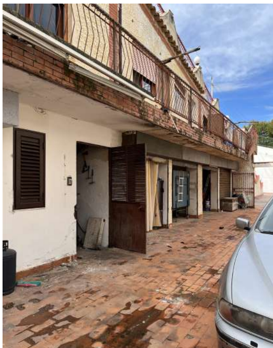
Foto 33 - Porta di accesso al locale tecnico
