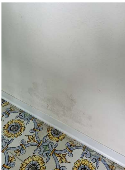
Foto 28 - Ammaloramenti su parte basamentale
