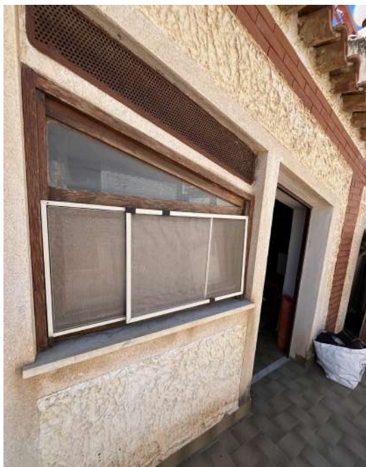
Foto 49 - Porta di accesso al corpo h
