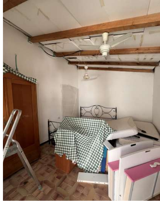
Foto 46 - Vano adibito a camera
