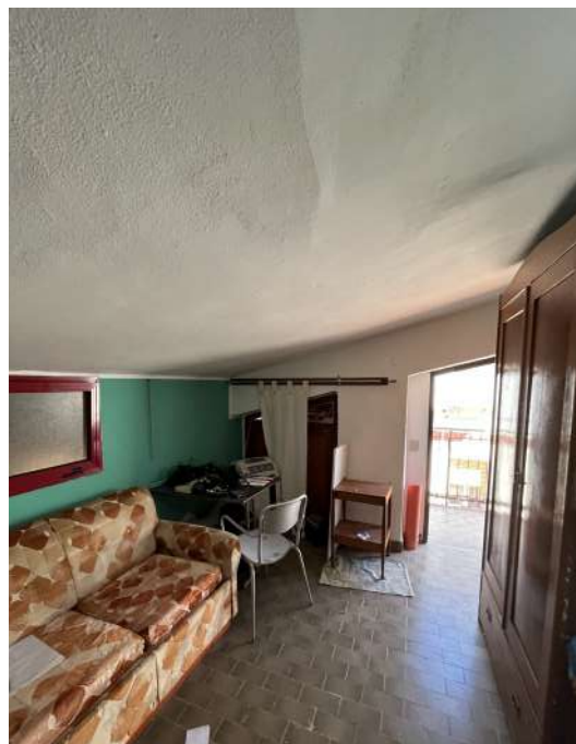
Foto 50 - Vano adibito a camera
