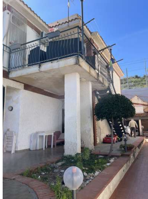
Foto 6 - Fabbricato in cui ricade, al piano terra, il Corpo a
