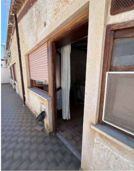
Foto 45 - Accesso al corpo g
