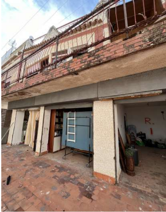
Foto 29 - Fabbricato in cui sono presenti i corpi di pertinenza (b-c-d-e-f-g-h-i-j)
