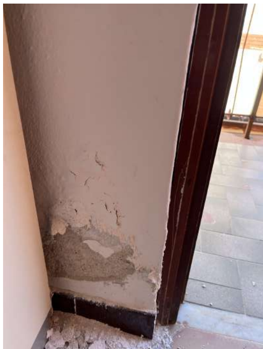
Foto 29 - Ammaloramenti su parte basamentale
