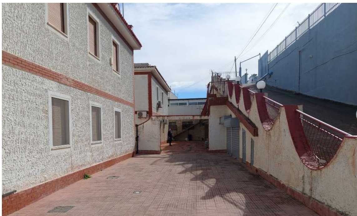
Foto 3 - Corte che immette al Lotto Unico
