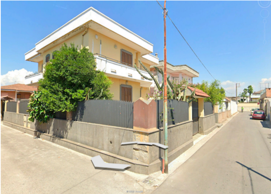
Foto n.1 – Panoramica fabbricato lato strada
