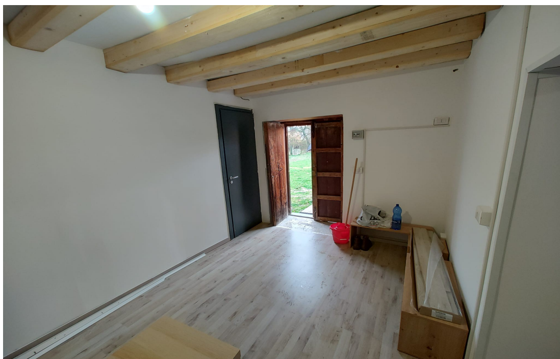
FOTO N. 4 – FABBRICATO – VANO INGRESSO
