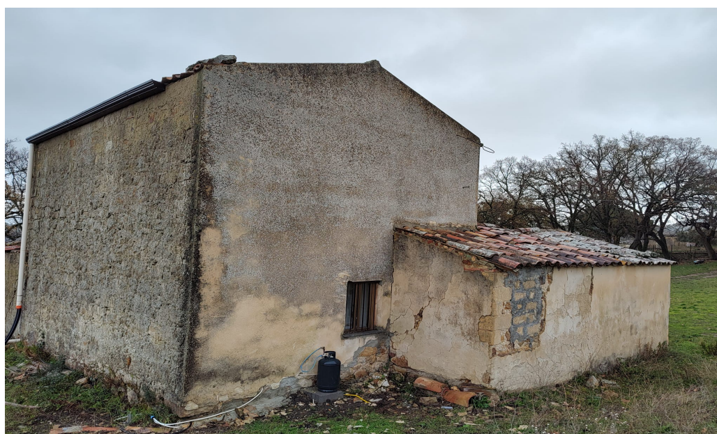
FOTO N. 2 – FABBRICATO - PROSPETTO POSTERIORE
