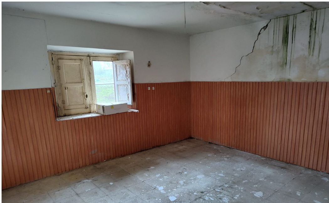
FOTO N. 3 – FABBRICATO – VANO LATO OVEST
