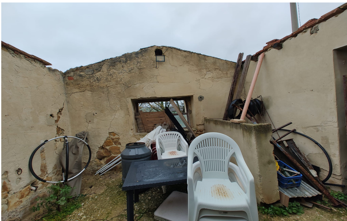
FOTO N. 7 – FABBRICATO – VANO LATO EST
