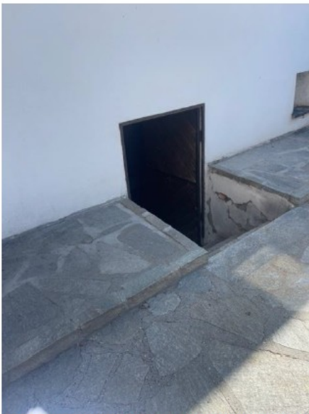
Fig. 6 Accesso a Cantina dal Cortile comune.
