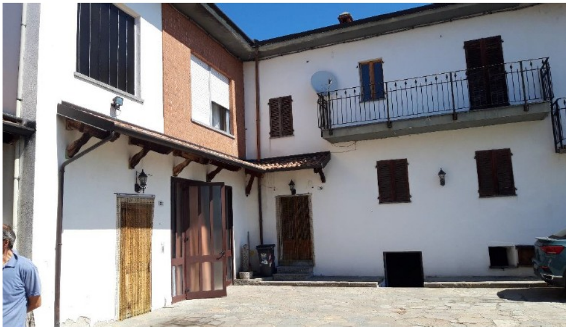
g. 1 Accesso esterno dal cortile comune su Via Santa Lucia n.16
